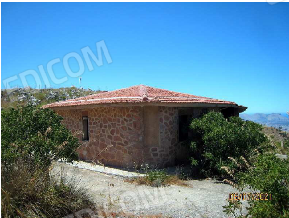
Foto n. 15. Prospetti Sud ed Est.
