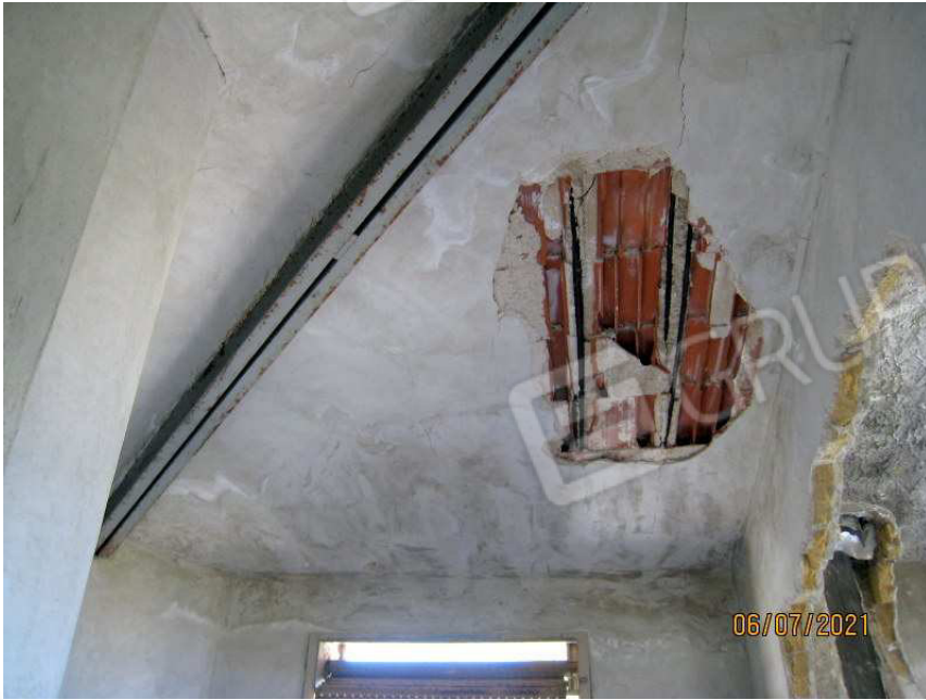
Foto n. 27-29. Tre porzioni del tetto.
