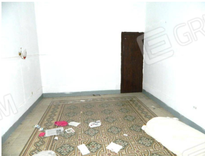
Pavimenti in graniglia di cemento, originali dell'epoca.
