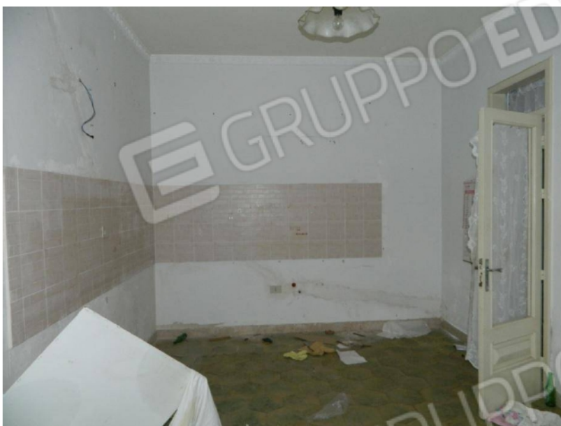
Vano cucina Piano Terra
