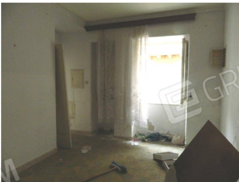
Vano cucina P.T
