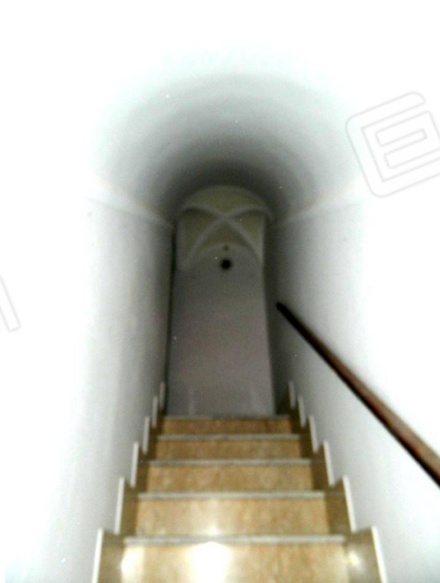
Soffitti a volta con stucco a gesso
