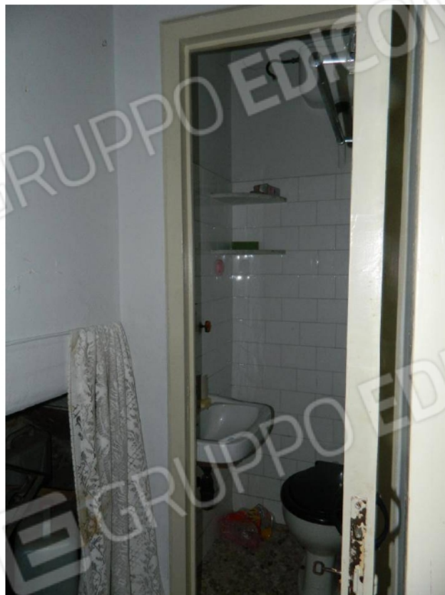
Locale bagno P.T.
