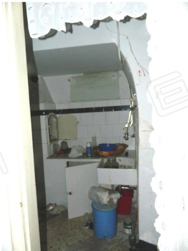
Locale lavanderia P.T.
