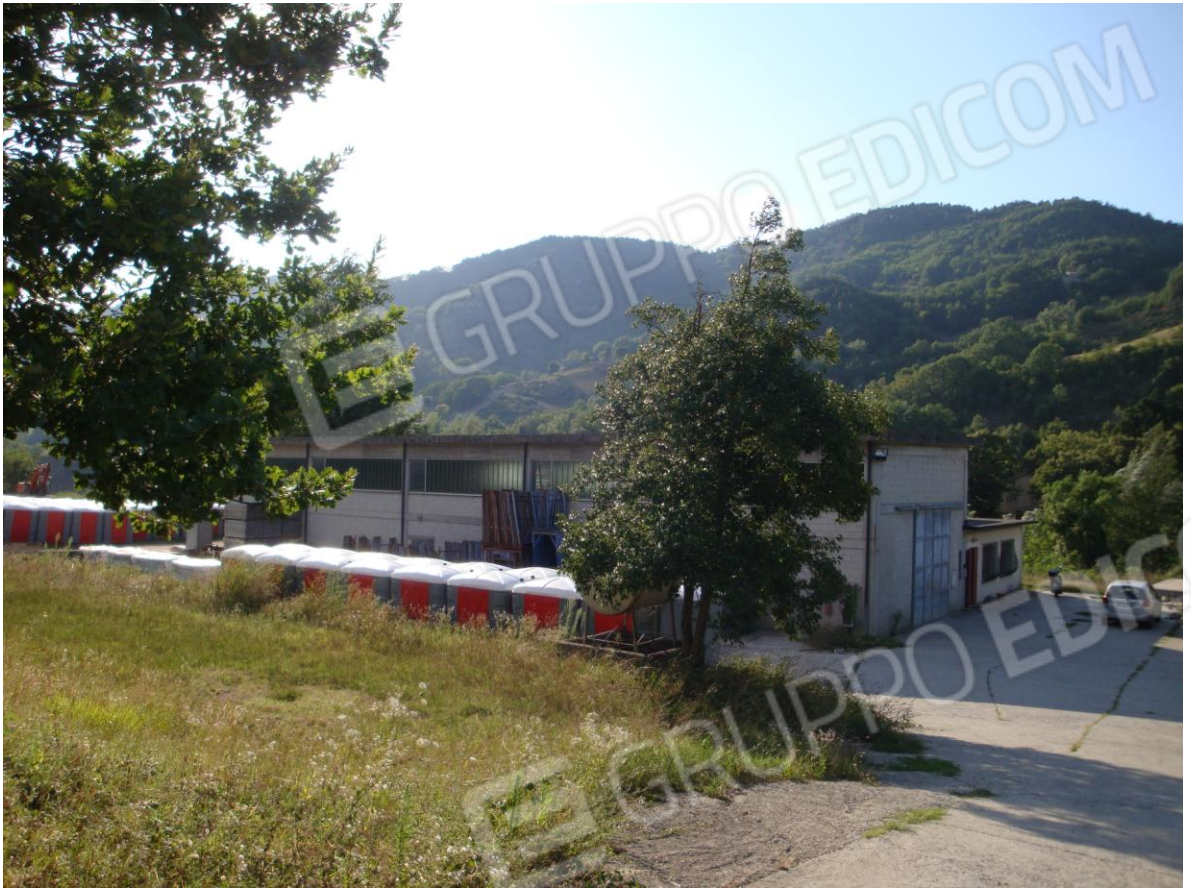
Accesso al lotto, prospetto lato uffici e lato strada SRT302
