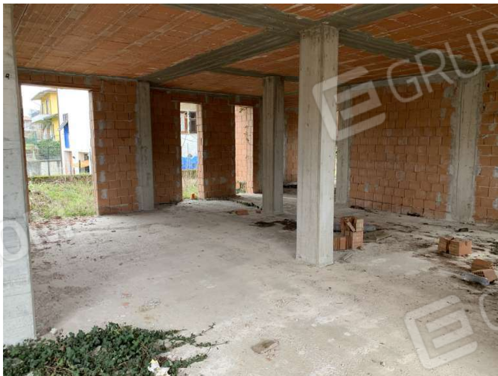
FOTO 10 COMPENDIO IN CORSO DI COSTRUZIONE DI CUI AL FOGLIO 13 MAPPALI 1603 1604 1650
