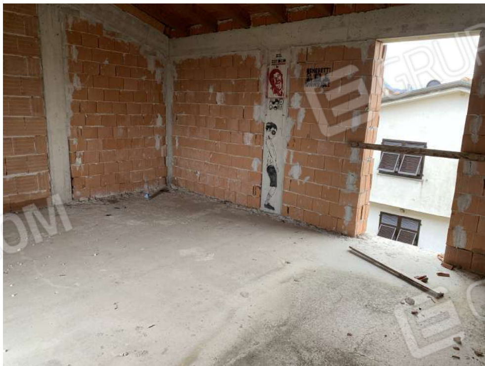
FOTO 12 COMPENDIO IN CORSO DI COSTRUZIONE DI CUI AL FOGLIO 13 MAPPALI 1603 1604 1650
