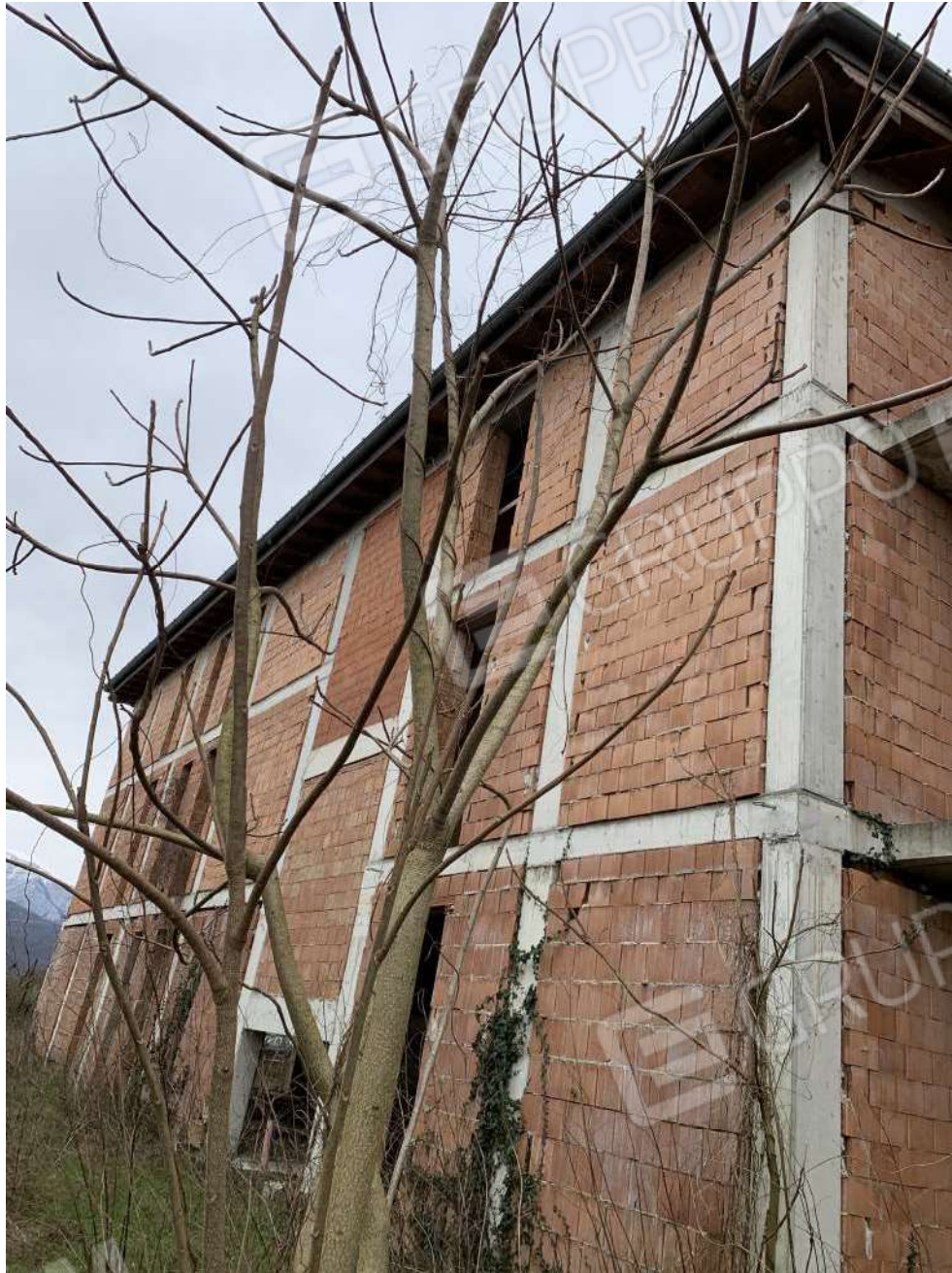
FOTO 6 COMPENDIO IN CORSO DI COSTRUZIONE DI CUI AL FOGLIO 13 MAPPALI 1603 1604 1650
