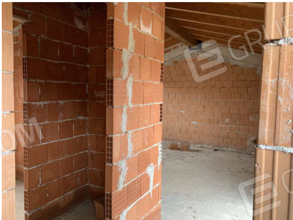
FOTO 14 COMPENDIO IN CORSO DI COSTRUZIONE DI CUI AL FOGLIO 13 MAPPALI 1603 1604 1650
