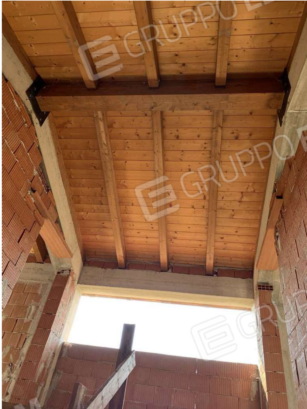
FOTO 8 COMPENDIO IN CORSO DI COSTRUZIONE DI CUI AL FOGLIO 13 MAPPALI 1603 1604 1650
