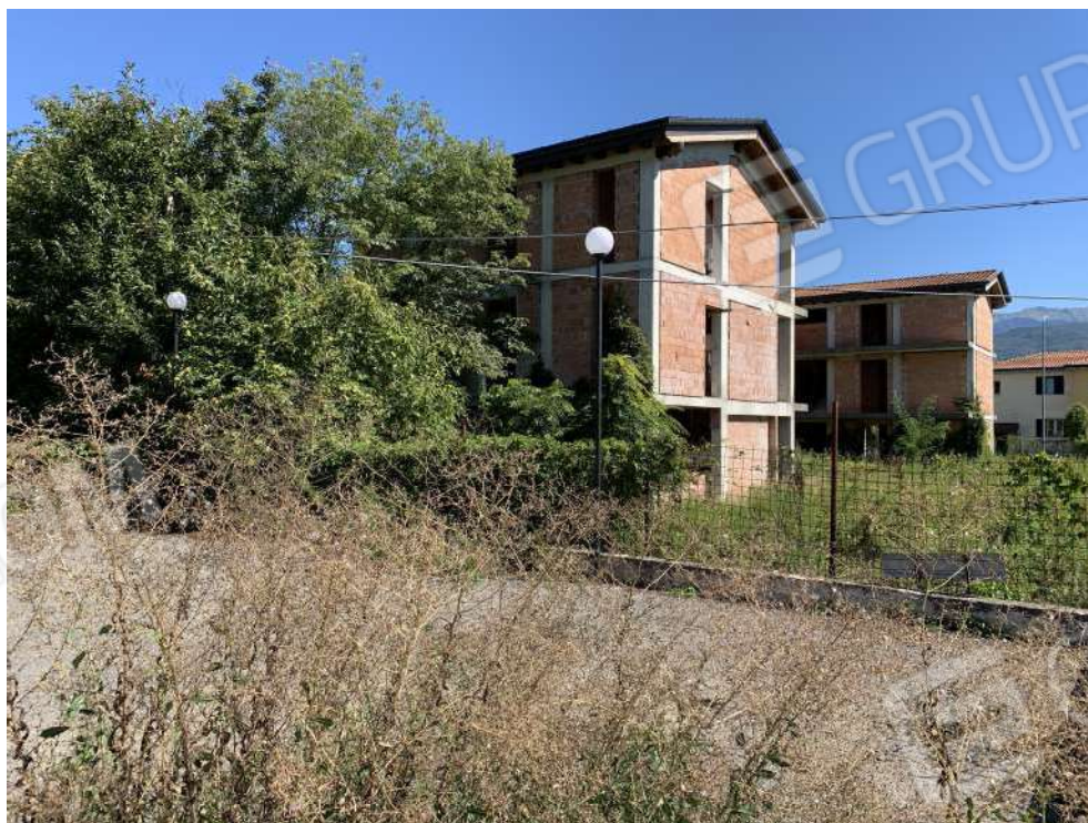
FOTO 4 COMPENDIO IN CORSO DI COSTRUZIONE DI CUI AL FOGLIO 13 MAPPALI 1603 1604 1650
