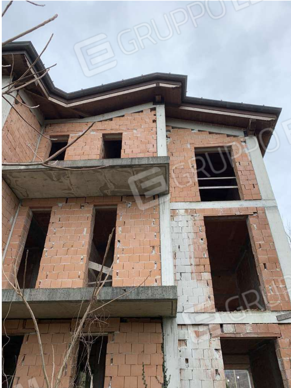
FOTO 5 COMPENDIO IN CORSO DI COSTRUZIONE DI CUI AL FOGLIO 13 MAPPALI 1603 1604 1650
