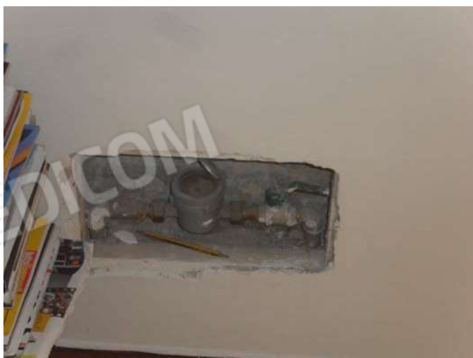
Foto n. 11: Contatore acqua
