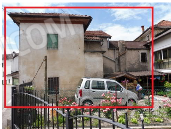
3 -4 Vista dalla strada del lato rivolto a nord-est dell'immobile (confinante con altra proprietà)
