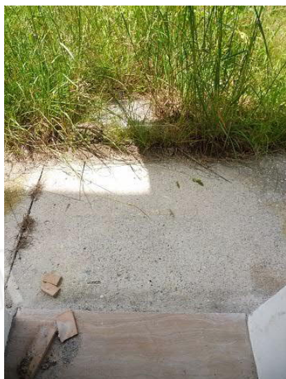
13 Vista del pozzetto posto davanti alla soglia d'ingresso (dalla quale è ripresa l'immagine)
