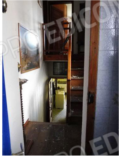
47 Vista dal servizio igienico verso la scala
