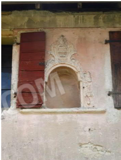
9 - 10 Particolari della facciata sud-ovest
