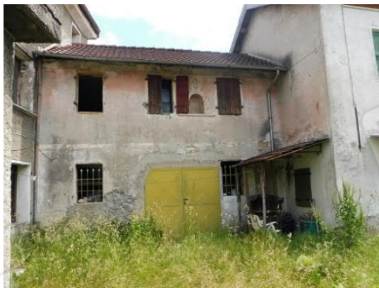
7 La facciata rivolta verso la corte comune
