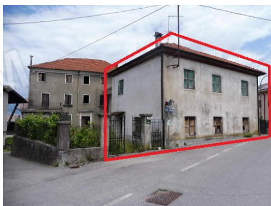
1 Vista dell'immobile dalla strada pubblica
