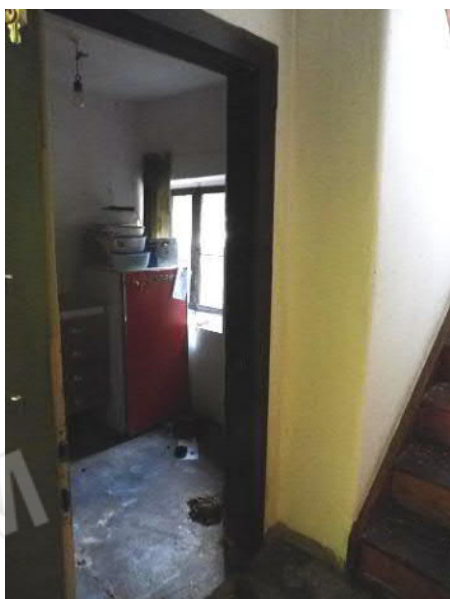
31 Ripostiglio lato scala
