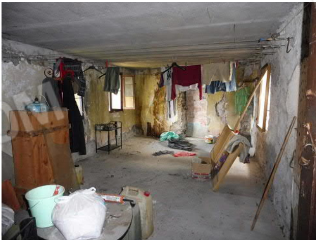
54 - 55 Il locale deposito al 1° piano
