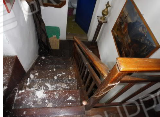
49 Vista del servizio igienico dalla scala
