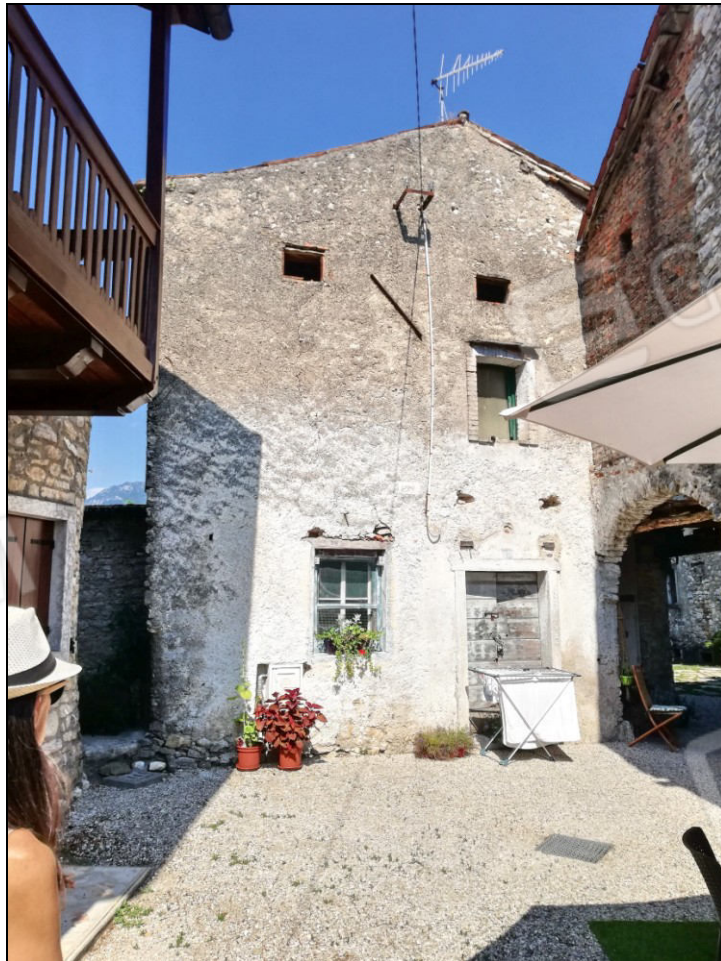
Foto 02 – Fronte ovest su corte comune (mn. 638)
