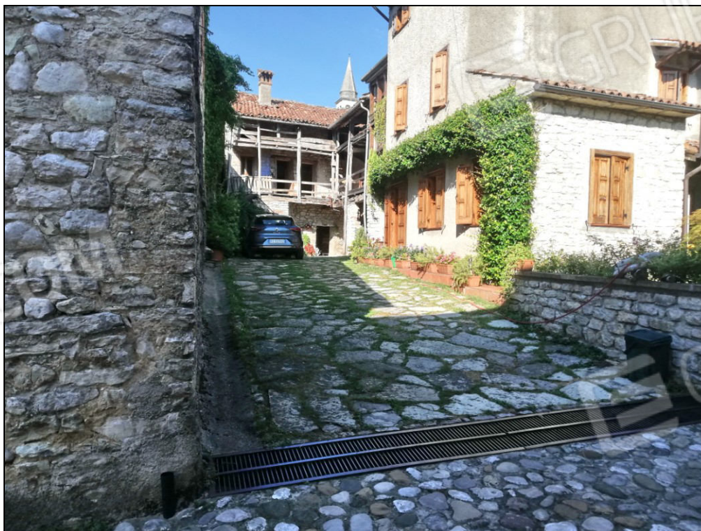
Foto 04 – Corte comune lato sud (mn. 638) da vicolo Bellet
