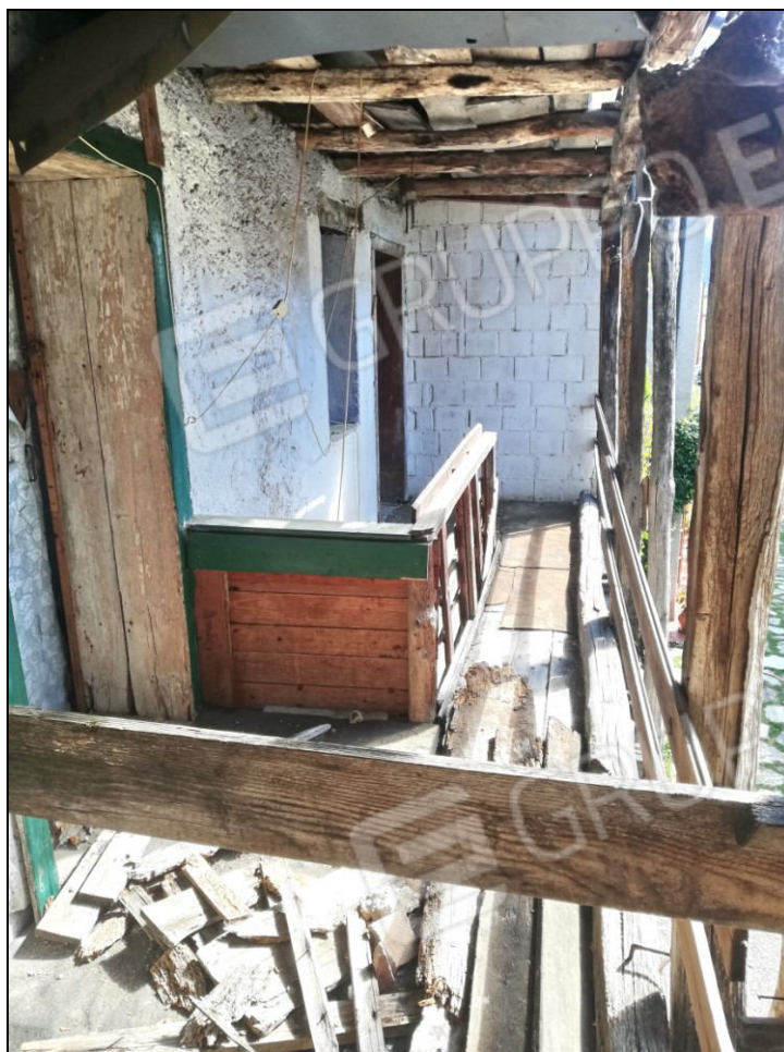
Foto 11 – Ballatoio piano primo
