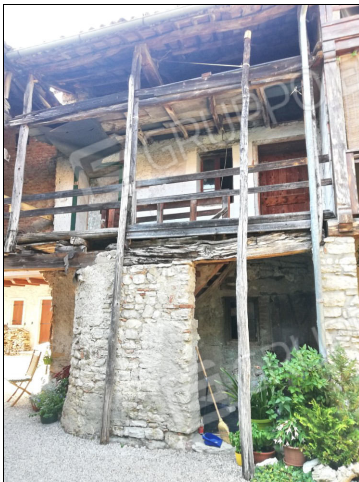
Foto 03 – Fronte sud su corte comune (mn. 638)
