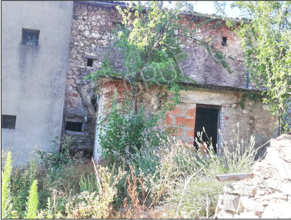
Foto 01 – Fronte nord su corte esclusiva
