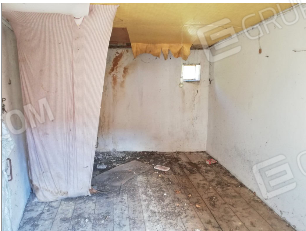
Foto 12 – Camera lato ovest piano primo
