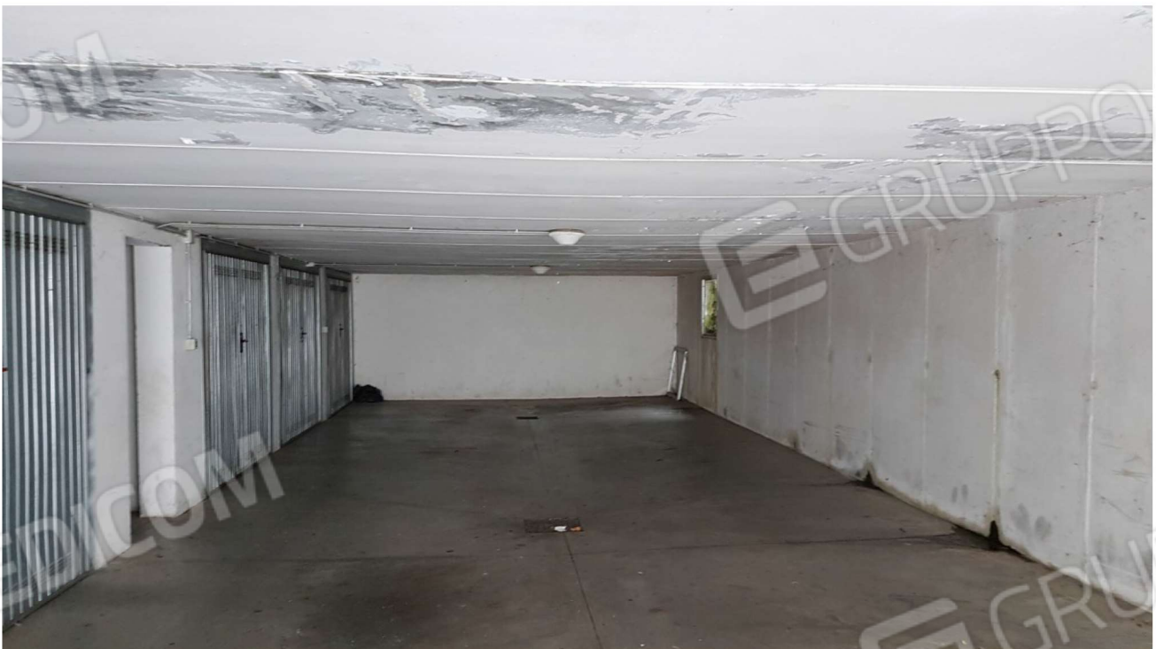
La corsia di manovra al piano interrato
