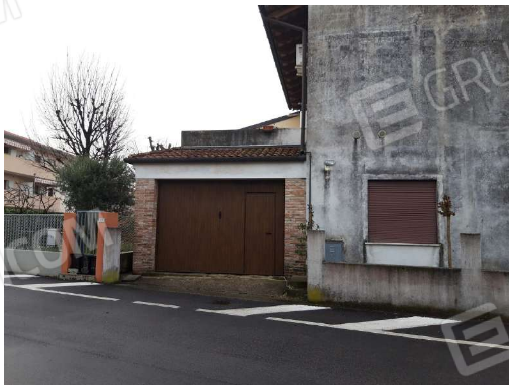
Vista accesso autorimessa
