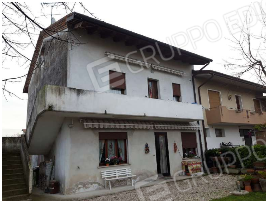
Vista prospetto ovest
