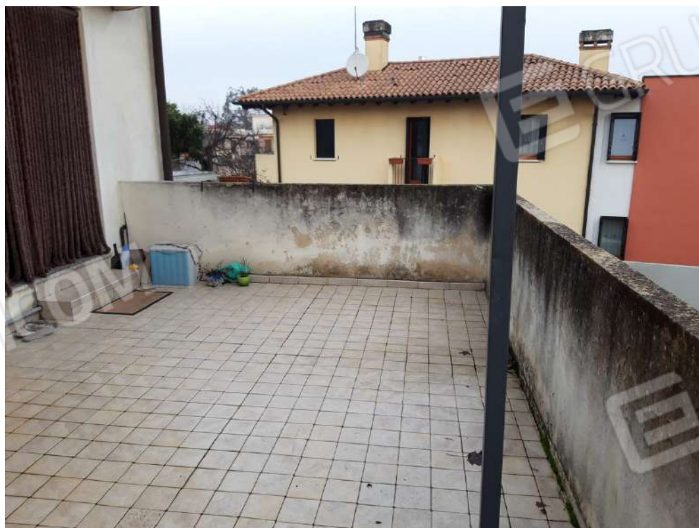
Vista terrazza sul lato est
