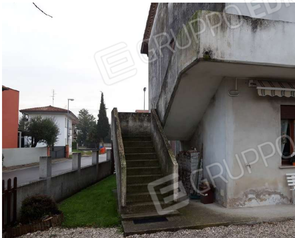
Vista scala di accesso al primo piano
