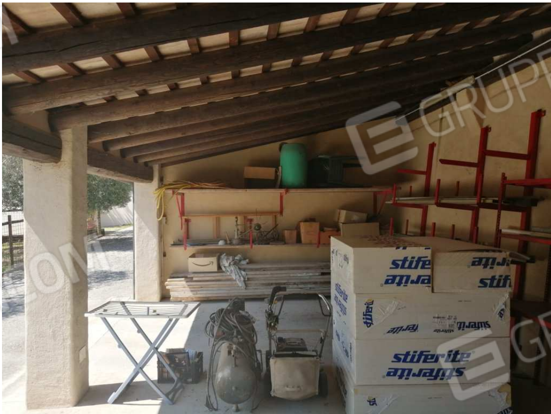
Tettoia vista interna
