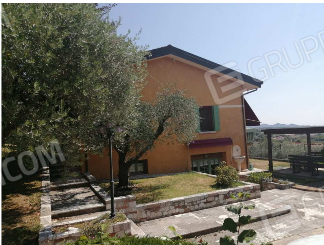
Vista lato ovest
