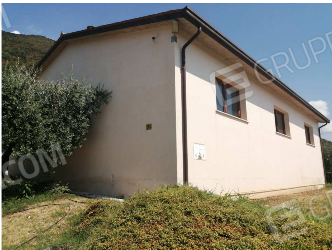
Vista da Sud - Magazzino
