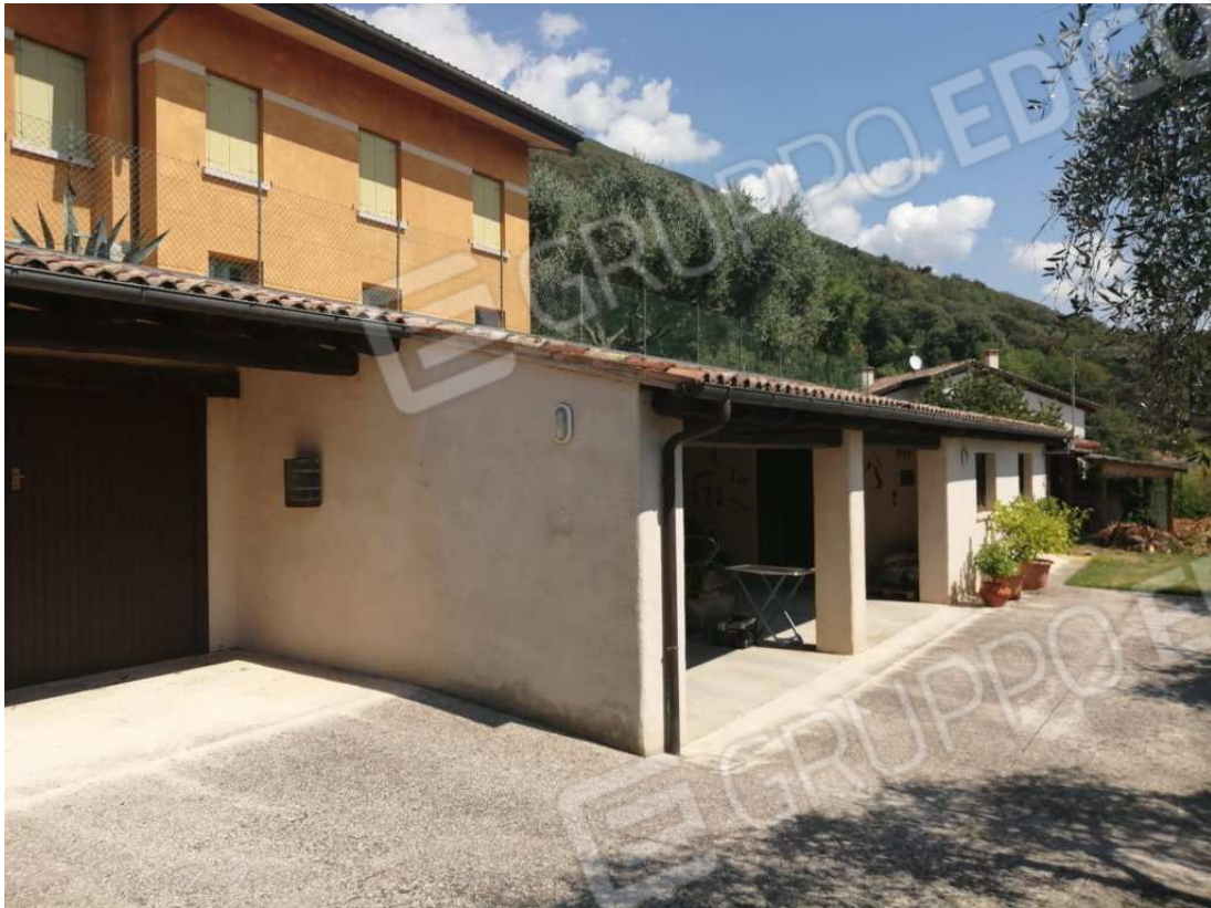
Tettoia vista sud
