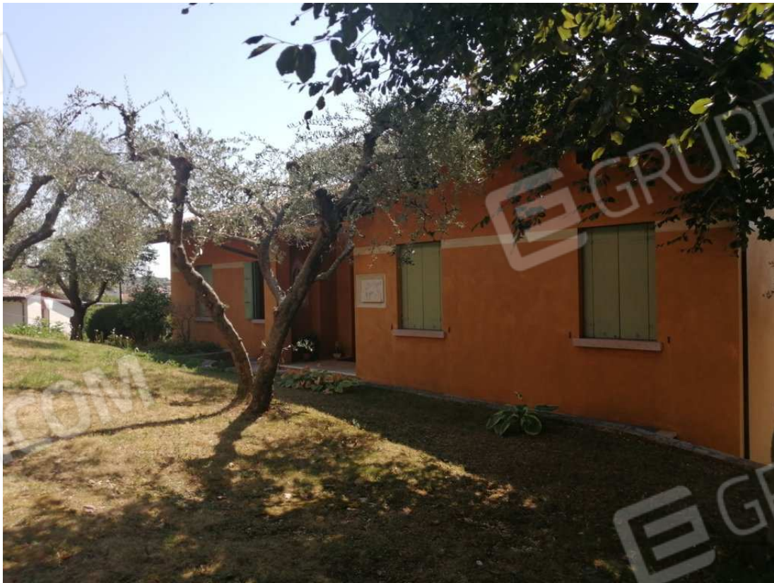
Vista lato nord
