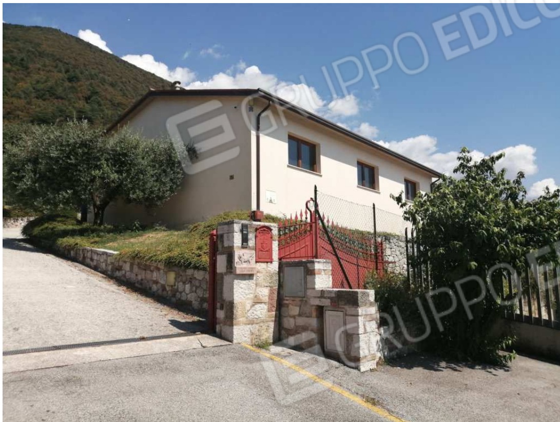
Vista da Sud - Magazzino
