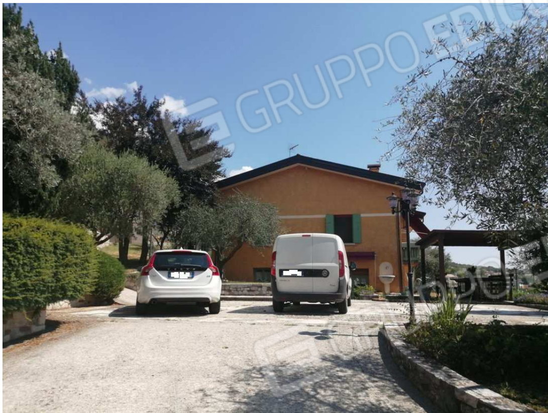
Vista lato ovest
