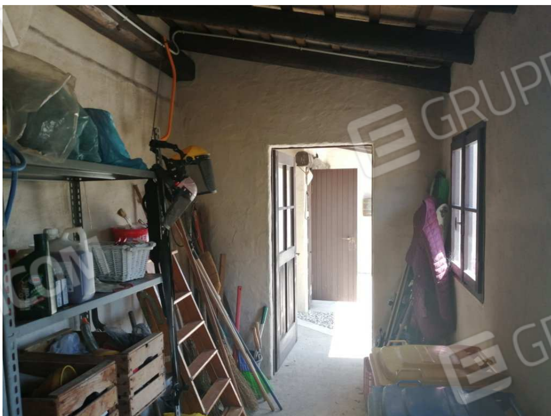
Tettoia vista interna porzione piu piccola
