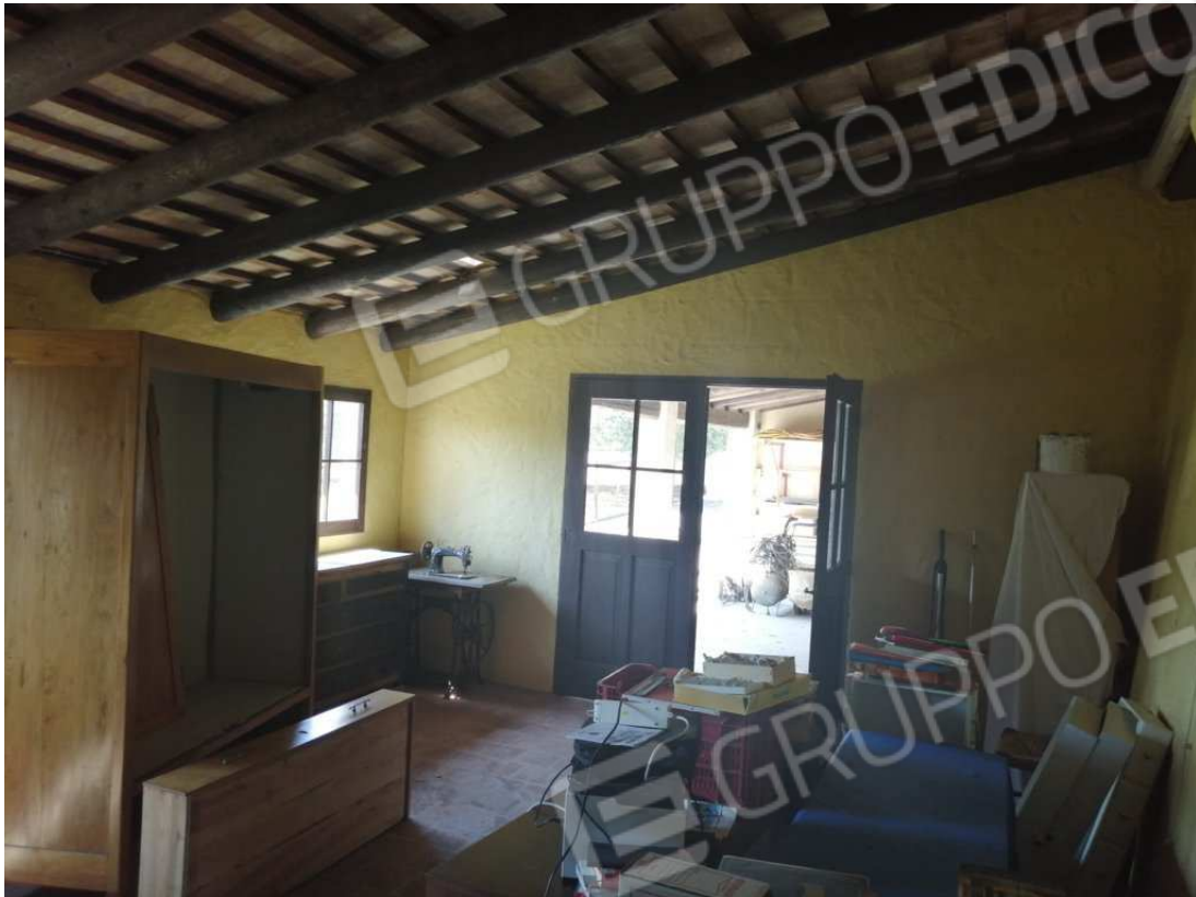
Tettoia vista interna
