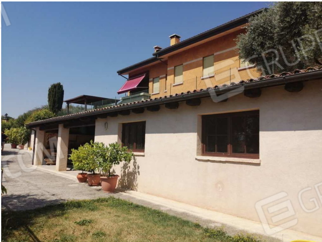
Tettoia vista sud
