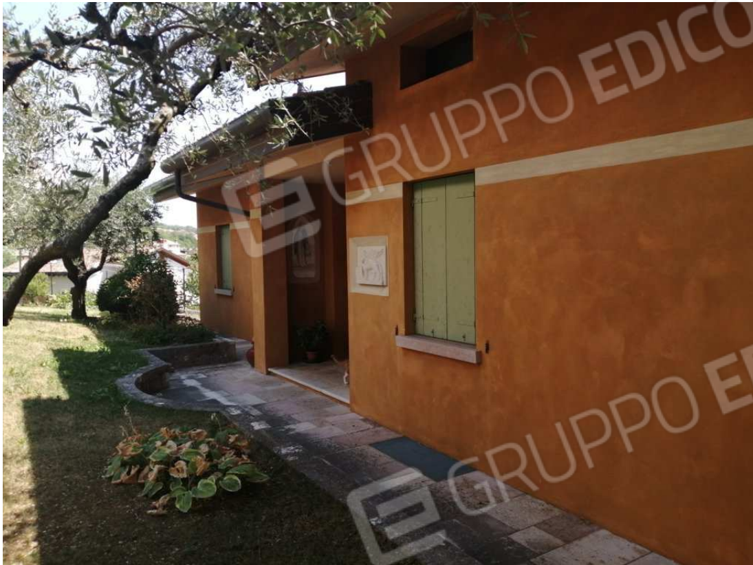
Vista lato nord
