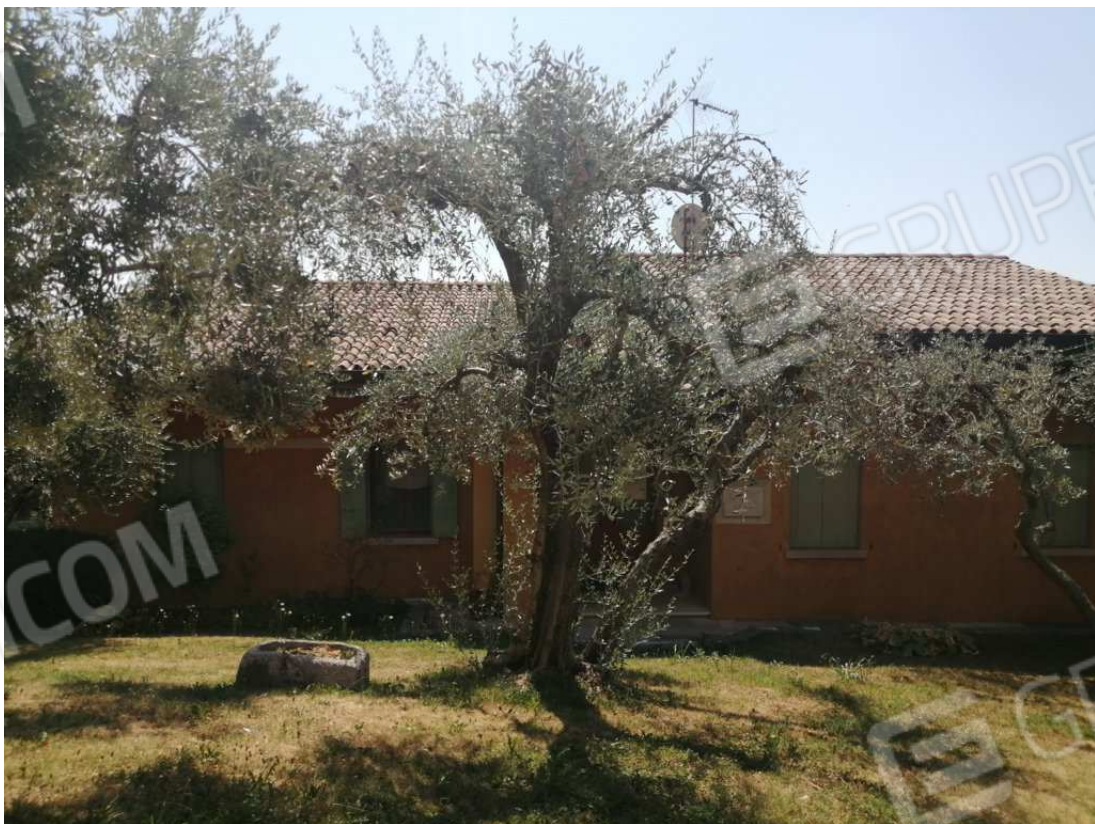
Vista lato nord
