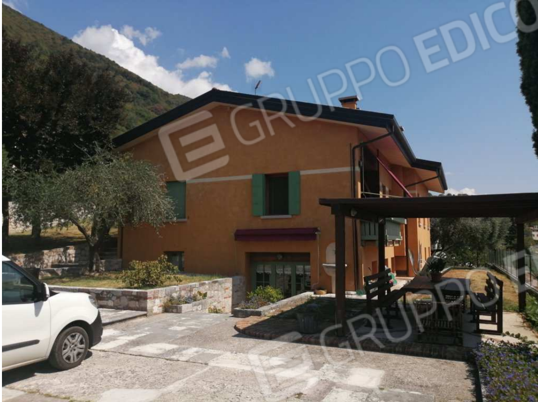
Vista lato ovest
