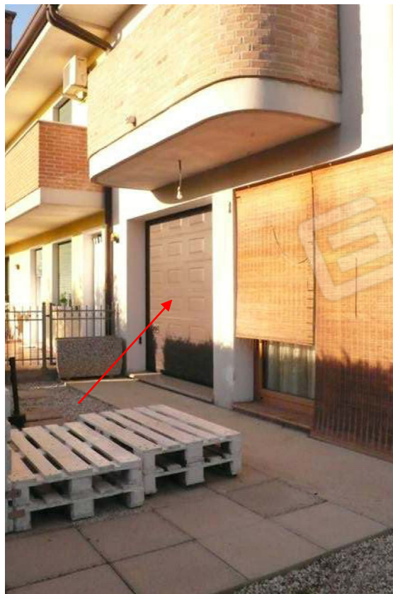
Foto n. 3 – portone di accesso all'autorimessa pignorata
