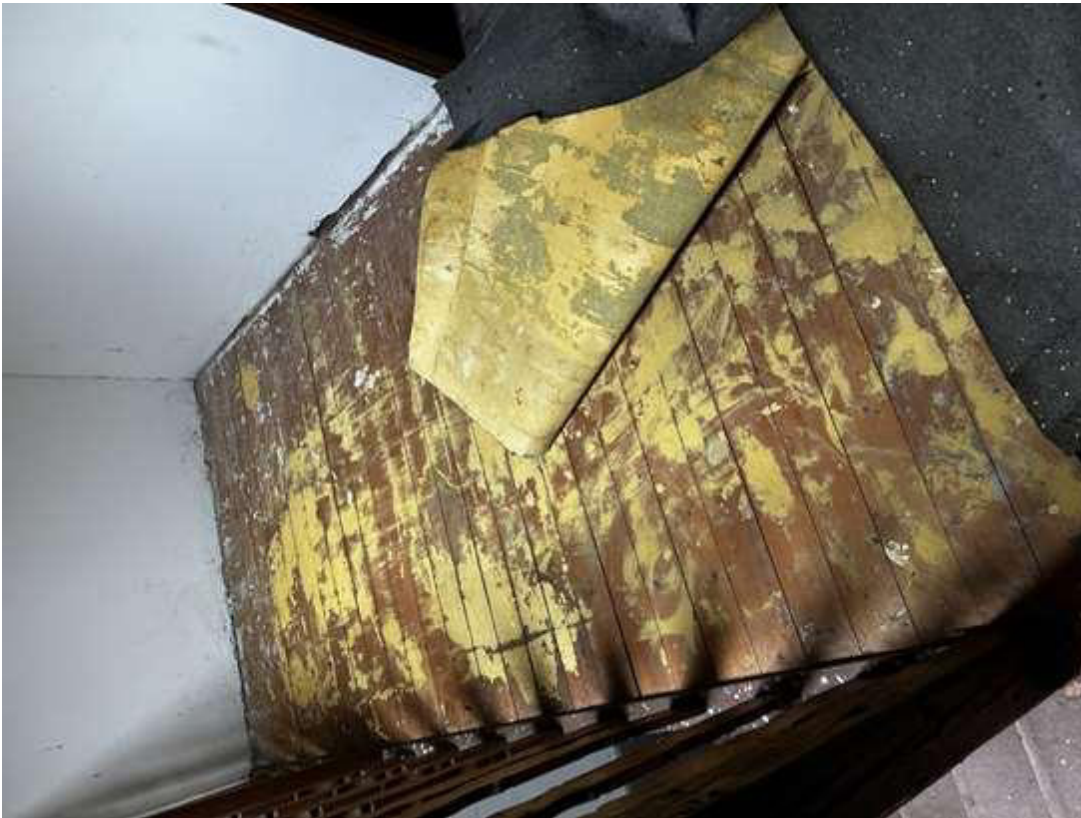
Figura 14: P2: moquette incollata su pavimento in legno
