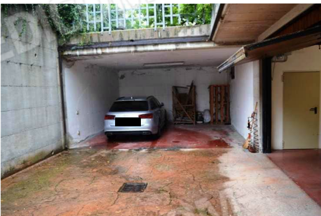
foto 32 - Vista dell'autorimessa m.n. 634 sub 3
