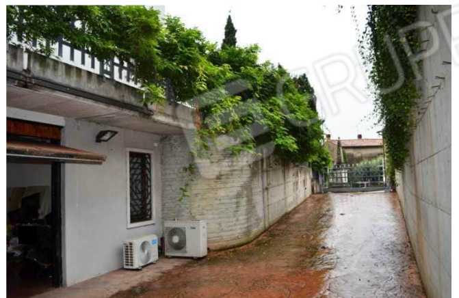
foto 33 - La rampa d'accesso carrai a nord ovest
