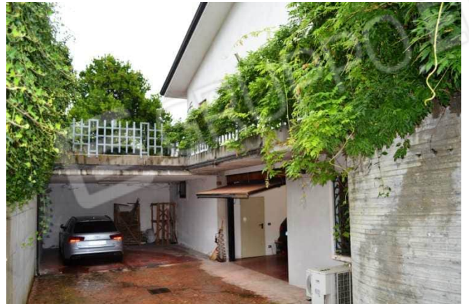
foto 6 - Vista delle due autorimesse a nord ovest
