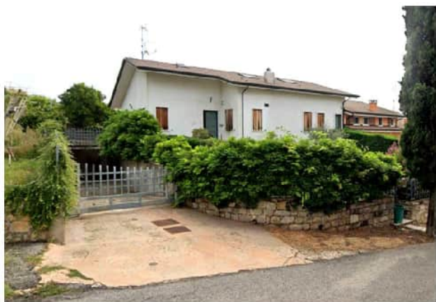
foto 1 - vista da sud ovest in via Libertà del villino a due piani f. t. e scantinato al civ. 4/F, con le autorimesse a nord ovest (a sinistra nella foto) con il relativo stallo d'accesso carraio e l'ingresso del villino che s'intravede di fianco alla pianta a destra della foto, con il giardino recintato fronte strada in secondo piano al centro della foto
