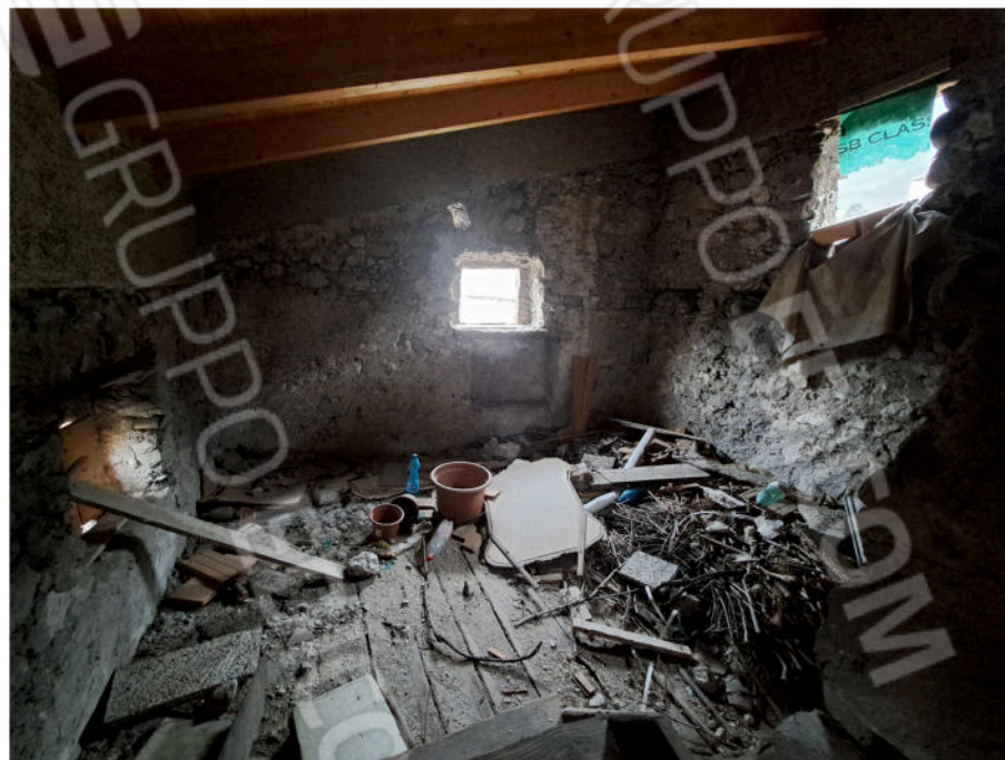
11 vista interna del vano soffitta minore P2
