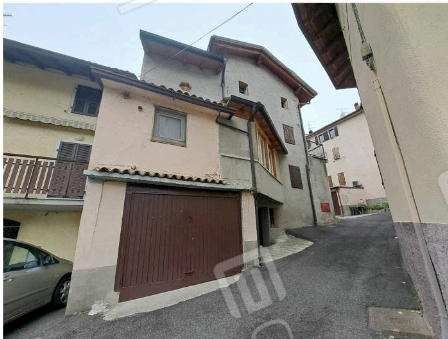
02 vista esterna dell'edificio da sud-est
