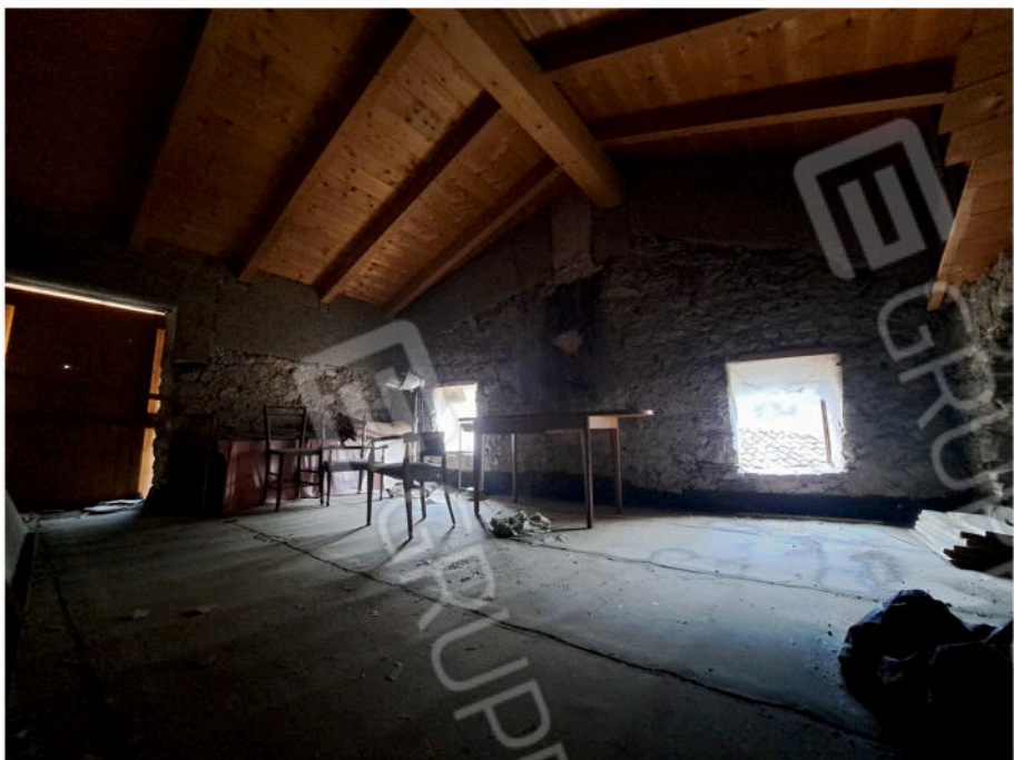
10 vista interna del vano soffitta maggiore P2
