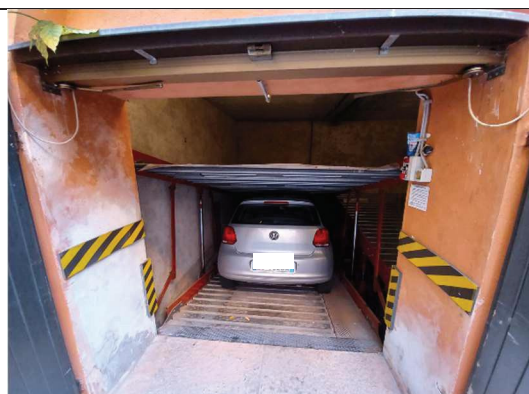
Figura 67: ripresa fotografica dei due posti auto
