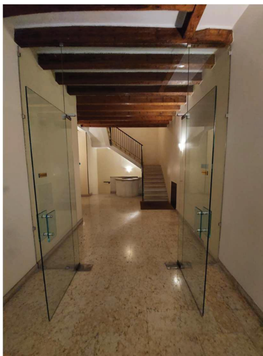
Figura 23: androne condominiale presente subito dopo l'ingresso dalla pubblica via
