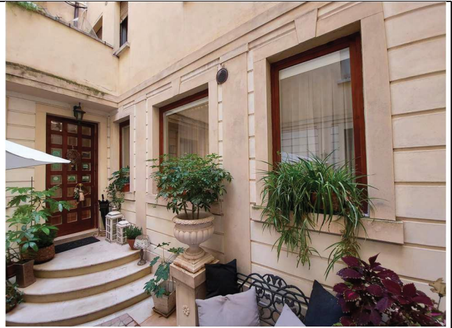
Figura 59: ripresa fotografica dell'ingresso
