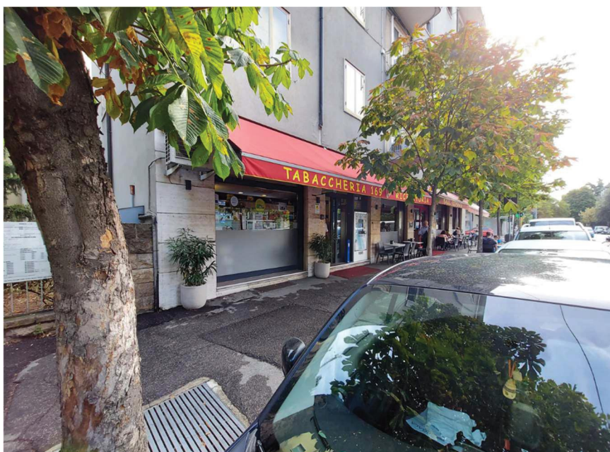
Figura 6: ripresa fotografica della facciata dell'immobile che affaccia su via Tolosetto Farinata degli Uberti
