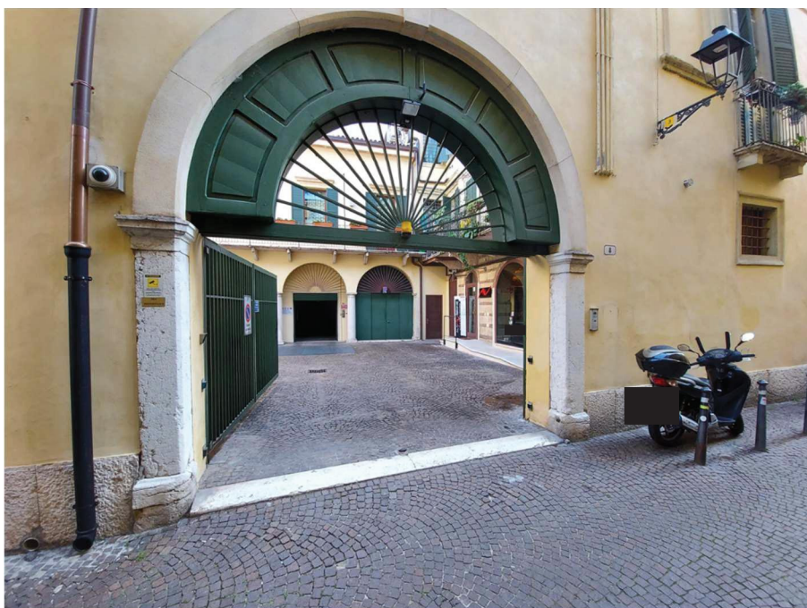
Figura 31: ingresso civico 8 per accedere all'autorimessa particella 154 sub 8
