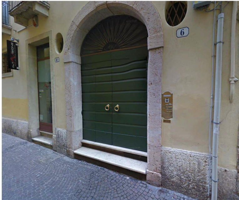
Figura 22: ingresso pedonale all'abitazione al civico n. 6
