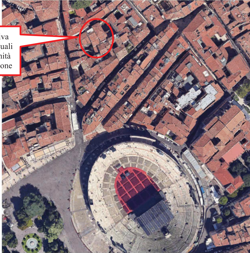
Figura 21: aerofotogrammetria dei luoghi con indicazione della posizione indicativa dei fabbricati nei quali sono inserite le unità oggetto del lotto 002
