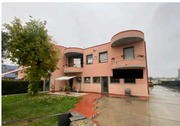
Fronte principale dell'edificio
