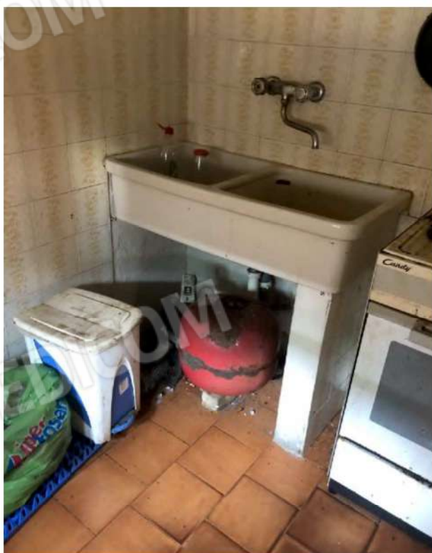
FOTO 10 - 1.a Piano terra, angolo cottura
