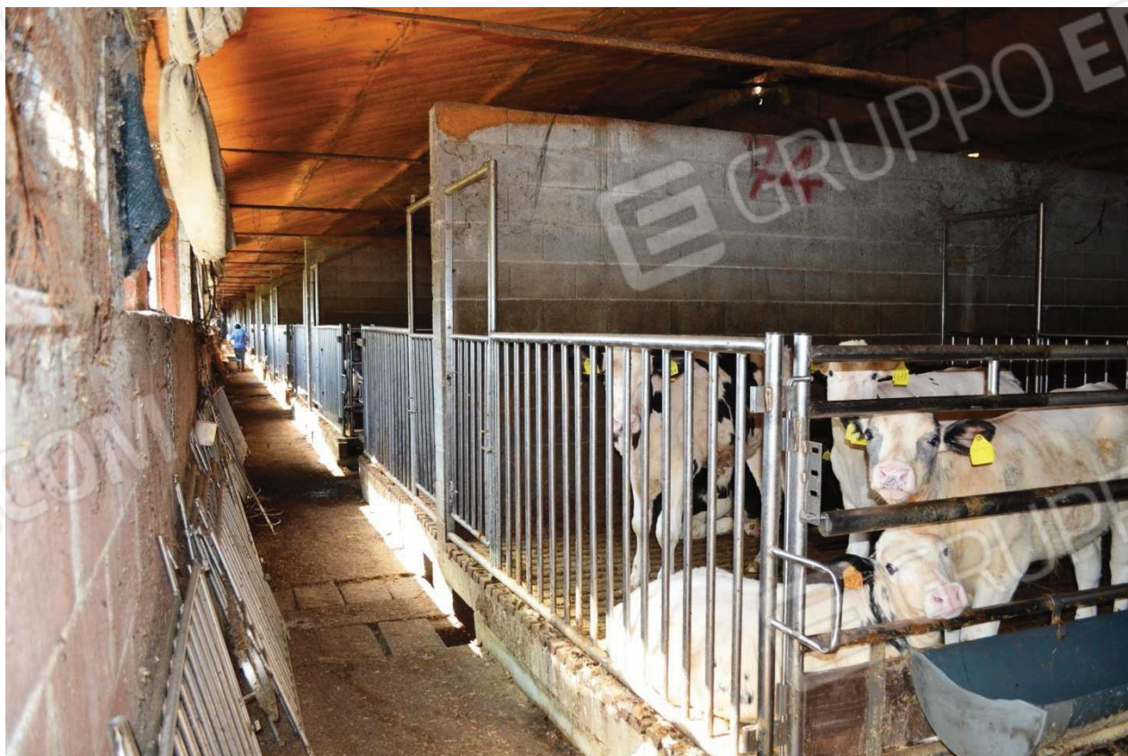
foto 23 – Stalla m.n. 355 CEU, corridoio di servizio zona nord - scorcio del corridoio di servizio sul fianco est della stalla visto dall'ingresso esterno a nord – in corrispondenza del 13° e ultimo modulo, con il divisorio costituito da blocchi in calcestruzzo non strutturali e copertura in eternit con schiuma applicata
