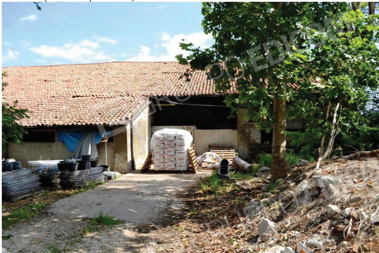
foto 2 - Stalla m.n. 107-117 CT, prospetto sud (visto da sud, all'imbocco di via Gramigna) - il complesso già stalla/portico/fienile datato 1840 ha dimensioni in pianta di circa m 32,10x20,00 vpp ed è stato adattato a unico locale per la stabulazione dei vitelloni demolendo il solaio del fienile e parte dei muri interni non strutturali, mantenendo solo i pilastri in laterizio e la tradizionale copertura in capriate e travi in legno
