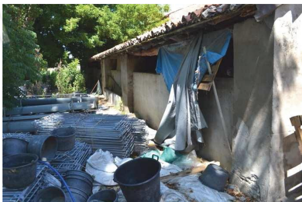
foto 5 - Parte ovest del prospetto sud (ex prolungamento del portico con falda ribassata)
