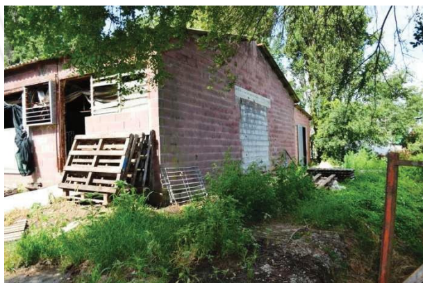
foto 18 - Il prospetto nord della stalla sul m.n. 355 visto da nord est
