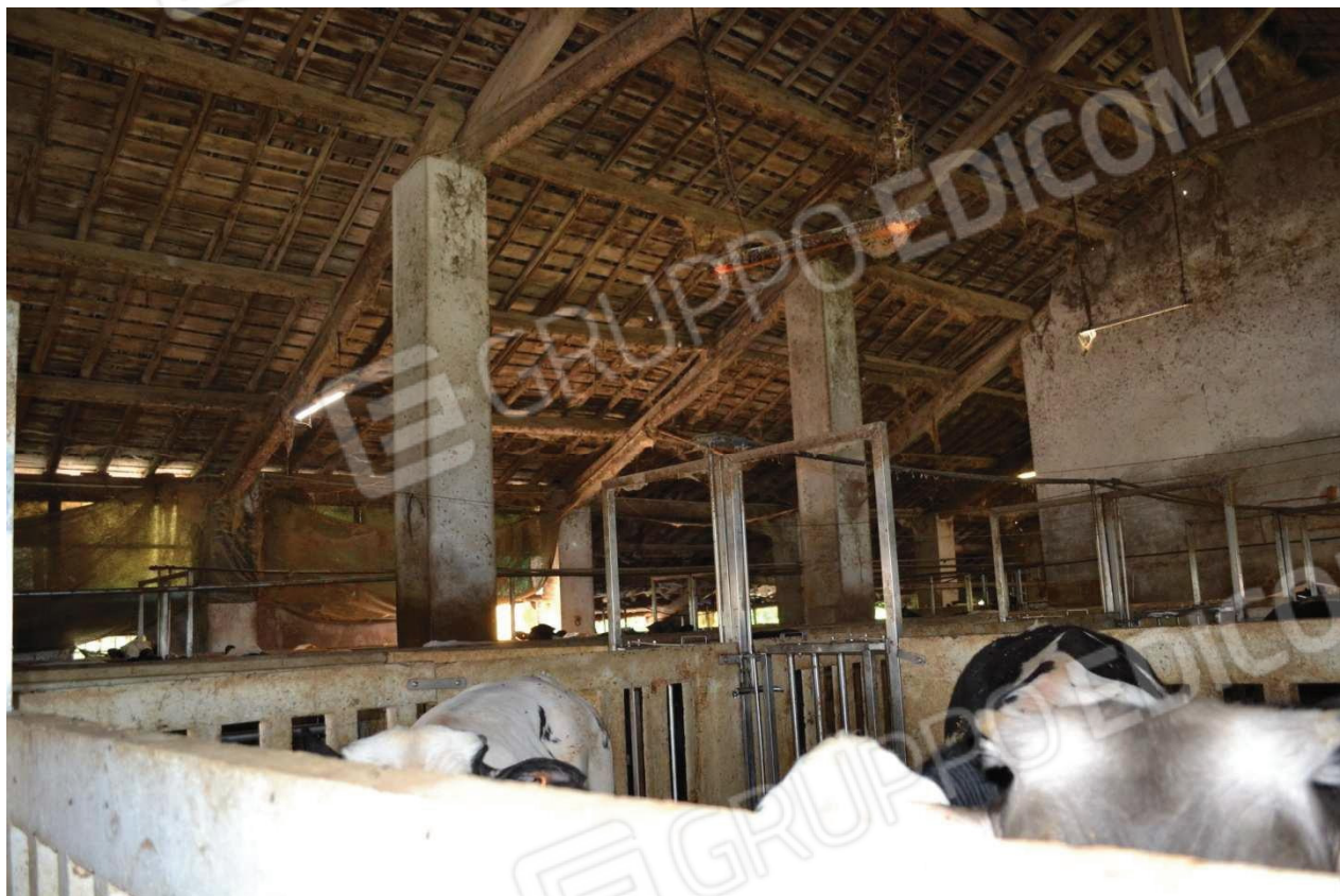
foto 11 – Stalla m.n. 107-117 CT, zona est (parte sud ovest) - scorcio visto dall'interno della zona sud ovest dell'ex portico a sud dell'ex stalla (all'epoca delimitati dai pilastri centrali, con falda di copertura costituita da coppi in laterizio su scortecciato e telaio di travetti, travi secondarie e travi primarie in prolungamento delle capriate in legno e del setto divisorio della ex stalla con fienile
