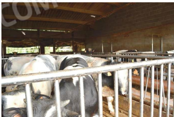
foto 32 - Stabulazione nella zona sud con copertura leggera ristrutturata
