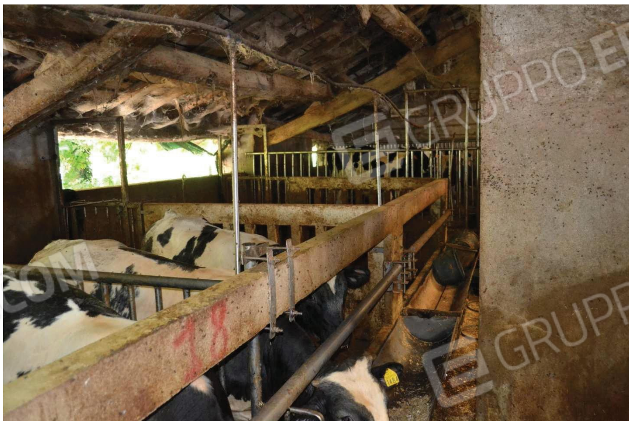
foto 14 – Stalla m.n. 107-117 CT, zona ovest (parte sud ovest) - scorcio dell'interno della parte ribassata della falda sud della stalla (a sinistra della foto) anch'esso attrezzato con celle di stabulazione con copertura in legno analoga a quella dell'ex portico. Le condizioni delle murature e della copertura della stalla d'epoca sono mediocri, gli intonaci sono evidentemente scadenti e gli impianti da verificare, in particolare sotto il profilo igienico/sanitario dello smaltimento e raccolta dei liquami nelle adiacenti concimaie (non pignorate)
