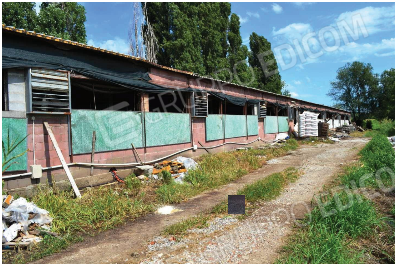
foto 17 – Stalla e annessi rustici m.n. 355 CEU, fianco est (parte nord vista da sud est) – scorcio del prospetto est della stalla con pianta di circa m 100,24 x 16,31, composta da 13 moduli ciascuno con 3+3 celle di stabulazione standard, le prime 4 delle quali (da sud, adiacenti all'impianto d'alimentazione) hanno la copertura ristrutturata con pannelli in lamiera coibentata - le altre hanno copertura in eternit da ristrutturare
