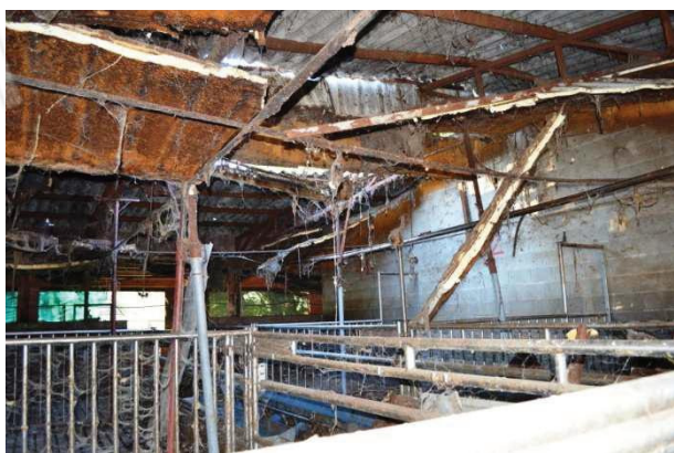
foto 25a1 - Scorcio della parete nord del modulo centrale con copertura da ristrutturare
