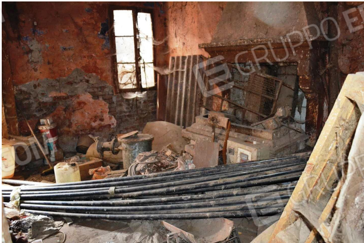
foto 40 – Annessi rustici m.n. 355 CEU, deposito a piano terra - scorcio dall'interno della stanza a piano terra dei rustici d'epoca a sud della stalla (la stanza sul prospetto sud adiacente all'ex garage a ovest); il locale è utilizzato come deposito di materiali eterogenei ed è mantenuto nella condizione originale, col camino e infissi in legno, pareti in mattoni e soffitto in legno - tutto in condizioni evidentemente scadenti
