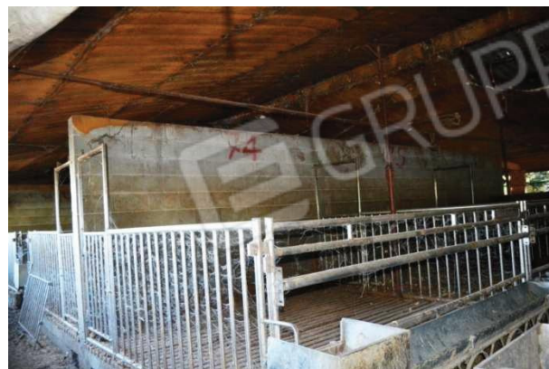
foto 28a - Scorcio del 13° e ultimo modulo della parte nord della stalla da ristrutturare
