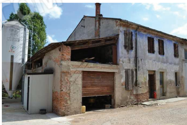
foto 20 - Vista dai rustici con autorimessa e casa usate come magazzini, depositi e ufficio
