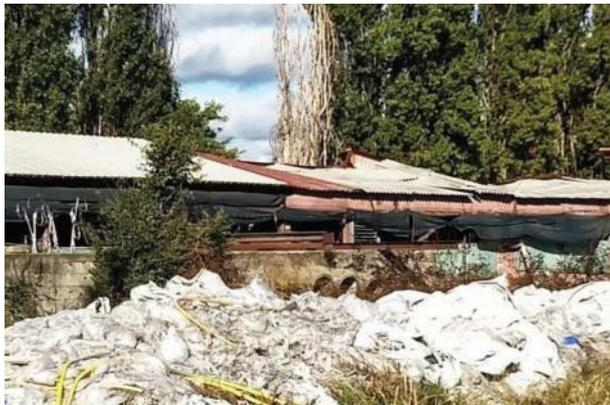
foto 4 - Stalla nord su m.n. 355 (scorcio dello stato attuale del prospetto est visto da est): si vede la parte centrale della stalla con la vecchia copertura di tutta la parte nord collassata
