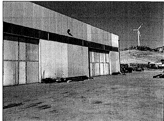
Foto n. 2- Lato sud Capannone
