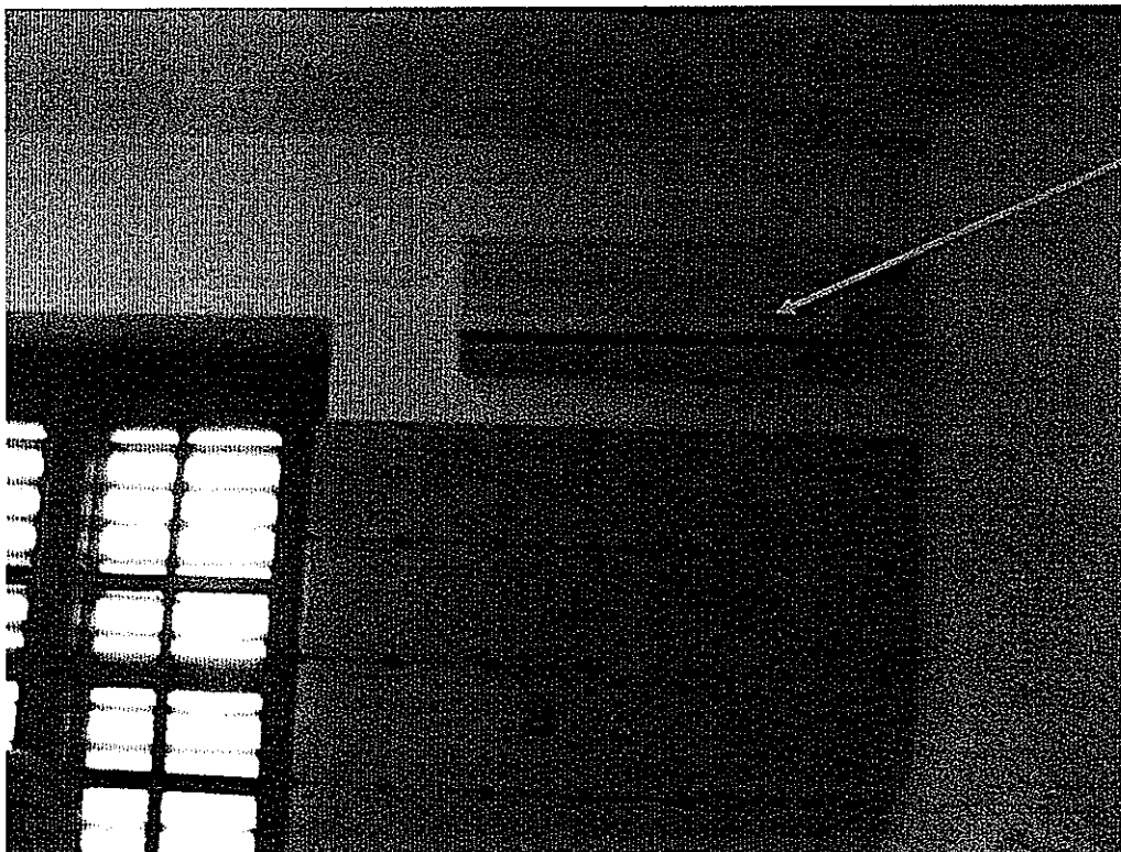
Fig.13 – Interno Cucina: Vista posizione condizionatore
