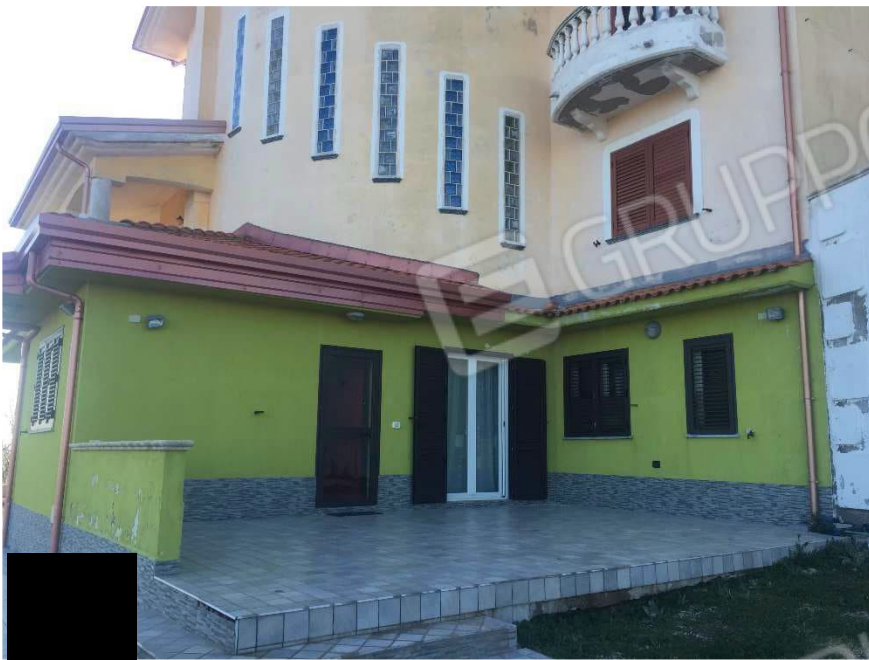
Foto 5 – Veduta esterna ingresso piano seminterrato
