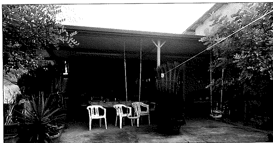
Fig. 25- Tettoia e vano adibito a servizio igienico realizzato sulla corte esterna in aderenza al magazzino sub 3.
