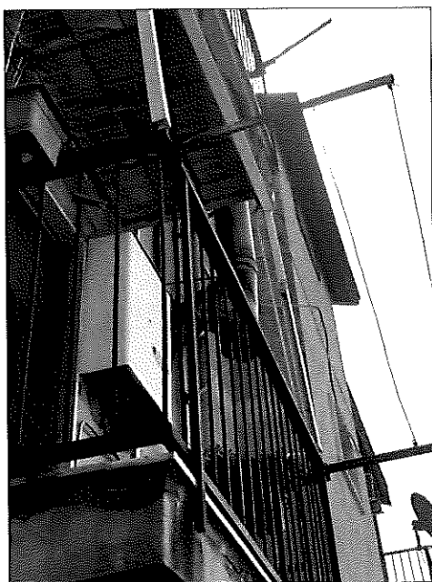
Fig. 10_ Dettaglio facciata posteriore
