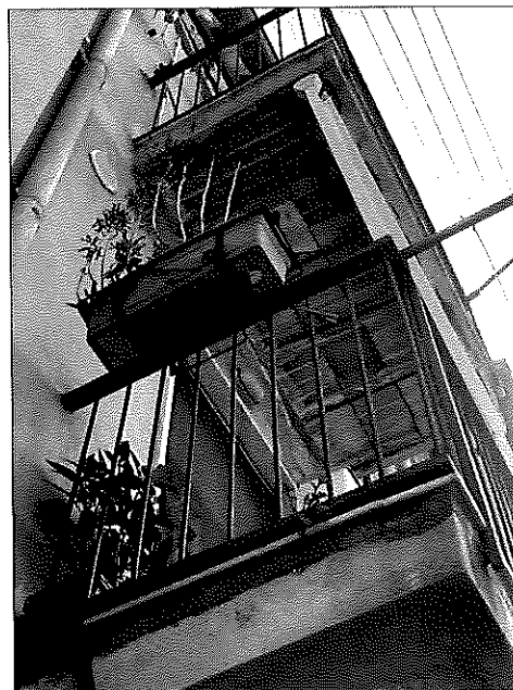
Fig. 11_ Dettaglio facciata posteriore,
