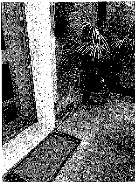
Foto 12 - Vista sulla zona di ingresso
