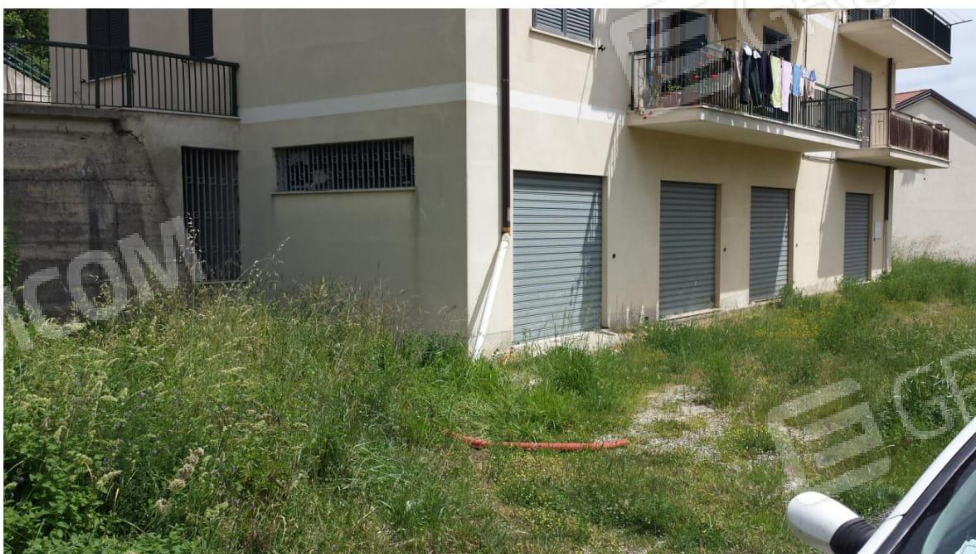
FOTO n.6 – Foglio 12 Part. 224 Sub. 6,7,8
