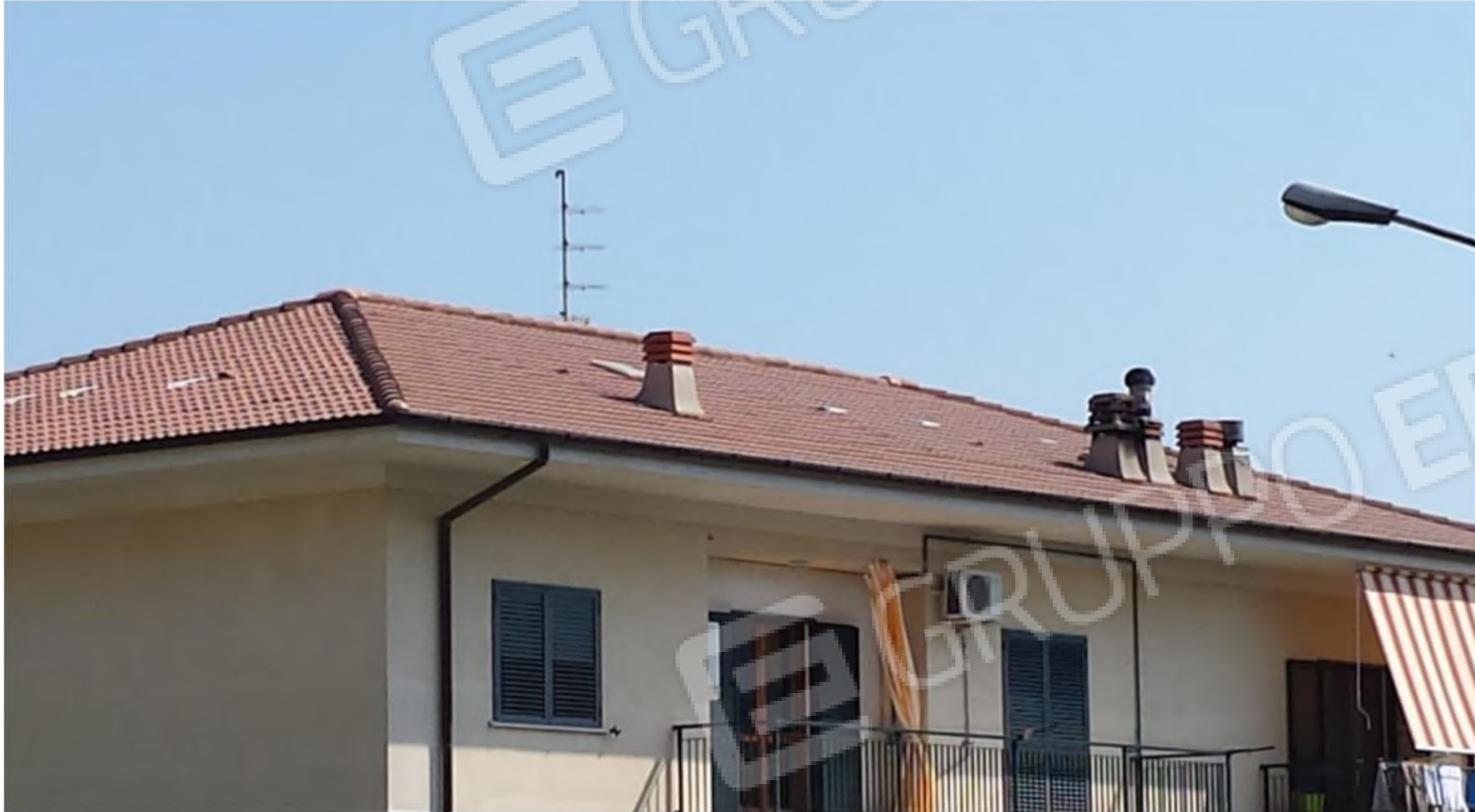
FOTO n.13 – Foglio 12 Part. 224 Sub. 5
