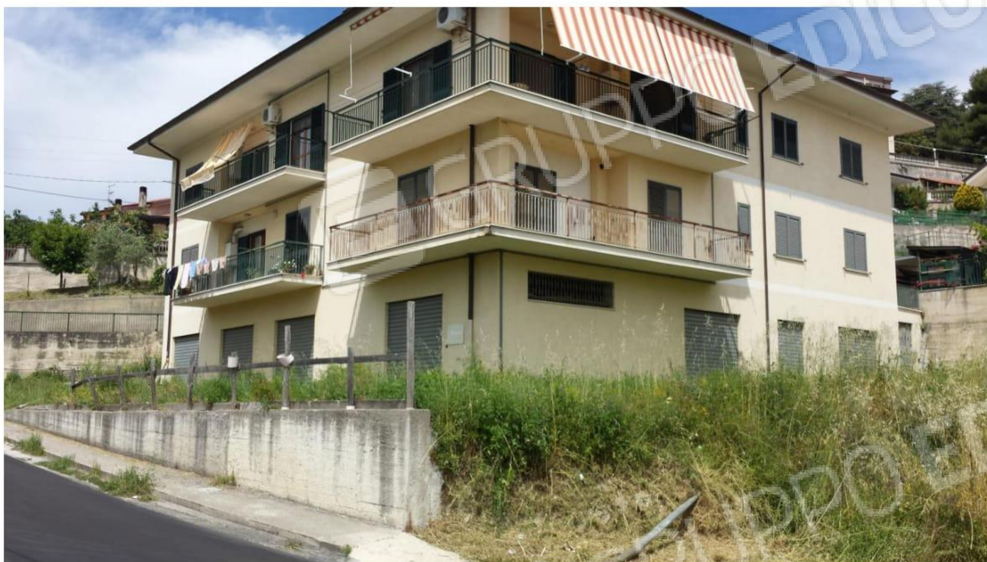
FOTO n.7 – Foglio 12 Part. 224 Sub. 6,7,8
