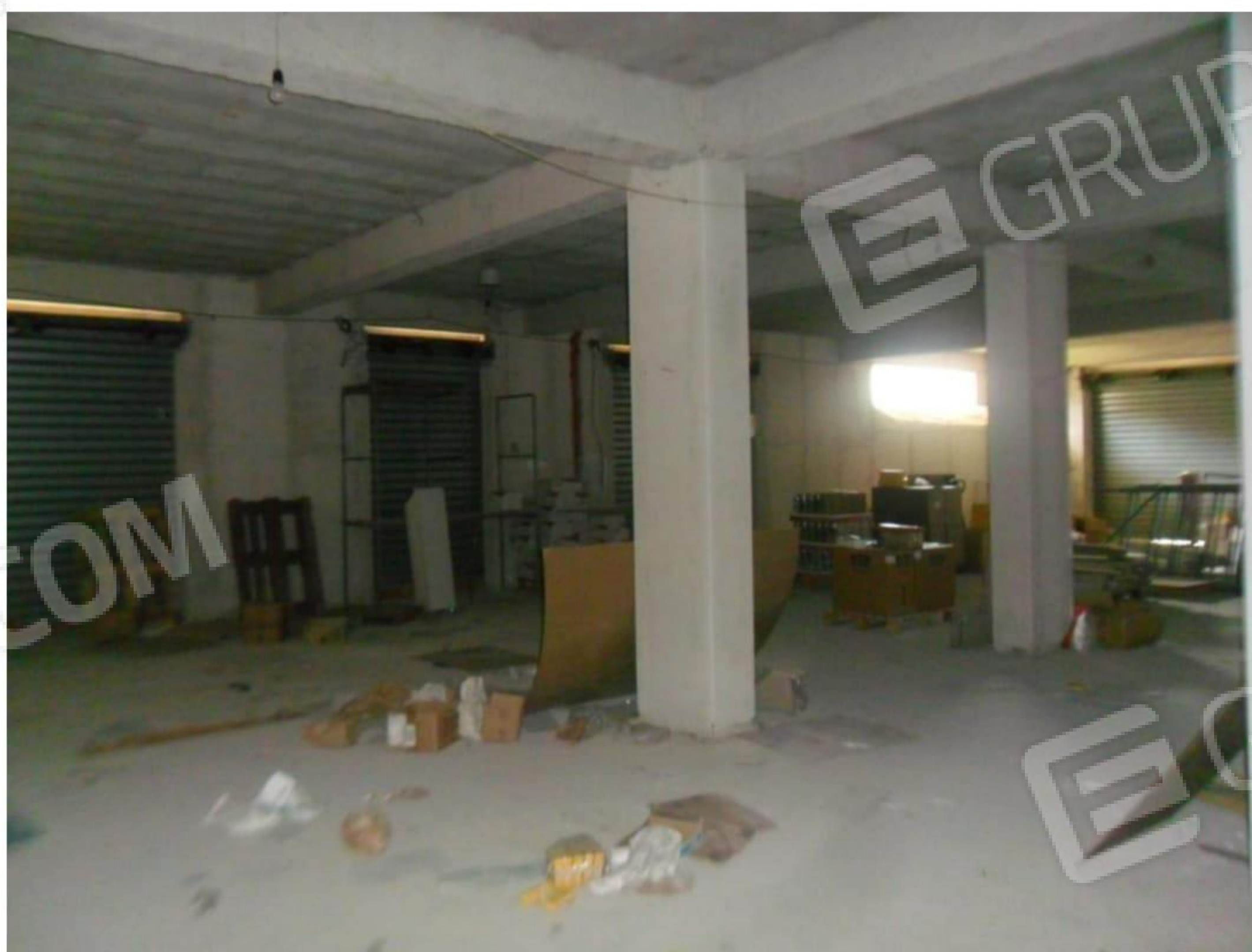
FOTO n.8 – Foglio 12 Part. 224 Sub. 6 -7
