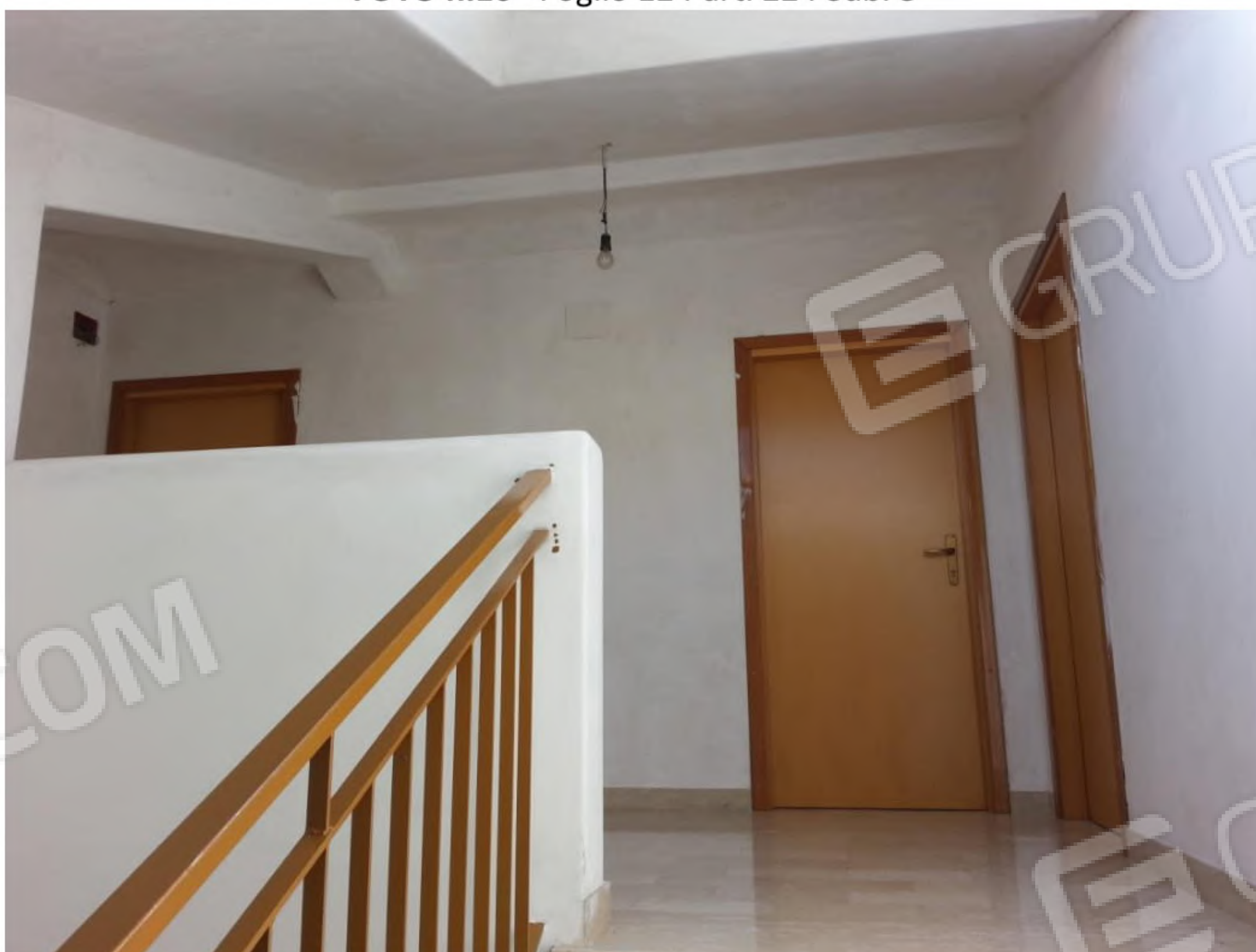
FOTO n.16– Foglio 12 Part. 224 Sub. 5
