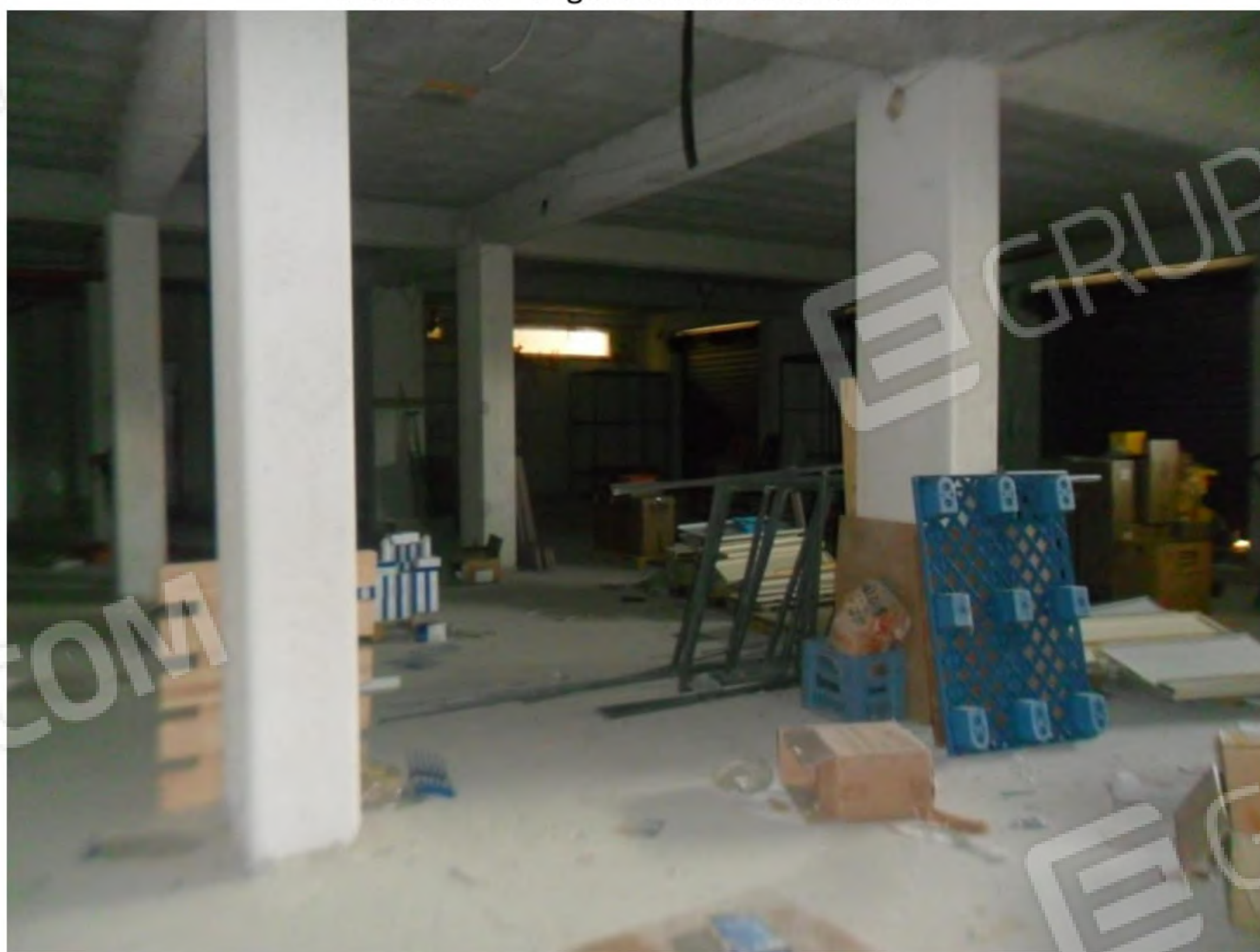
FOTO n.10 – Foglio 12 Part. 224 Sub. 6 -7
