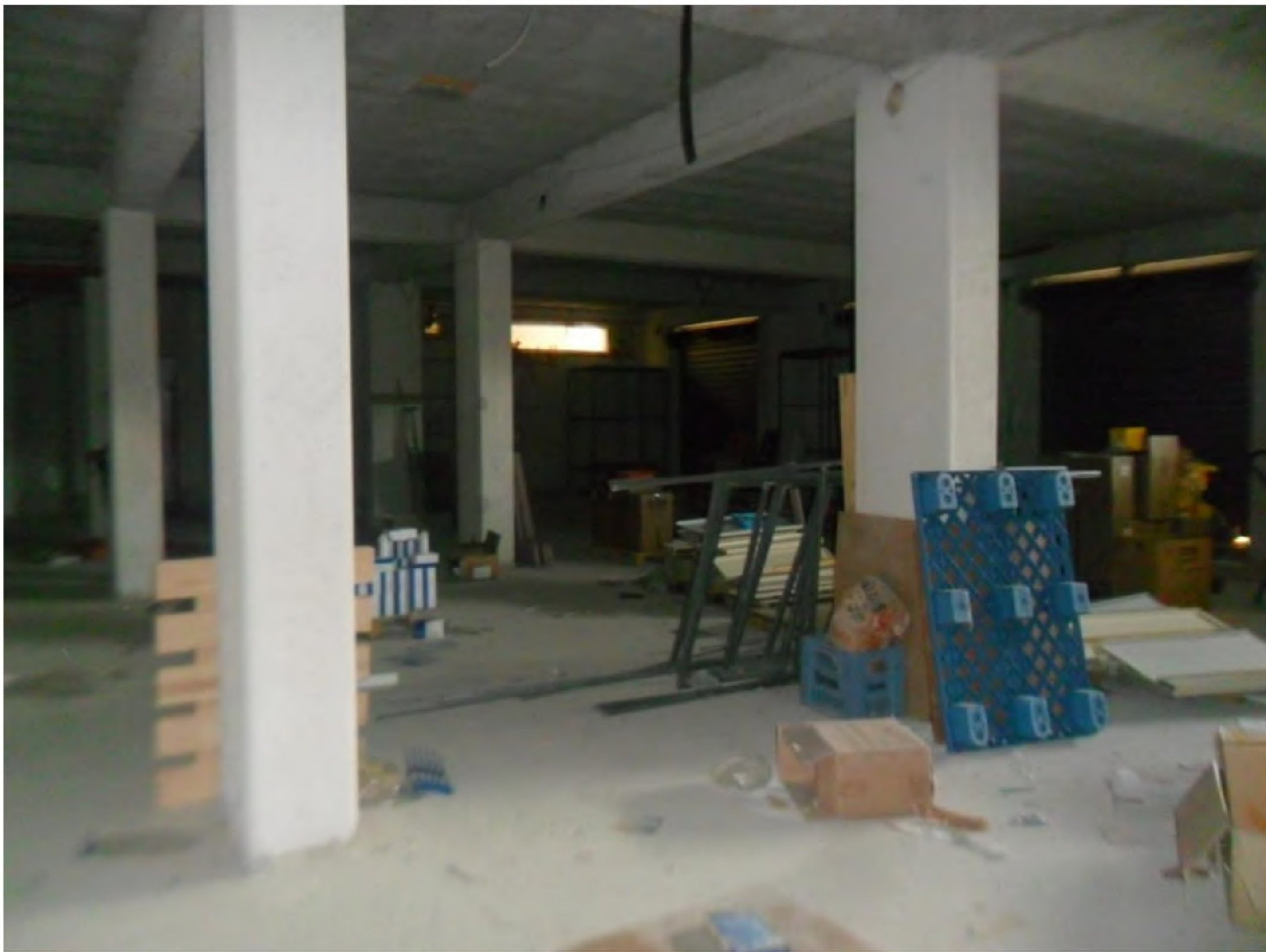
FOTO n.10 – Foglio 12 Part. 224 Sub. 6 -7
