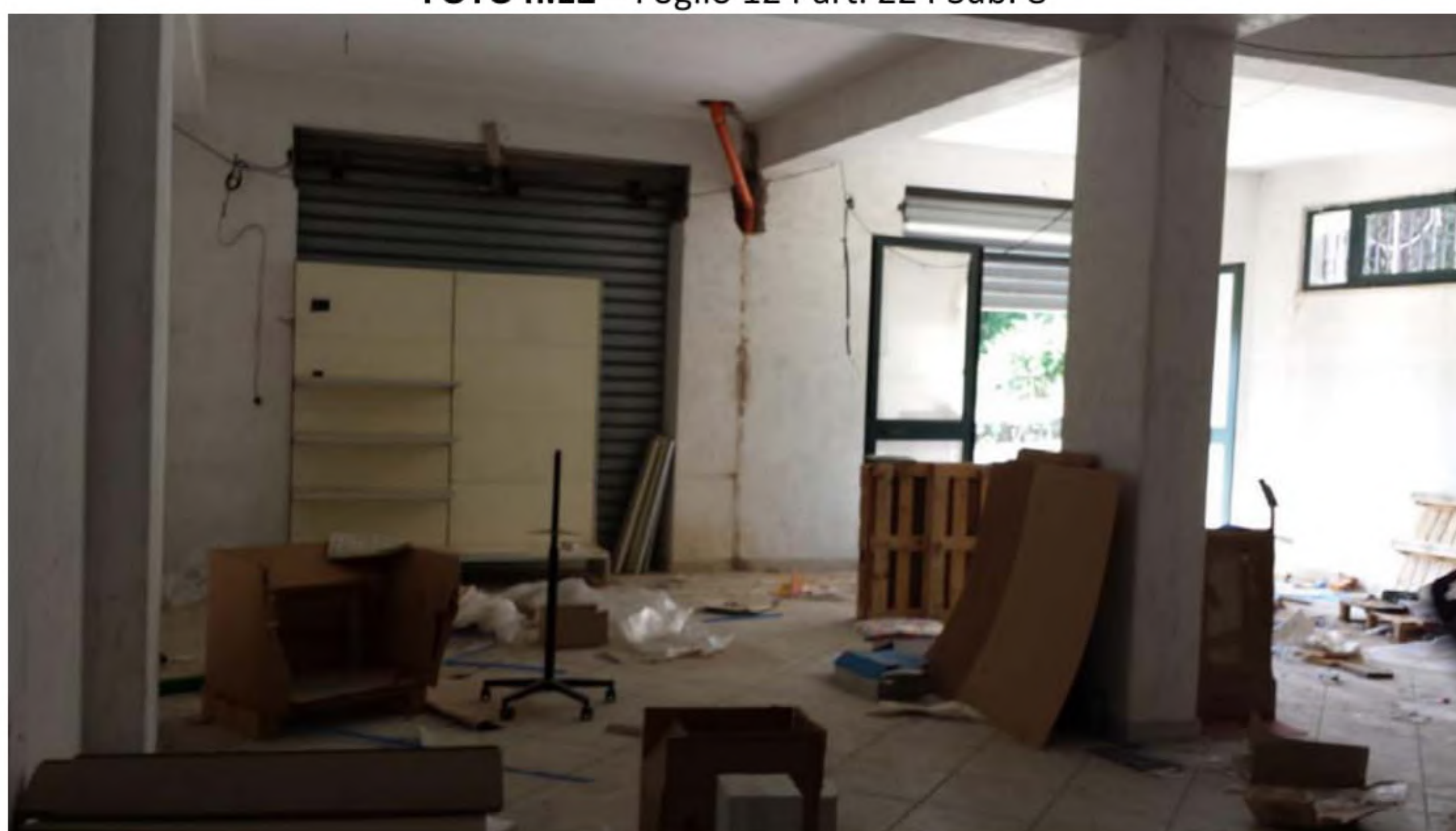
FOTO n.12 – Foglio 12 Part. 224 Sub. 8
