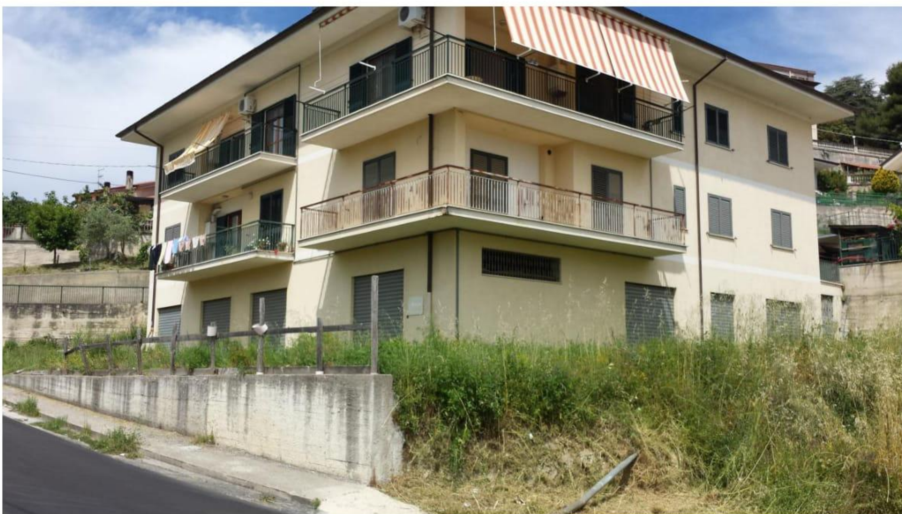
FOTO n.7 – Foglio 12 Part. 224 Sub. 6,7,8
