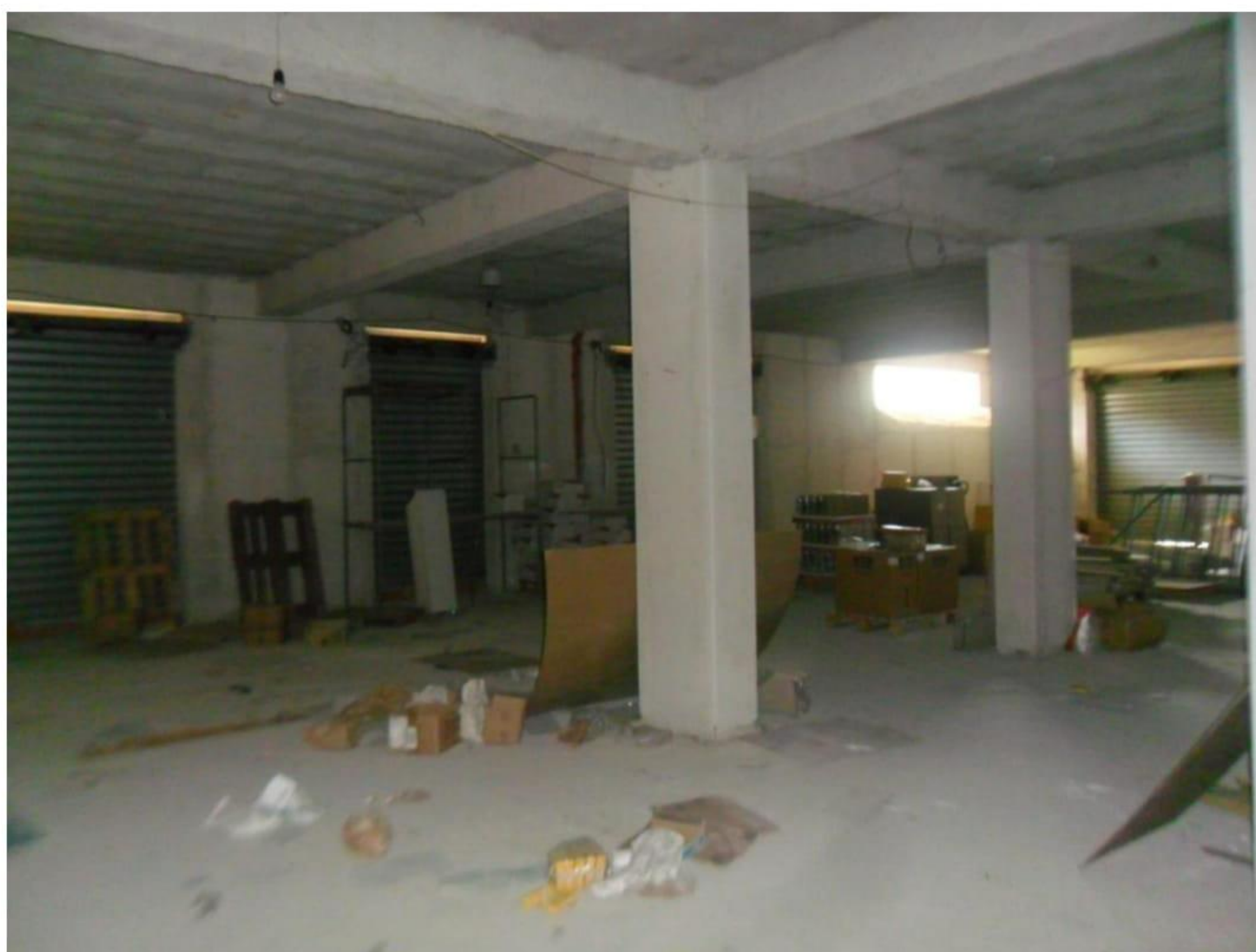
FOTO n.8 – Foglio 12 Part. 224 Sub. 6 -7
