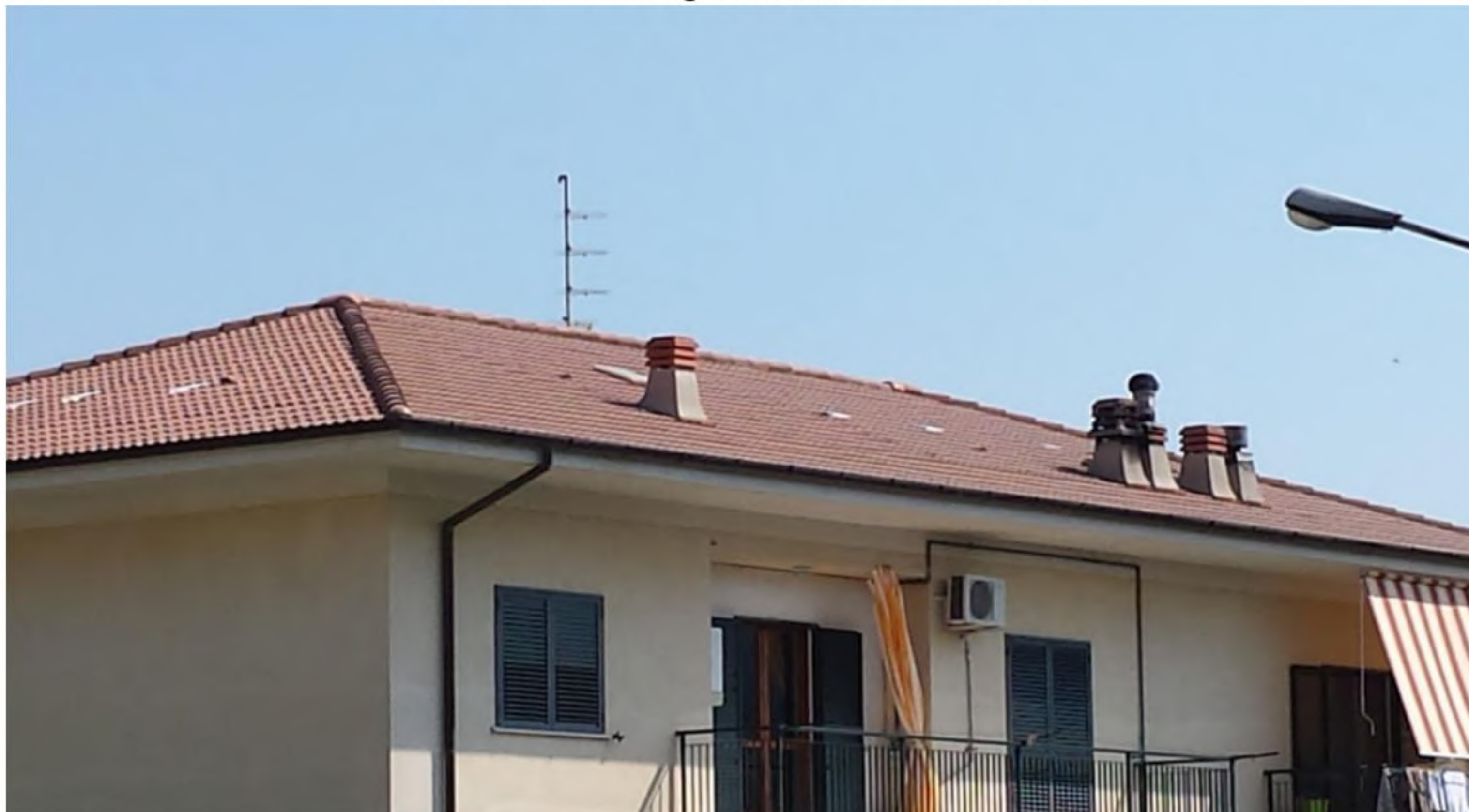
FOTO n.13 – Foglio 12 Part. 224 Sub. 5
