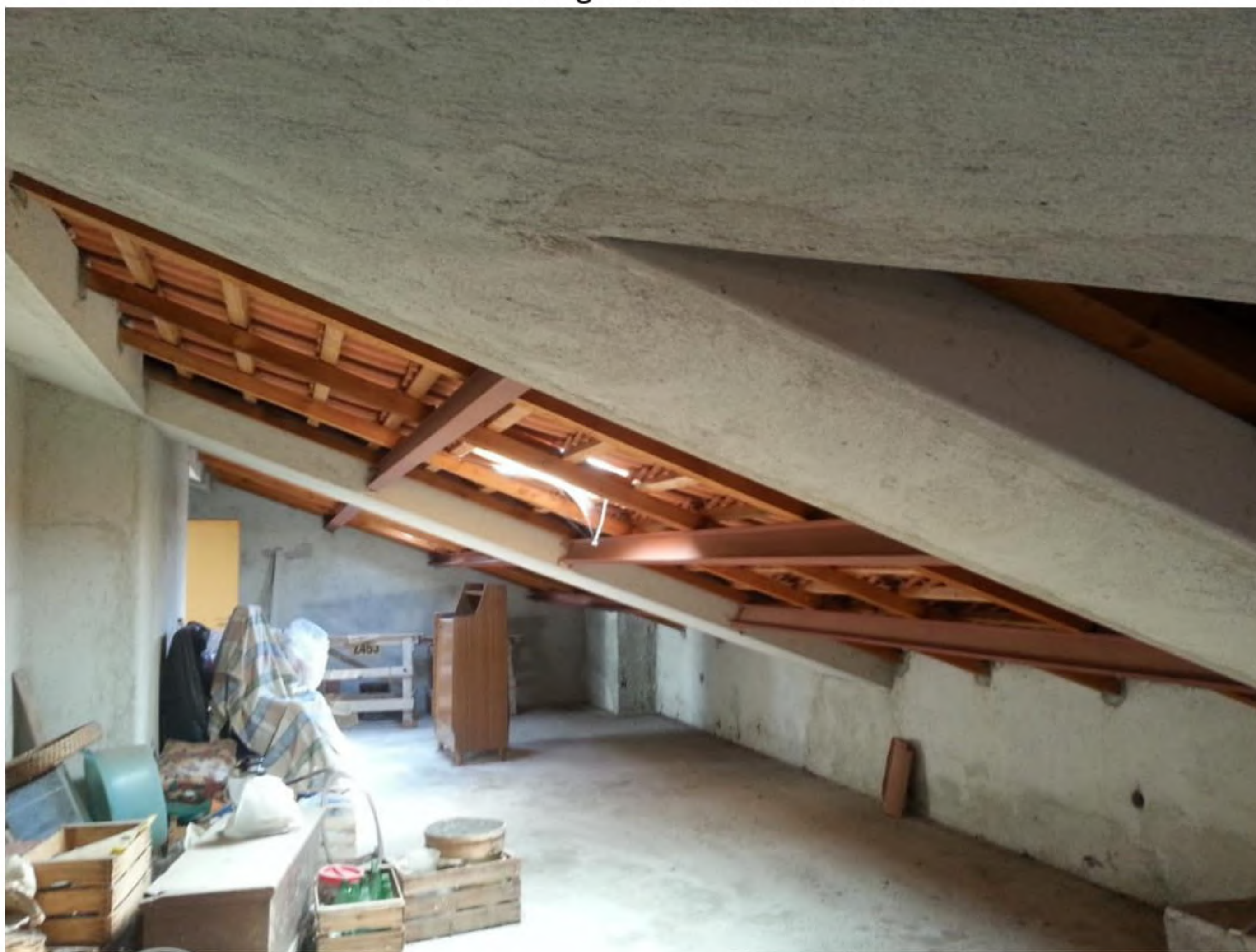
FOTO n.15– Foglio 12 Part. 224 Sub. 5
