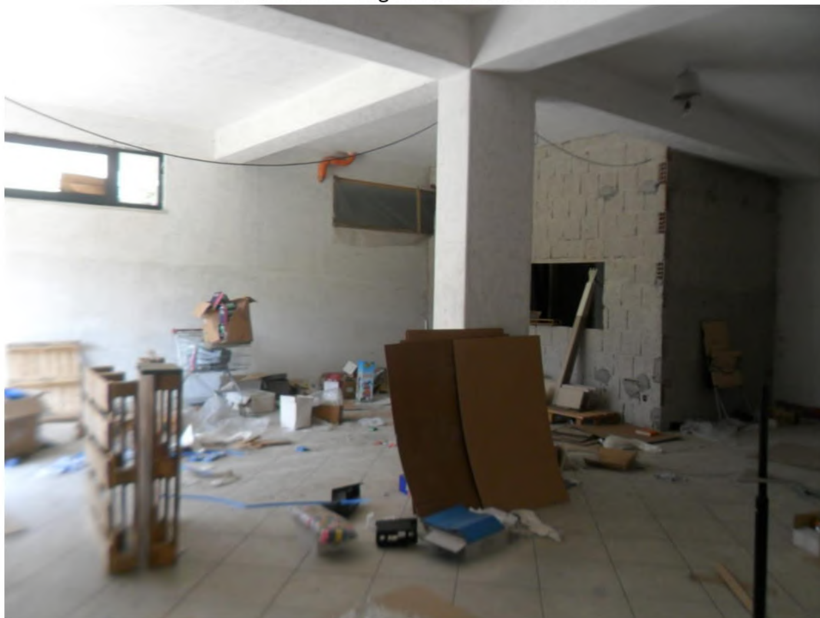
FOTO n.11 – Foglio 12 Part. 224 Sub. 8
