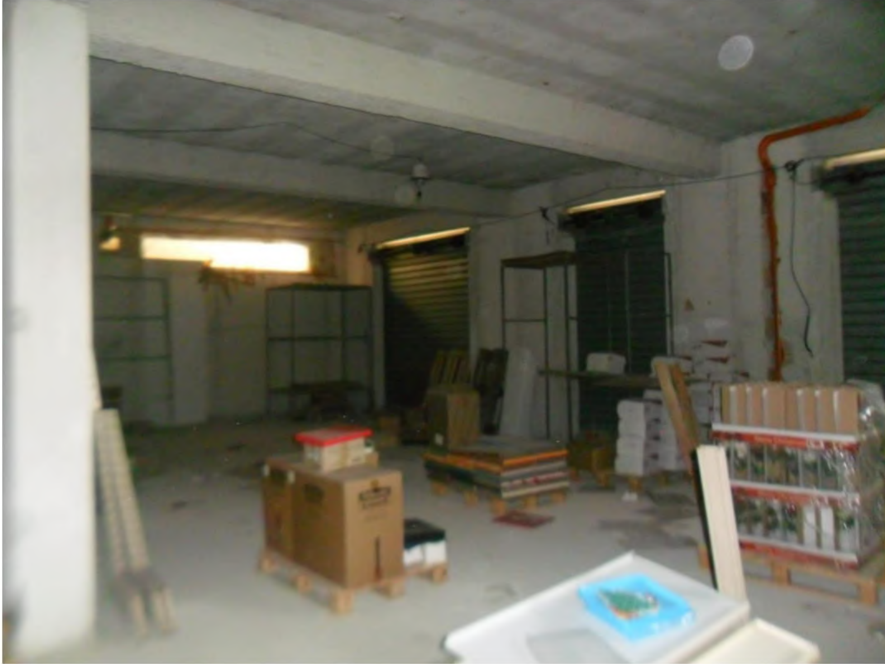
FOTO n.9 – Foglio 12 Part. 224 Sub. 6 -7
