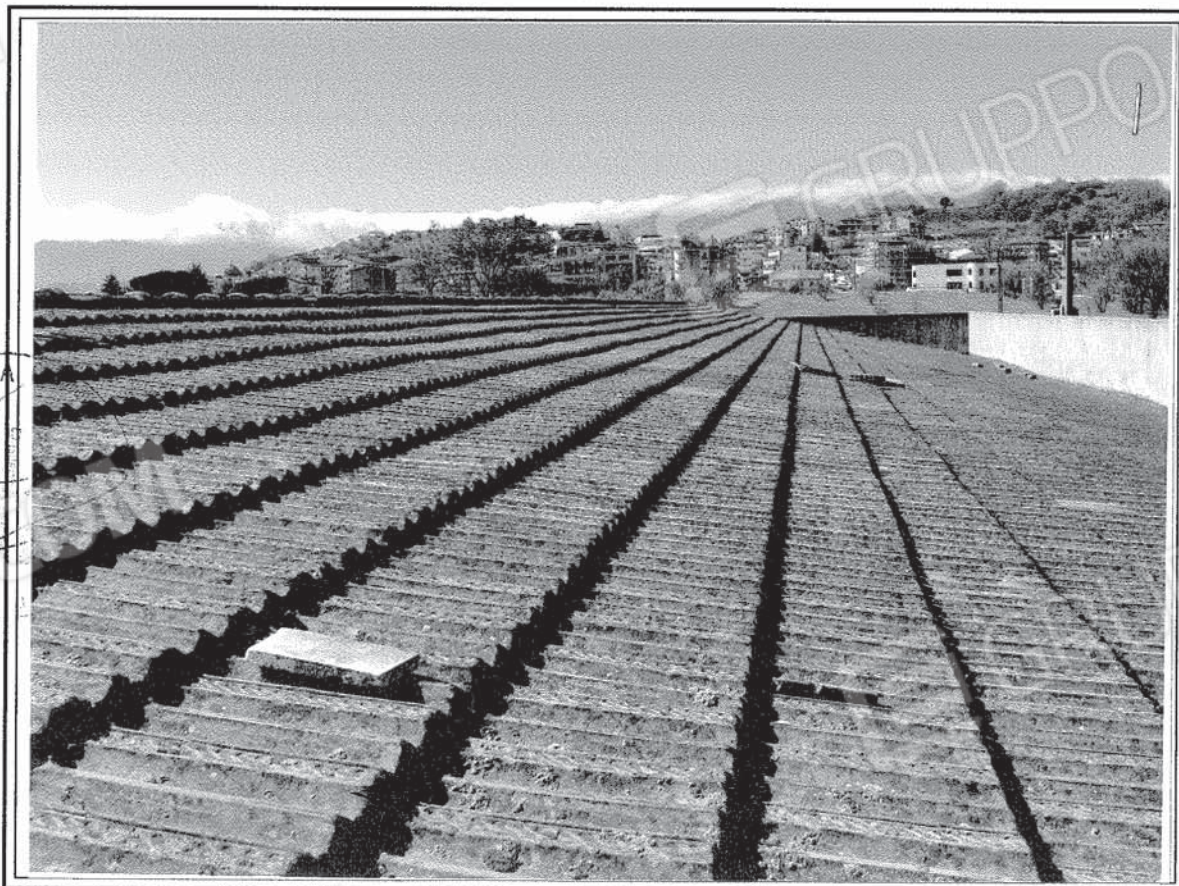
Foto 10: vista particolare – copertura capannone;
