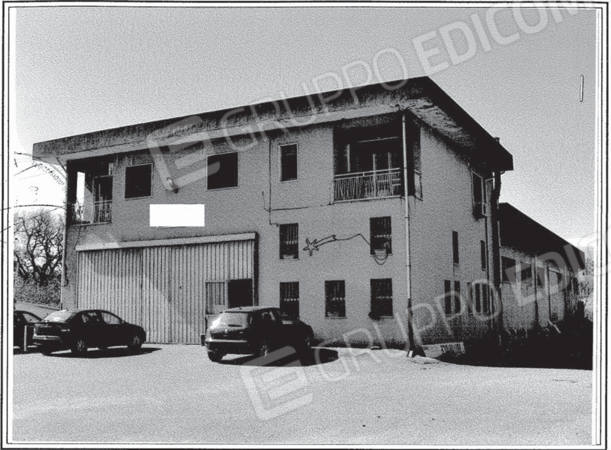
Foto 3: vista generale fabbricato - lotti 1 e 2 - lato est;
