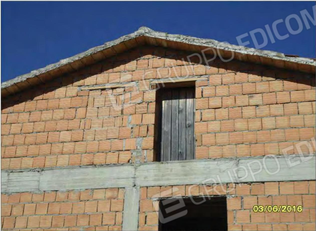
Fotografia n.27 – Vista del Fabbricato in cls.a., prospetto Est (livello terra + sottotetto). Particolare tompagnatura, telaio e copertura.
