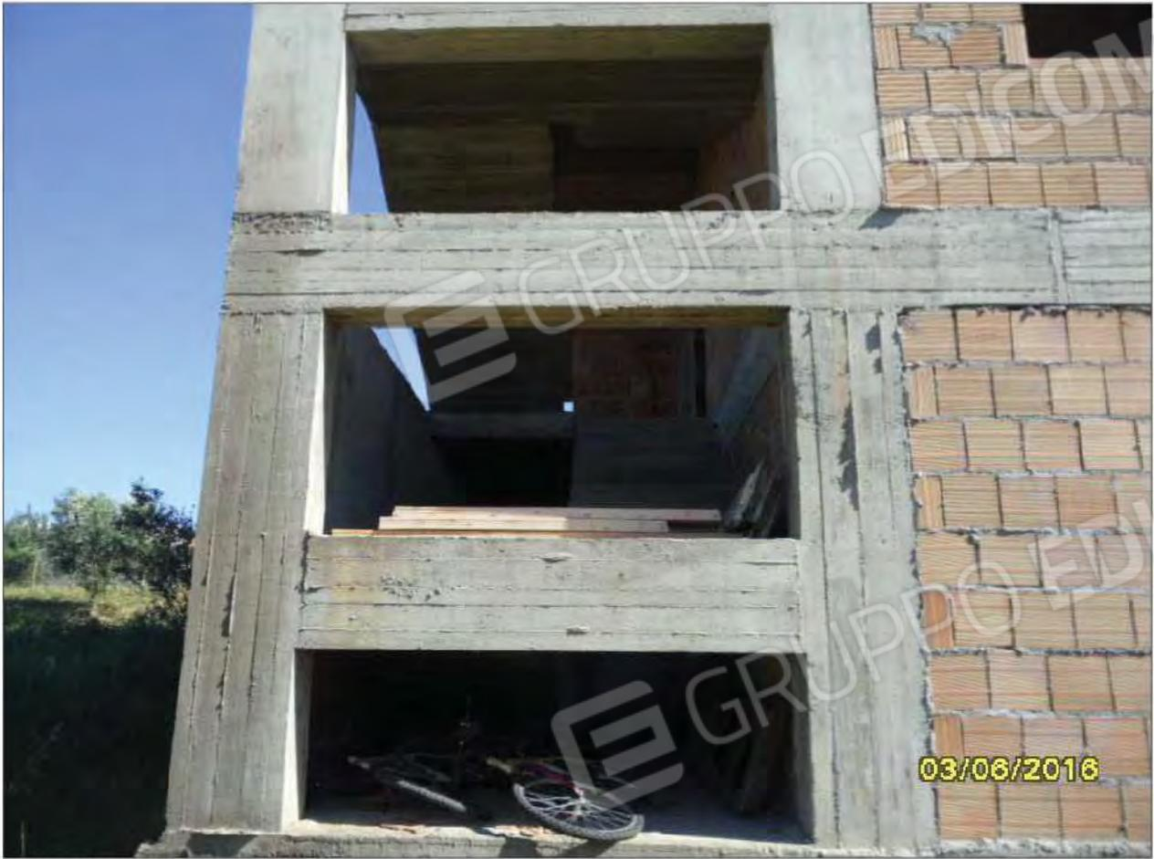
Fotografia n.29 – Vista del Fabbricato in cls.a., particolare della scala di collegamento ai piani.
