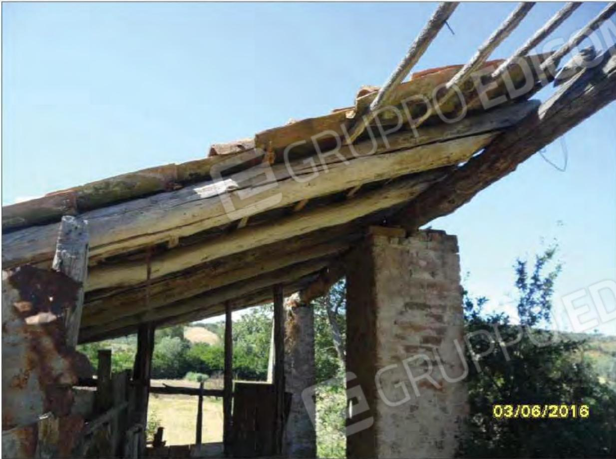
Fotografia n.21 – Particolare dello stato in cui versa la copertura de Fabbricato Rurale.
