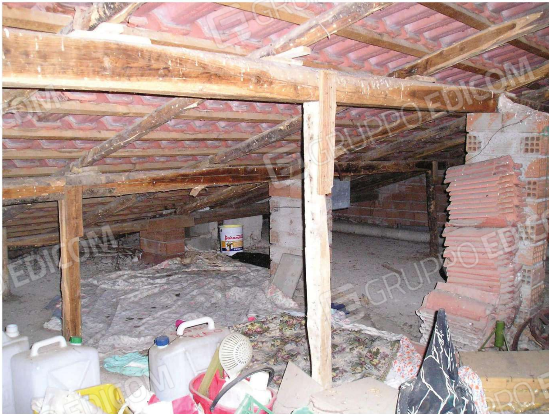
Foto n. 29: immobile 4 – particolare soffitta allo stato rustico
