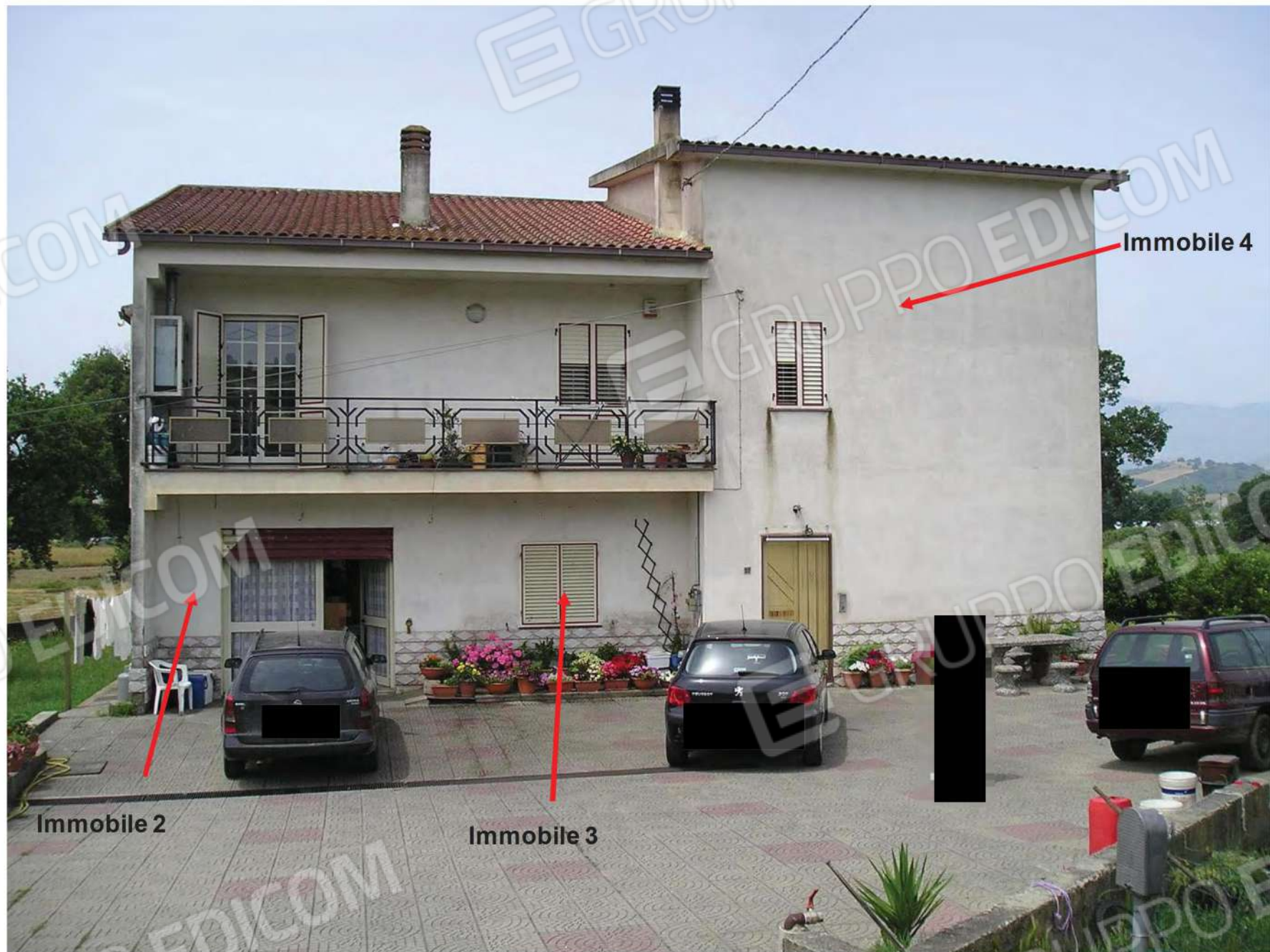
Foto n. 7: fabbricato di cui fanno parte gli immobili 2, 3 e 4.
