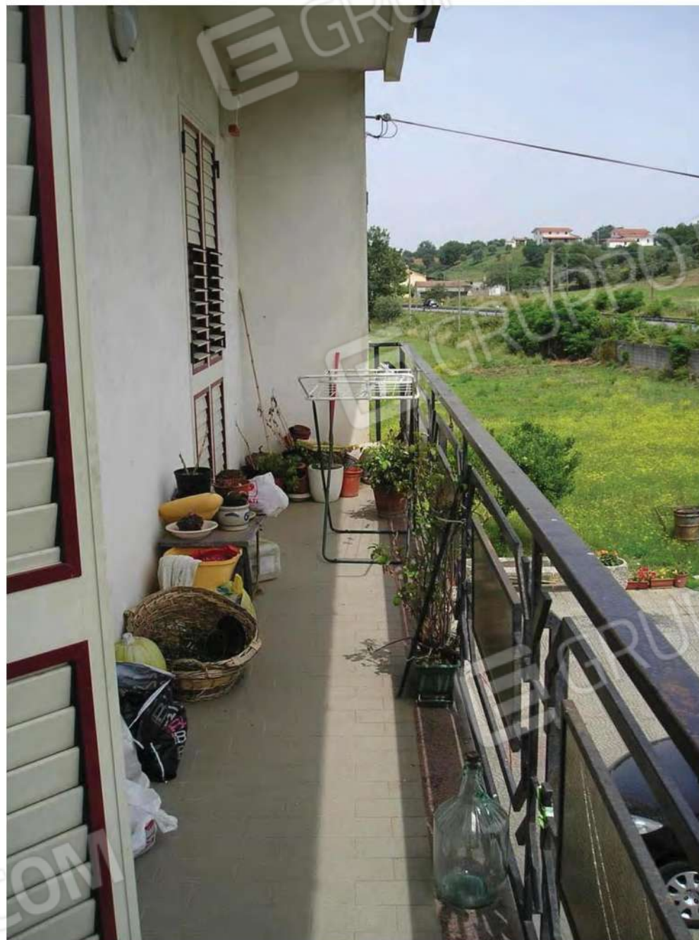
Foto n. 27: immobile 4 – particolare balcone
