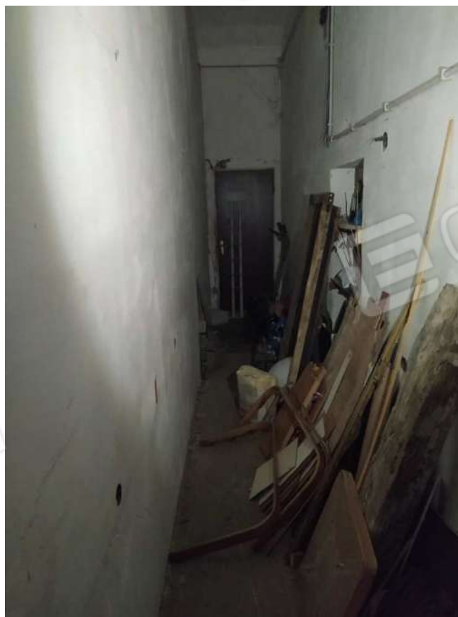
FOTO N° 20 : Comune di Bisignano(CS) – Foglio N° 29 Part. N° 136 Sub. 28 – Ripostiglio annesso
