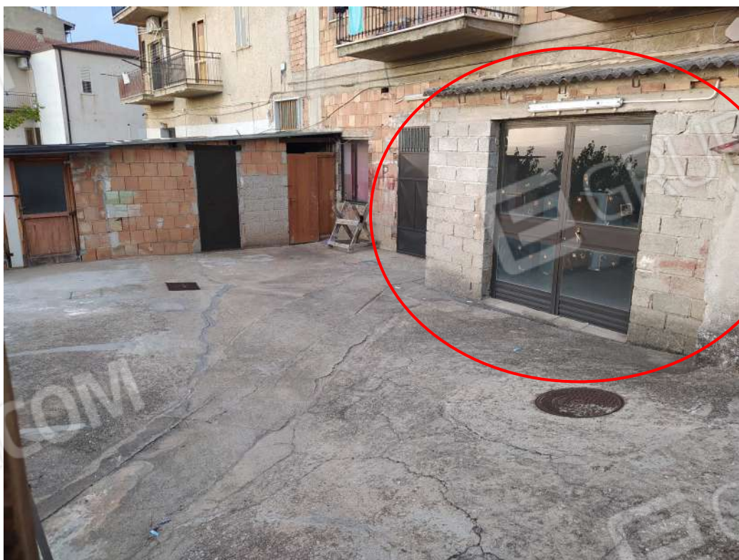
FOTO N° 22 : Comune di Bisignano(CS) – Foglio N° 29 Part. N° 136 Sub. 27 – Dettaglio Ingresso
