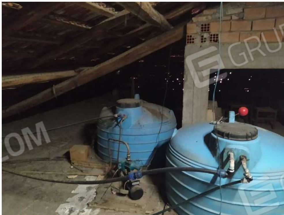
FOTO N° 18 : Comune di Bisignano(CS) – Foglio N° 29 Part. N° 136 Sub. 22 – Soffitta/Sottotetto
