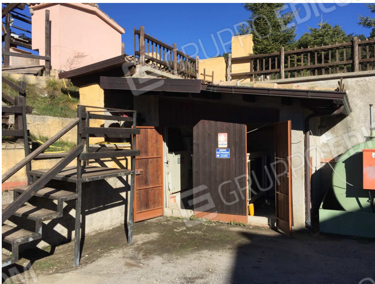
Particella di terreno n° 1162 - locale tecnico per gruppo elettrogeno
