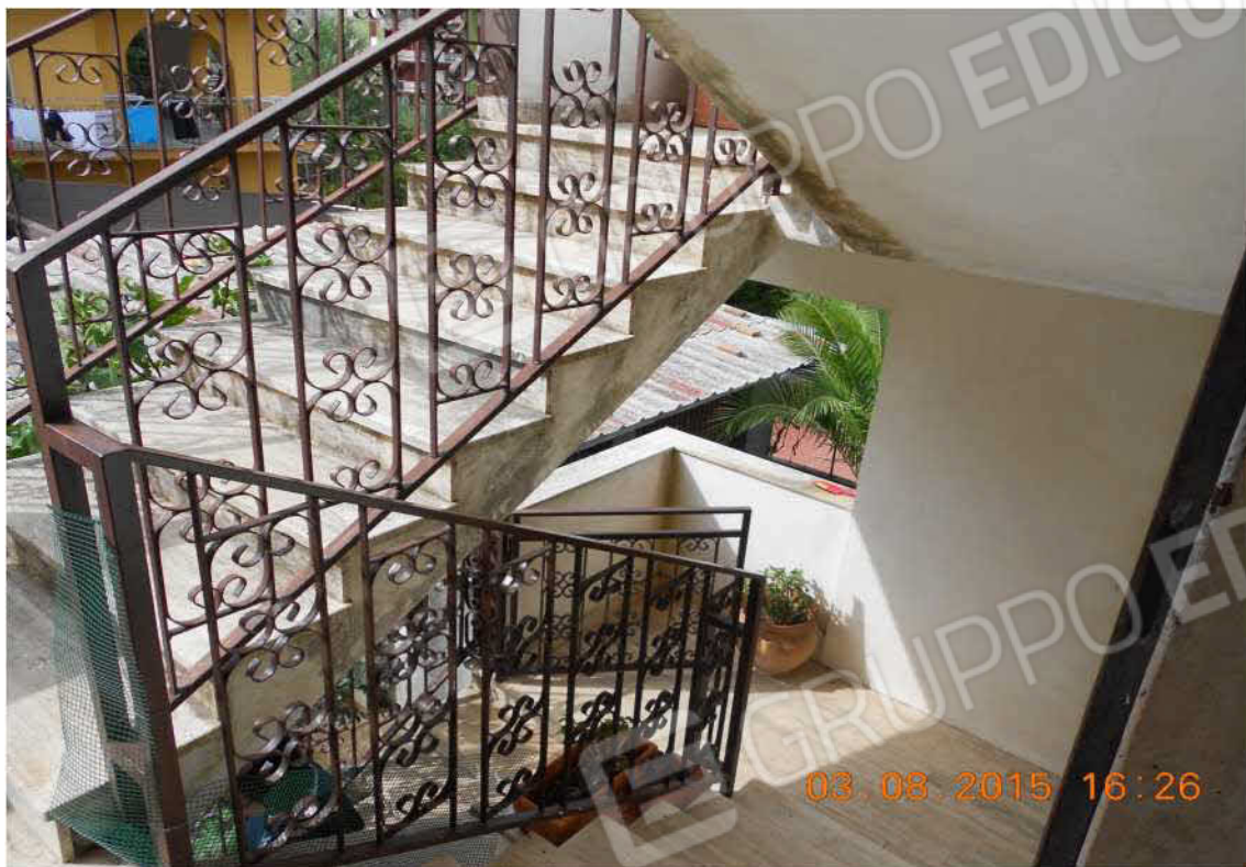
Foto 25– Scala esterna lato posteriore
