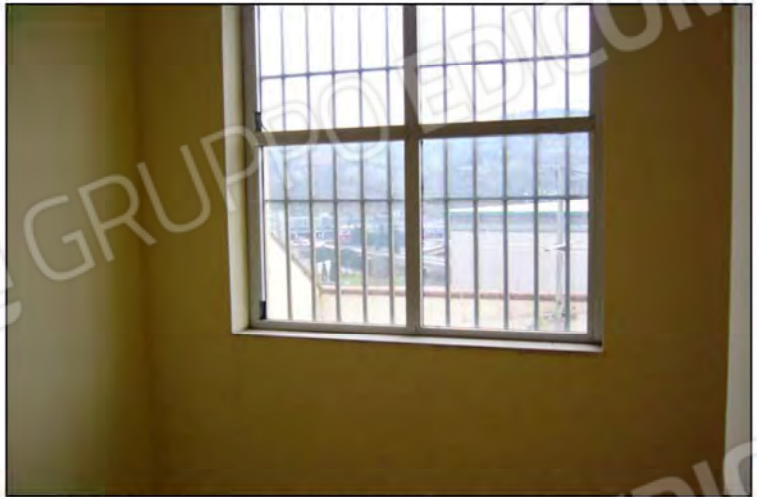
(Foto 22 – finestra vano scala su lastrico solare – Part. n°1094, Sub. 68)
