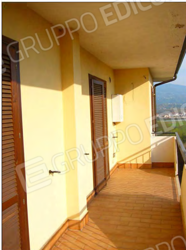
(Foto 83 – balcone appartamento al 2° piano di Via B. Croce – Part. n°1033, Sub. 5)
