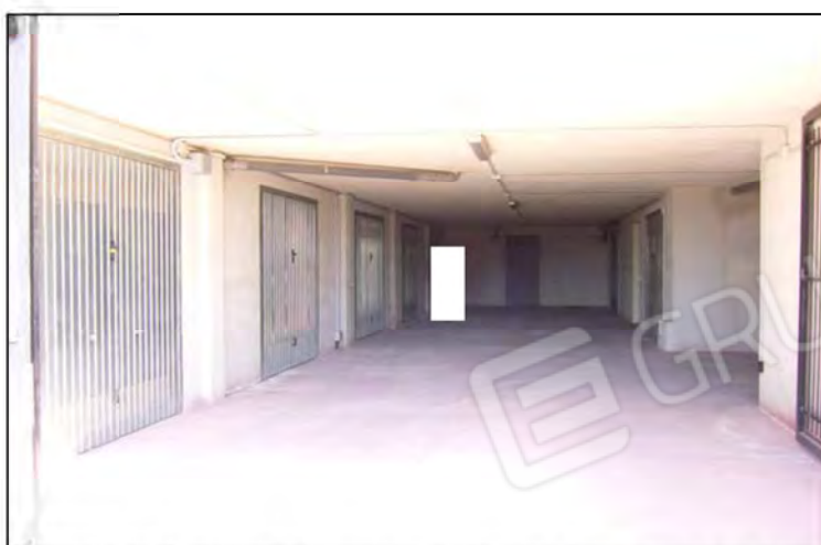
(Foto 30 – Piano 1° Sottostrada fabbricato di Via Trieste – Part. n°754)
