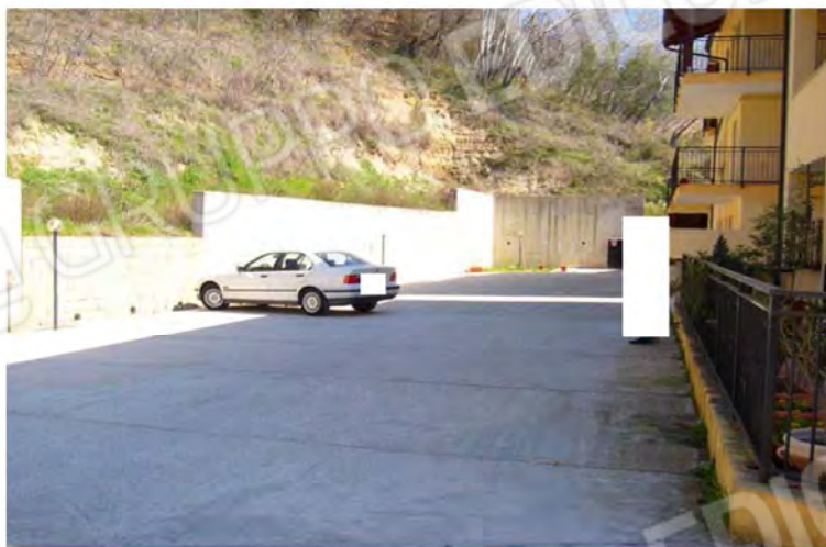
(Foto 60 – corte fabbricato di Via Trieste – Part. n°753)
