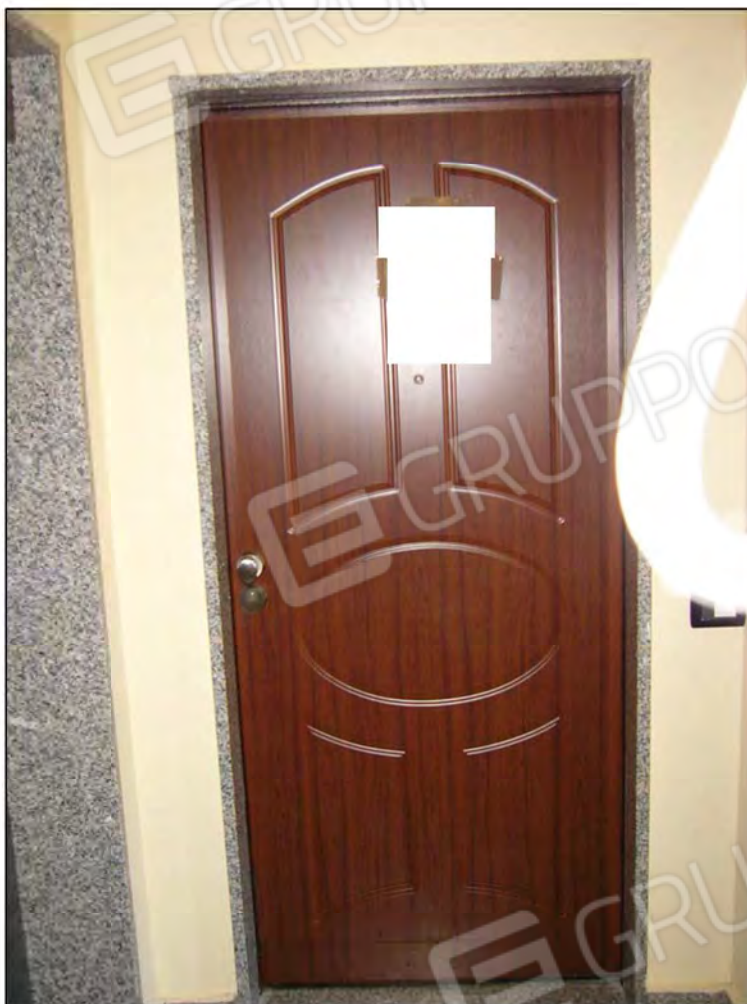
(Foto 47 – Soffitta / Mansarda al piano 3° di Via Trieste – Part. n°754, Sub. 36)
