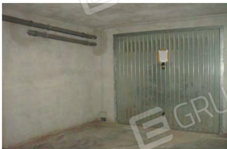
(Foto 39 – Box garage di Via Trieste – Part. n°754, Sub. 10)
