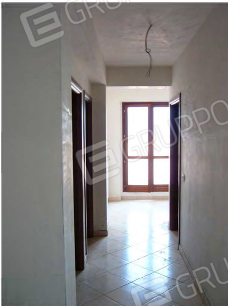
(Foto 91 – appartamento al 3° piano di Via B. Croce – Part. n°1033, Sub. 6)
