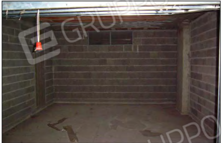
(Foto 35 – Box garage di Via Trieste – Part. n°754, Sub. 14)
