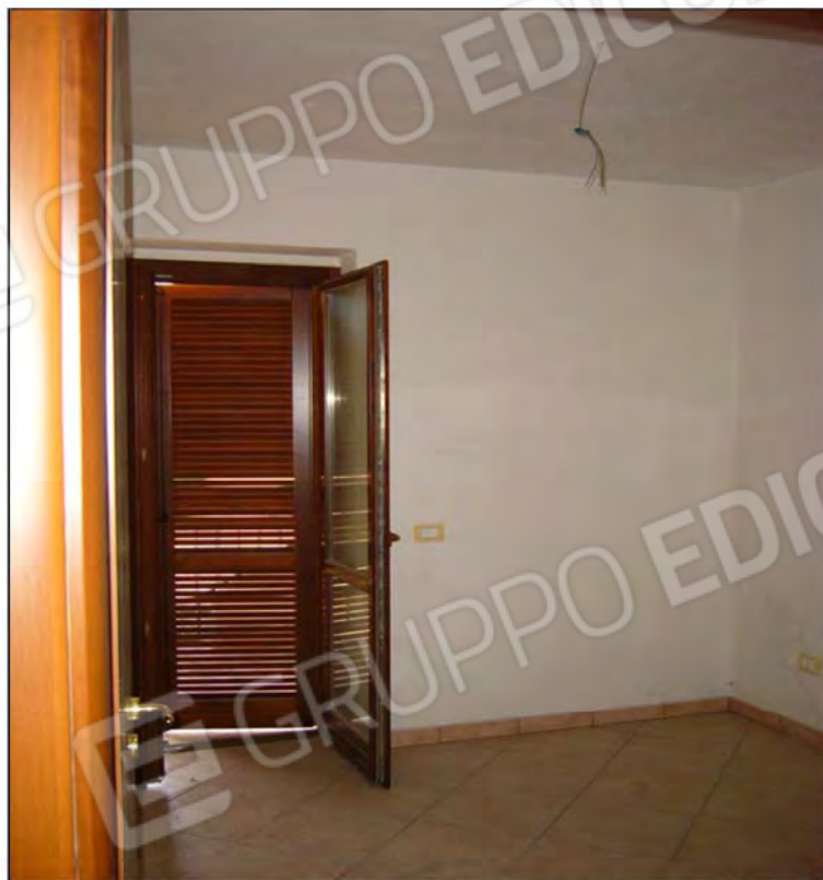
(Foto 77 – appartamento 2° piano di Via B. Croce – Part. n°1033, Sub. 5)
