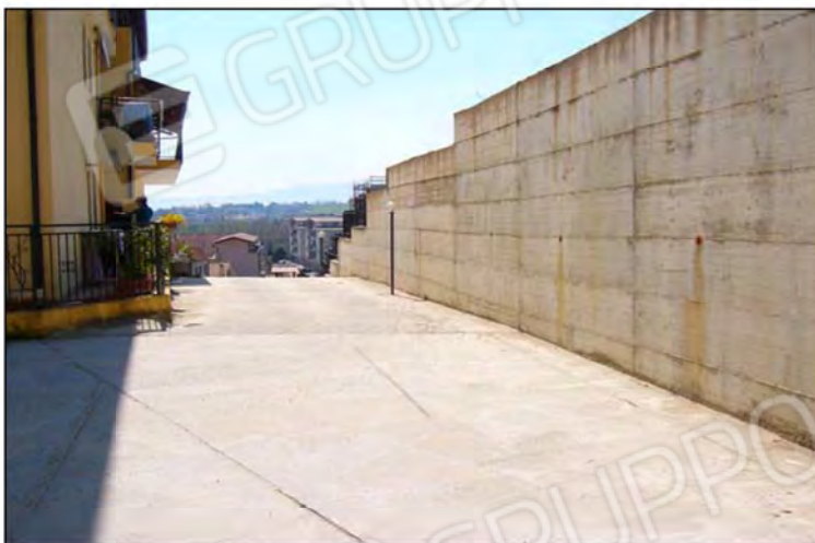
(Foto 61 – corte fabbricato di Via Trieste – Part. n°755)
