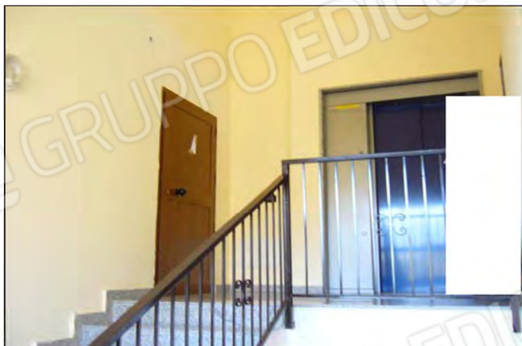
(Foto 46 – pianerottolo scala al piano 3° di Via Trieste – Part. n°754, Sub. 36 e 37)
