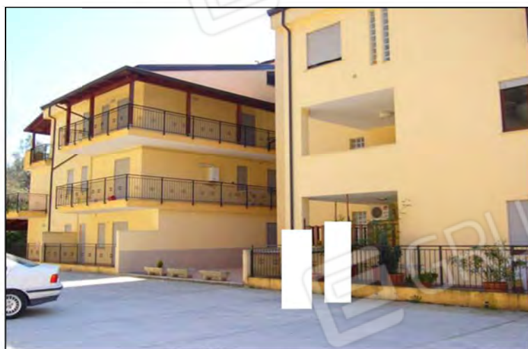
(Foto 59 – corte fabbricato di Via Trieste – Part. n°753)
