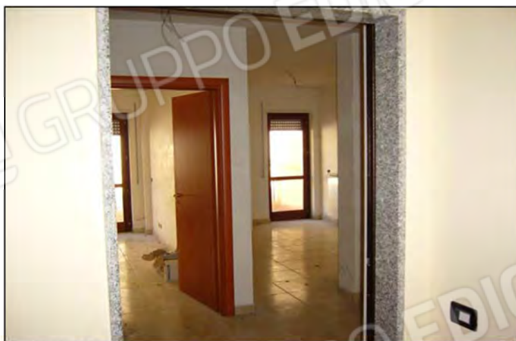
(Foto 40 – appartamento al piano T. di Via Trieste – Part. n°754, Sub. 23)
