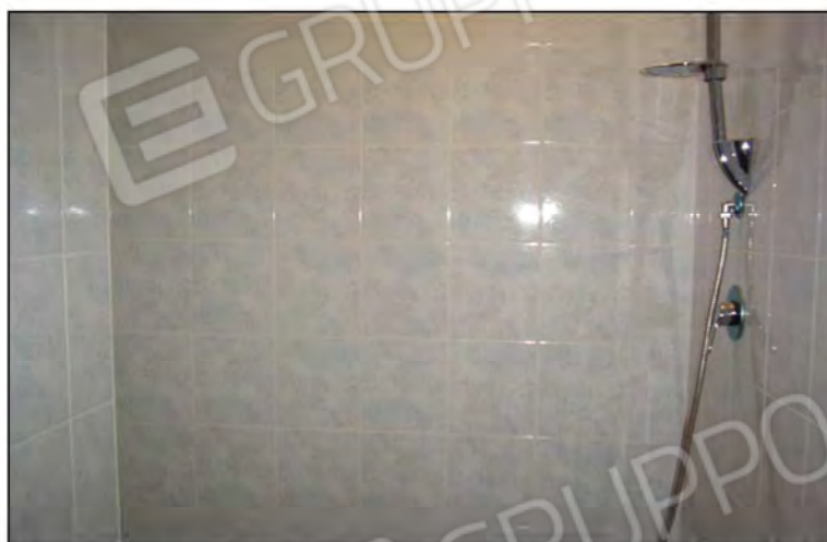
(Foto 58 – Soffitta al piano 3° di Via Trieste – Part. n°754, Sub. 37)
