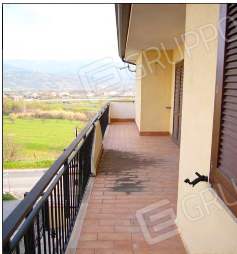
(Foto 82 – balcone appartamento 2° piano di Via B. Croce – Part. n°1033, Sub. 5)
