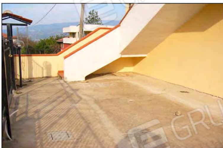
(Foto 104 – corte appartamento al 3° piano di Via B. Croce – Part. n°1033, Sub. 13)
