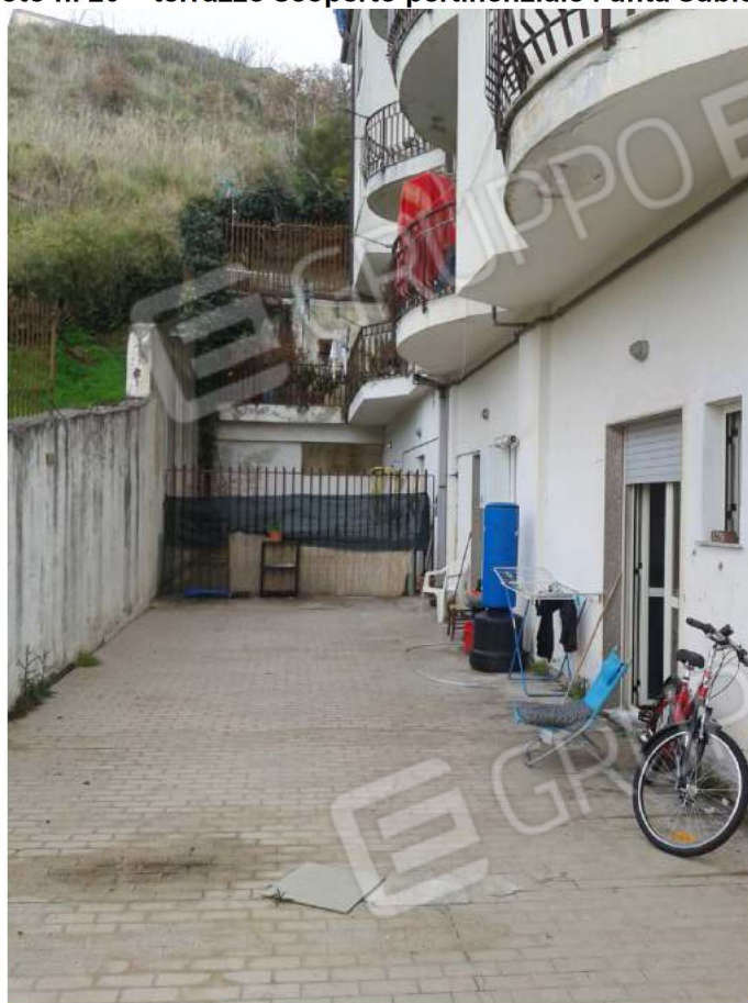
Foto n. 20 – terrazzo scoperto pertinenziale . unità sub.32.
