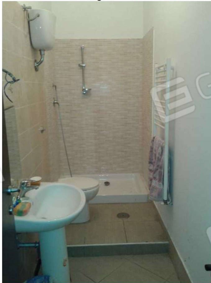
Foto n. 18 – bagno 1– unità sub.32.
