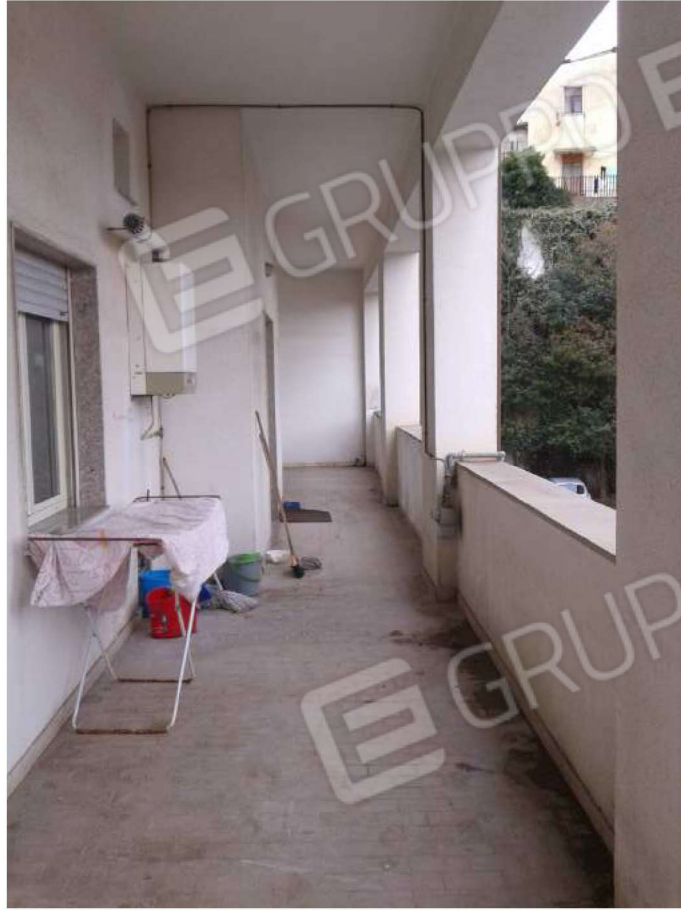
Foto n. 11 – terrazzo coperto pertinenziale . unità sub.33.
