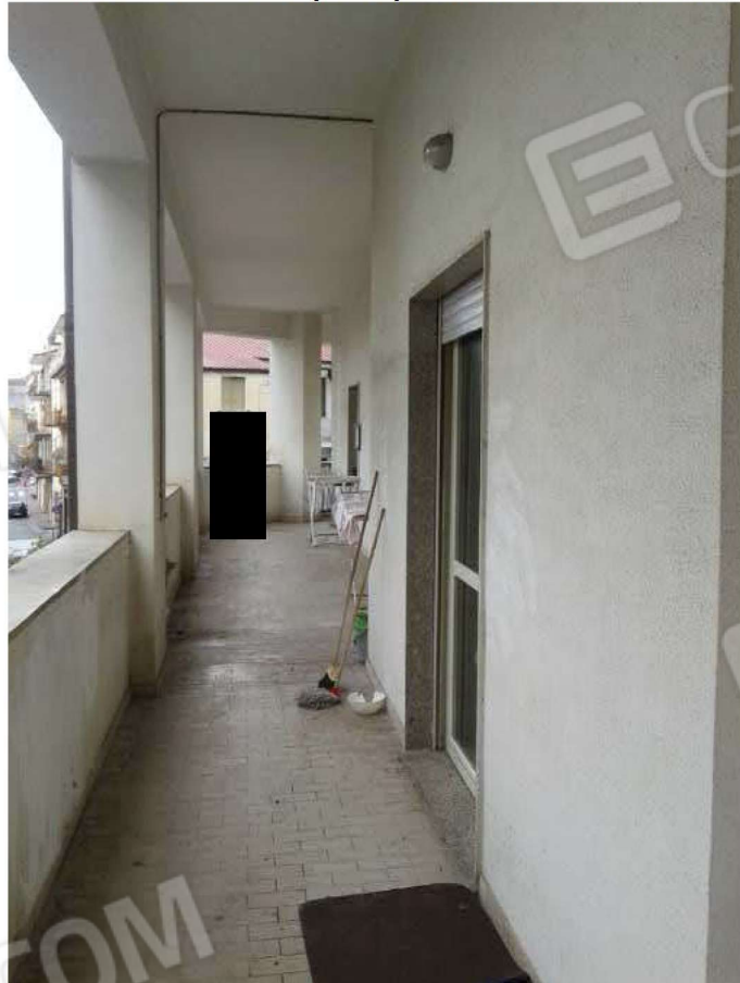
Foto n. 12 – terrazzo coperto pertinenziale . unità sub.33.
