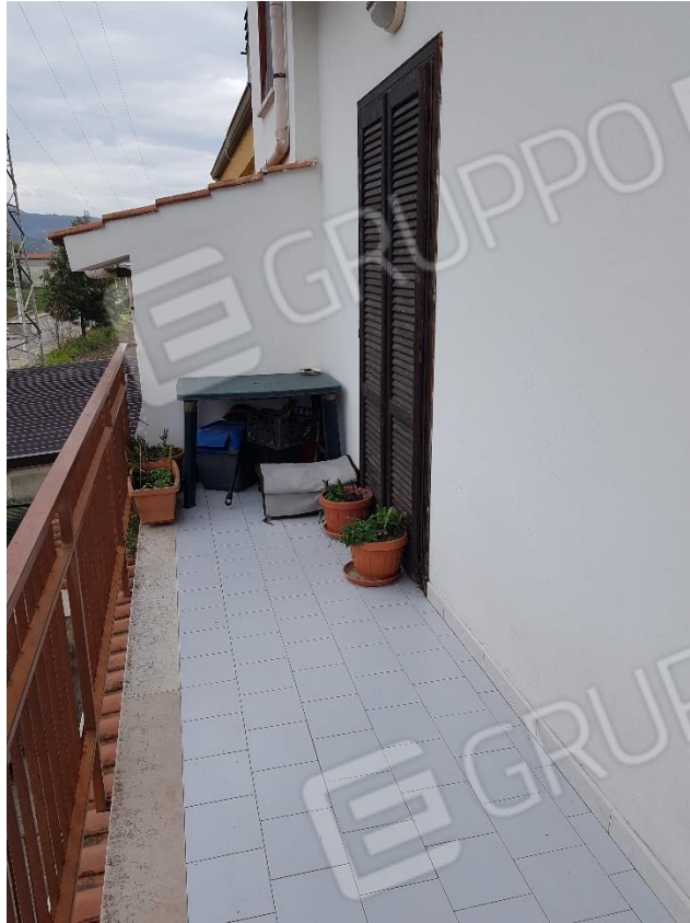
Foto n.8a: balcone facciata est, vista da nord
