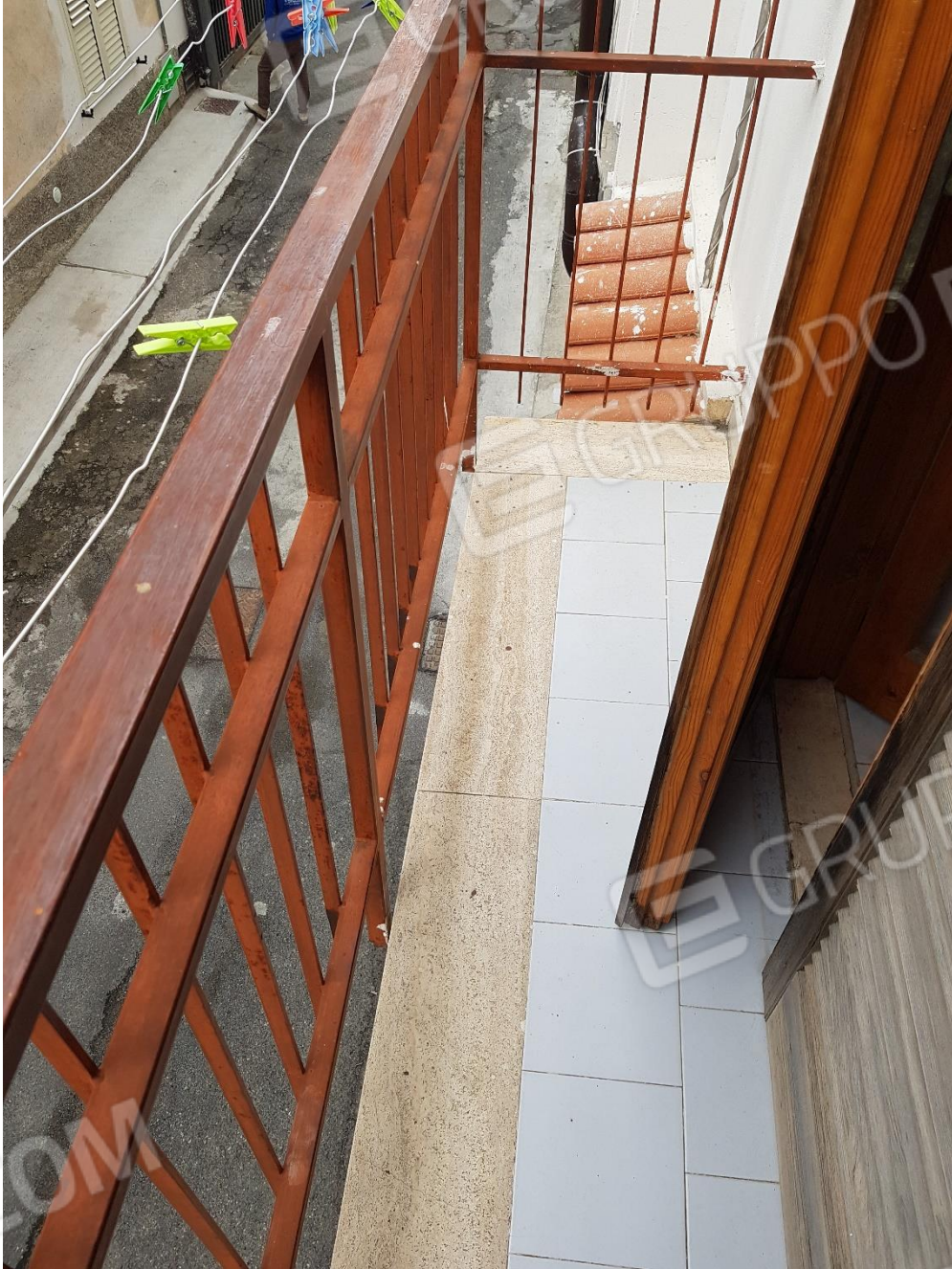
Foto n.11: particolare balcone su facciata ovest
