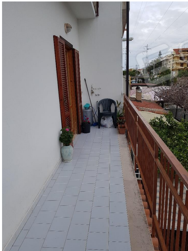
Foto n.8b: balcone facciata est, vista da sud
