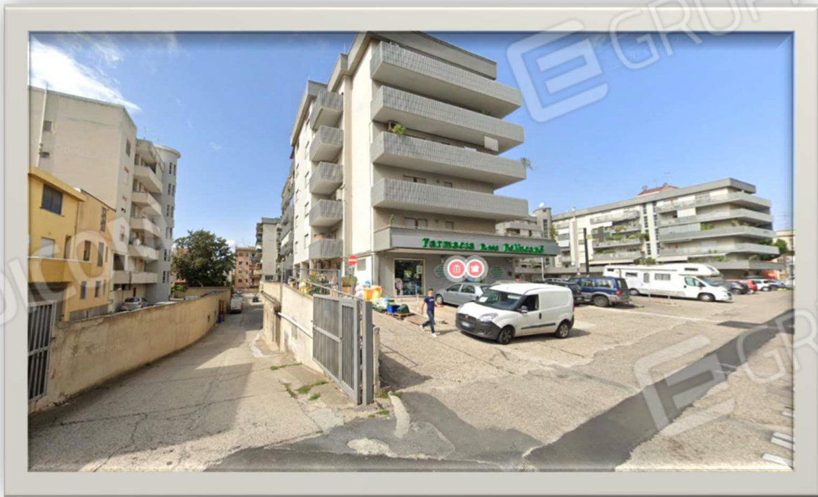
Fig. 5.2.1.1. Edificio "D" (1971) - Via C. Matteotti, 1 - 40138 Bologna
