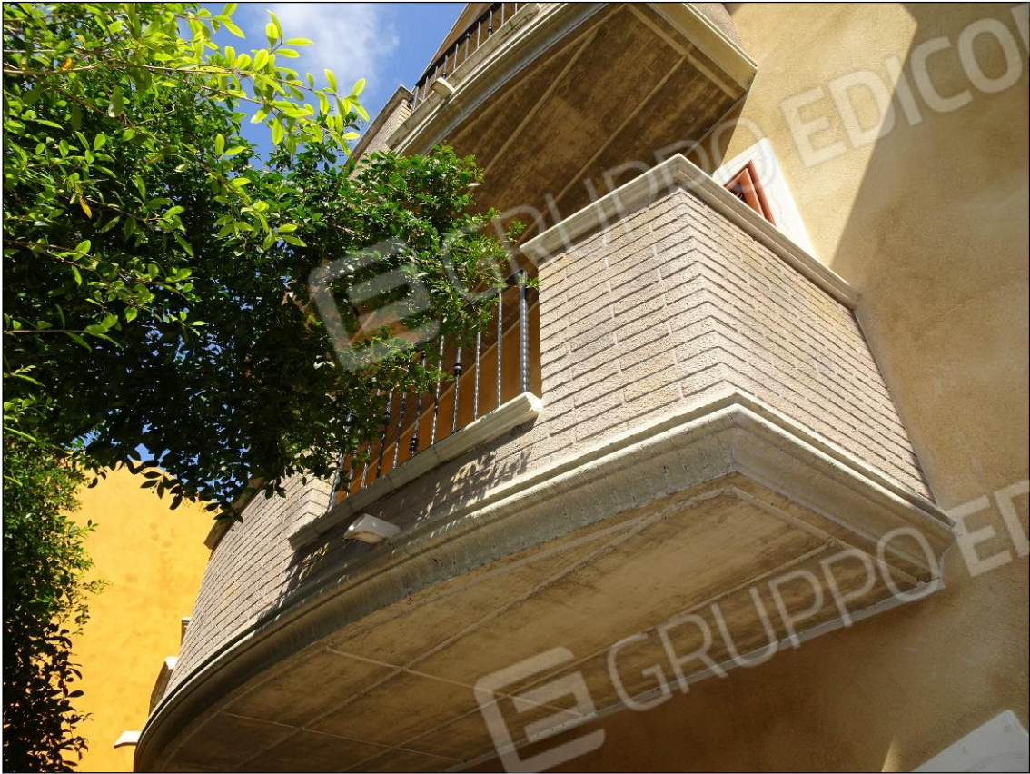
Foto 13: Vista particolare balcone piano primo
