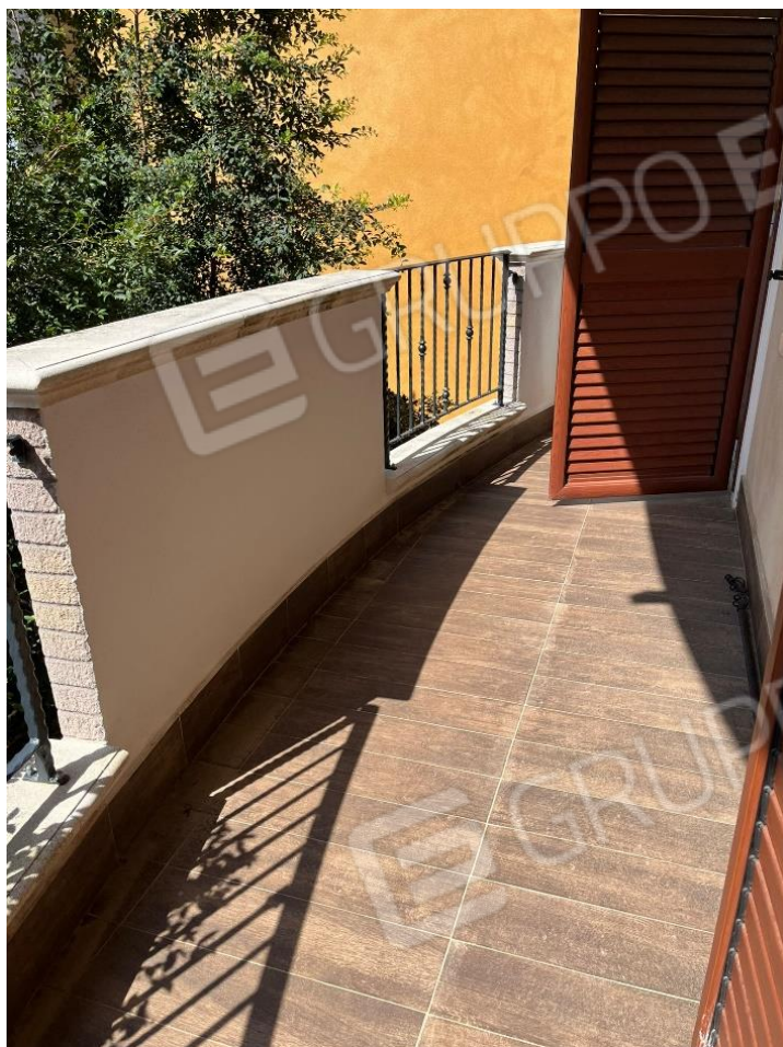
Foto 19: Vista balcone - piano primo villetta
