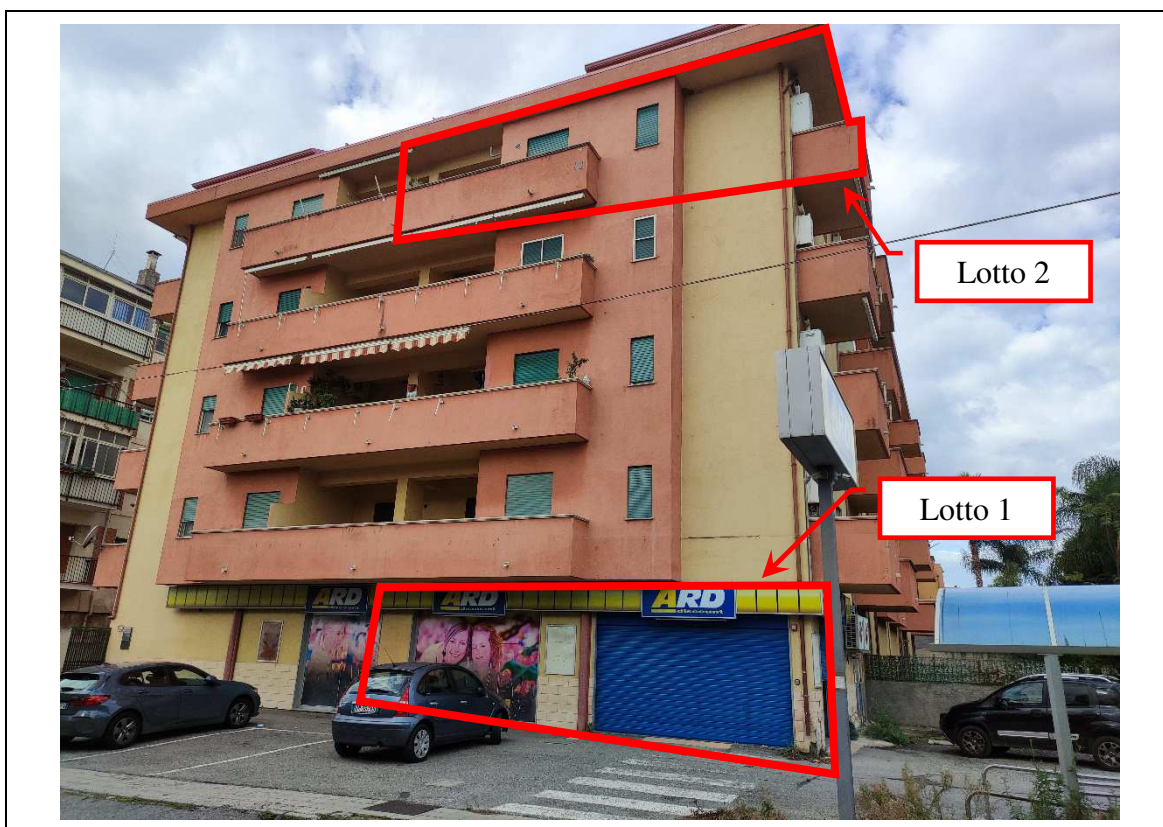
Figura 2- Vista esterna dell'edificio polifunzionale con indicazione ( in rosso) della posizione degli immobili pignorati
