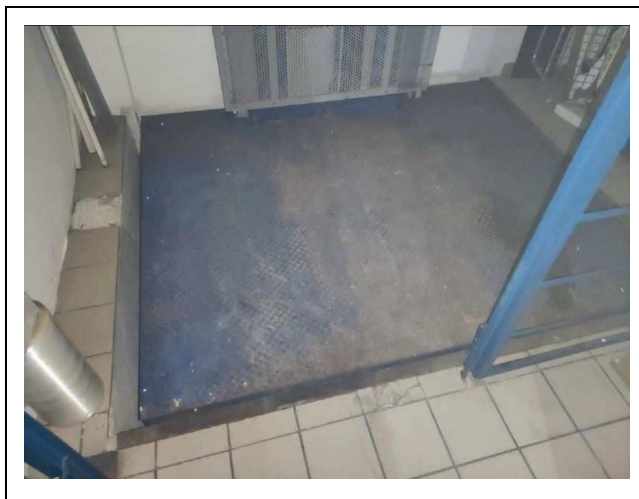
Figura 5- Vista del montacarichi
