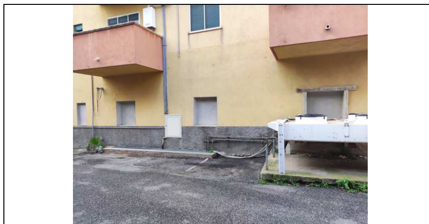
Figura 4- Vista prospetto esterno lato ovest dell’immobile particolare aperture murate
