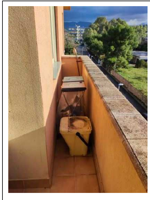
Figura 22- Vista del balcone 3
