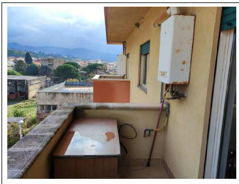
Figura 21- Vista dei balconi 1 e 2
