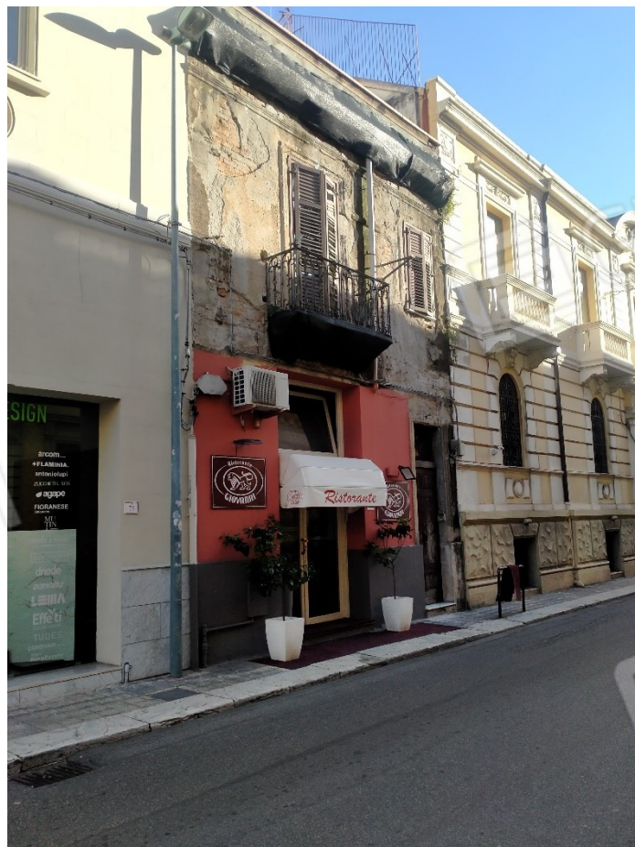
Foto n. 2 – Prospetto via Torrione
