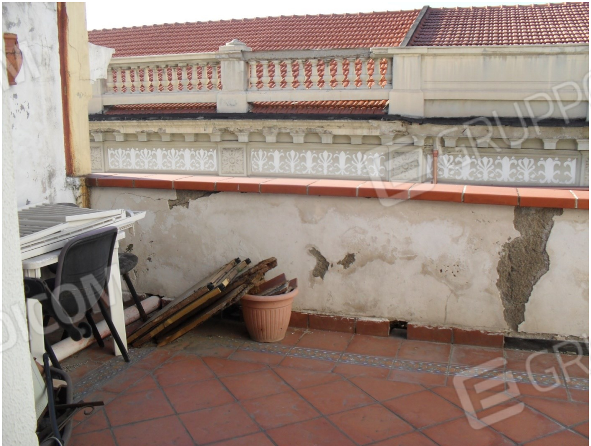
Foto n. 6 – Particolare parapetto al secondo piano
