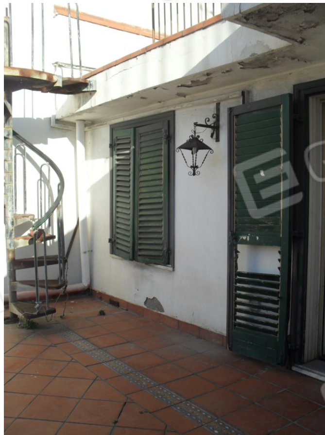
Foto n. 4– Particolare infisso al secondo piano
