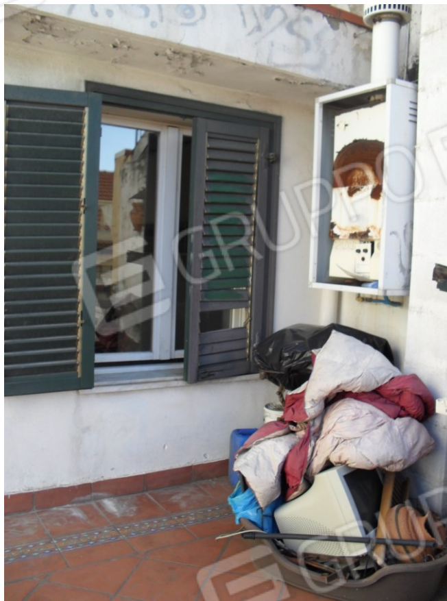
Foto n. 3 – Particolare infisso al secondo piano
