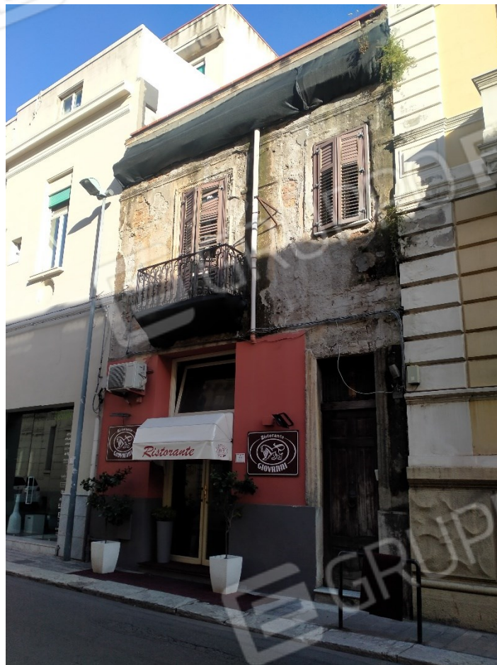
Foto n. 1 – Prospetto via Torrione
