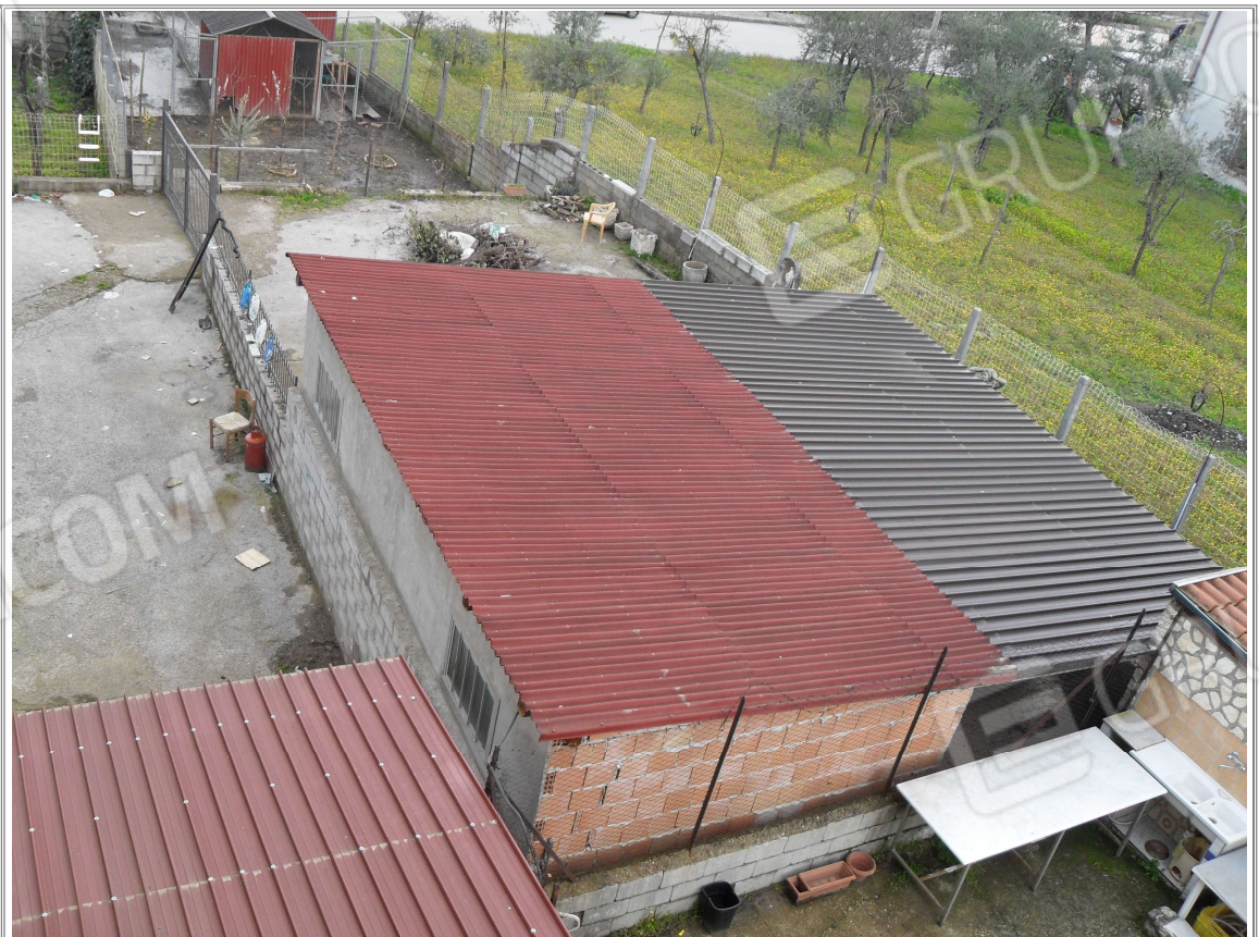
Foto n° 1.16 Immobile n.1 : Corte e tettoie
