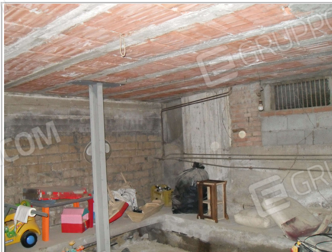
Foto n° 2.2 Immobile n.2 : Interno
