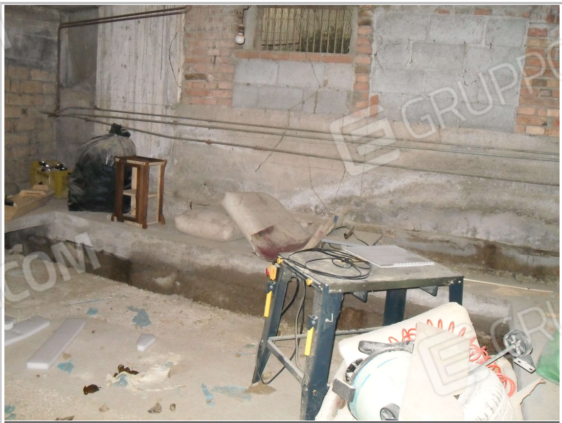
Foto n° 2.4 Immobile n.2 : Interno
