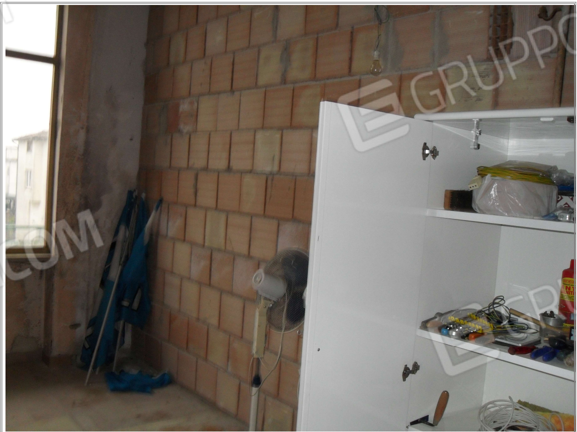
Foto n° 1.10 Immobile n.1 : Interno
