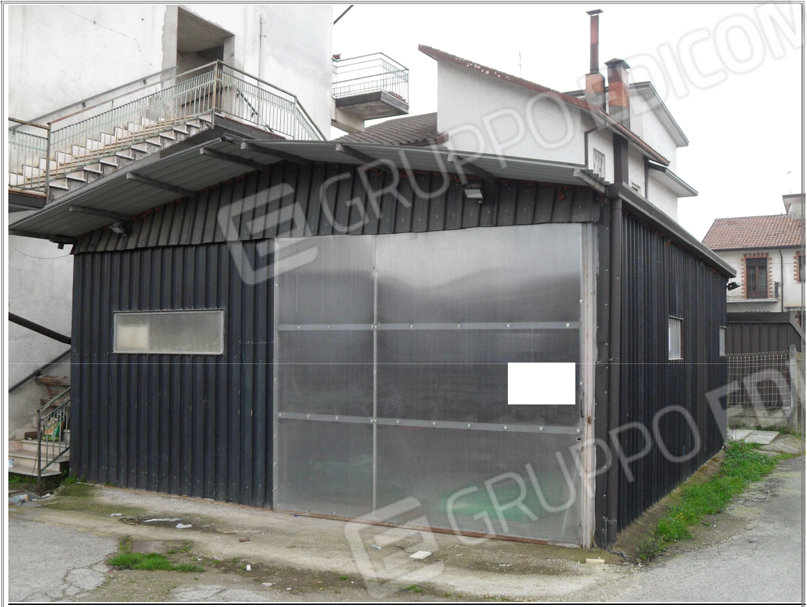
Foto n° 1.17 Immobile n.1 : tettoia e corte
