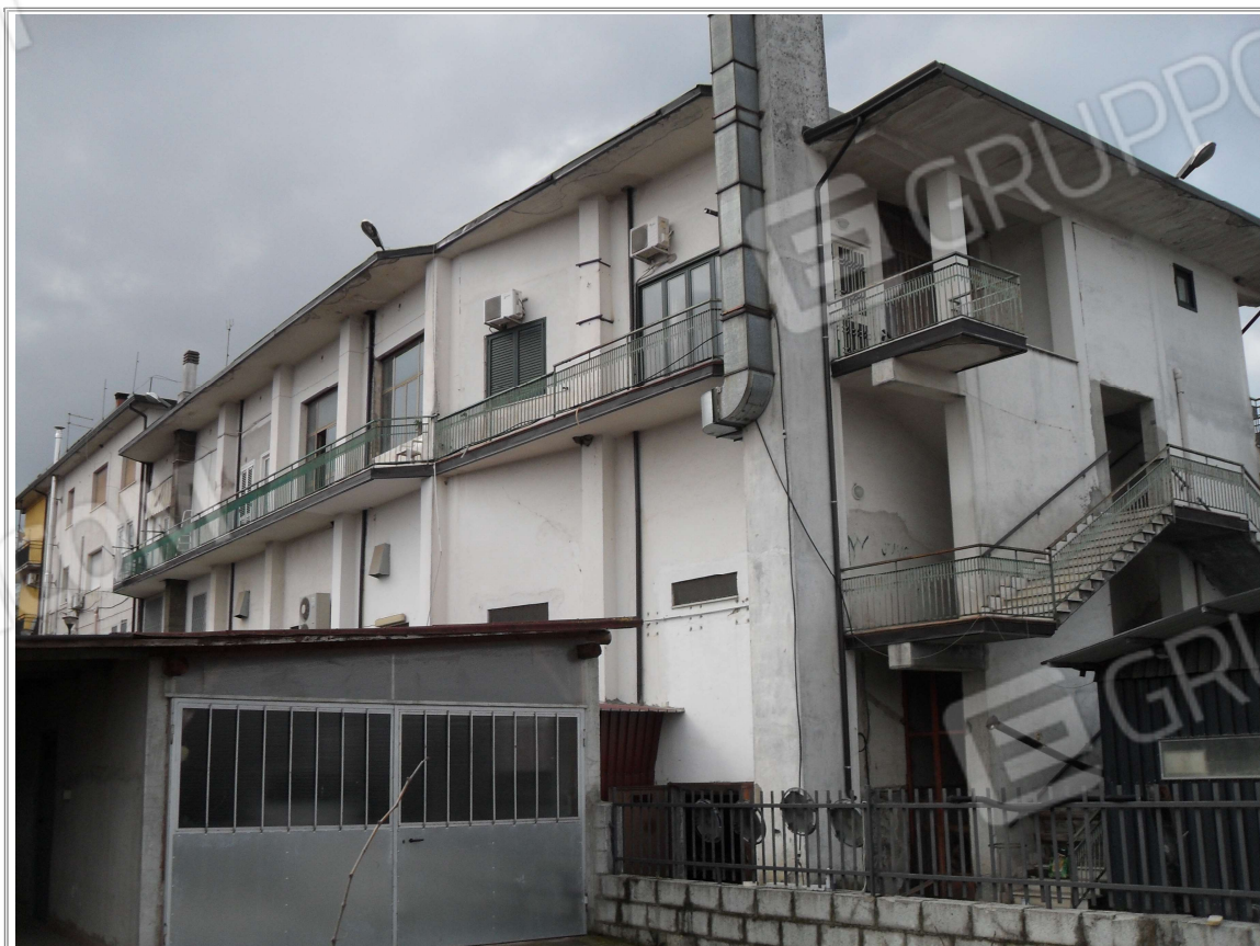
Foto n° 1.2 Immobile n.1 : Prospetto dalla corte
