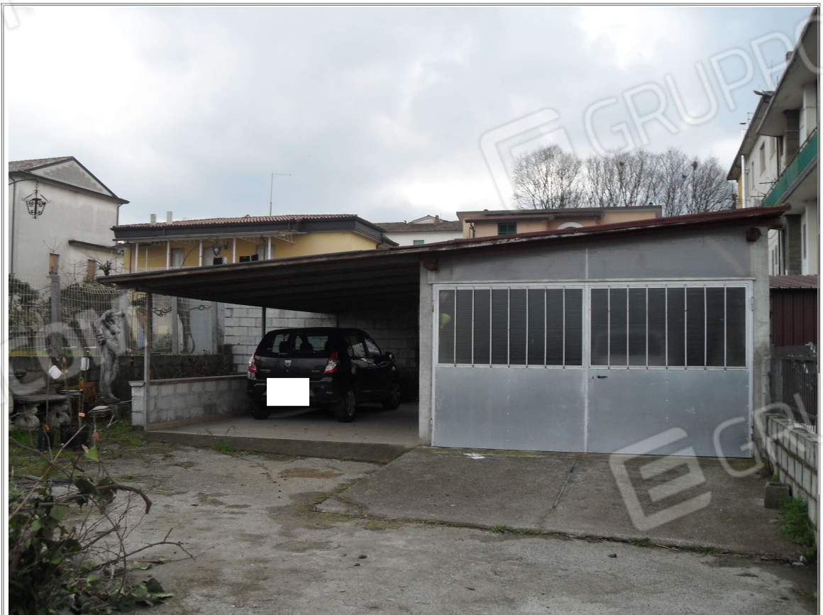
Foto n° 1.18 Immobile n.1 : Corte e tettoie
