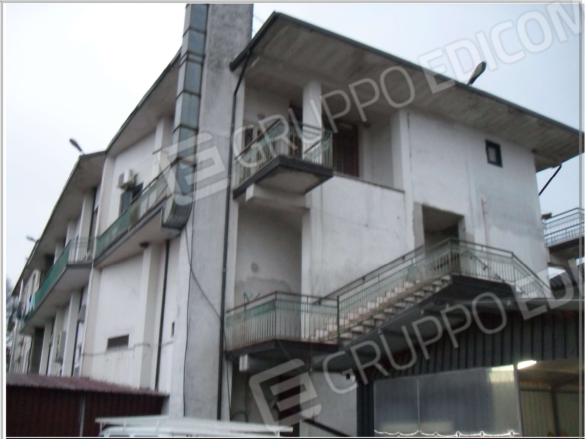
Foto n° 1.3 Immobile n.1 : Prospetto dalla corte
