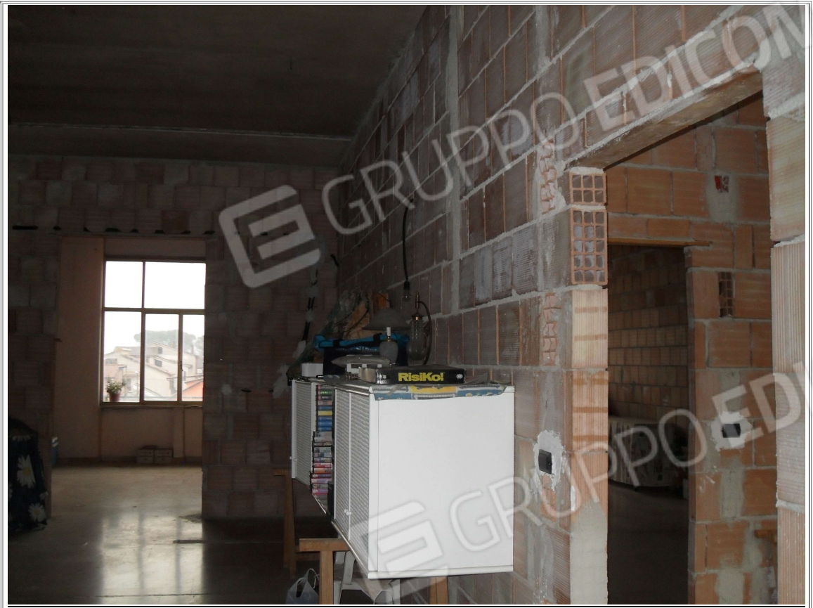
Foto n° 1.9 Immobile n.1 : Interno
