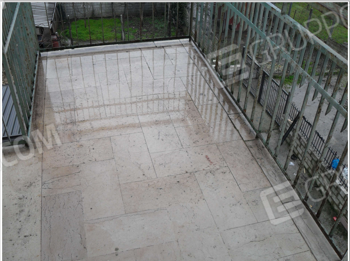
Foto n° 1.4 Immobile n.1 : balconata esterna
