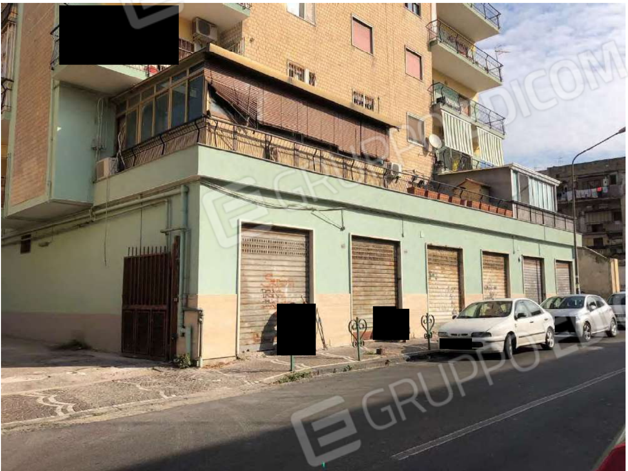
Foto 1 – Vista del fabbricato di corso Protopisani 37, Napoli
