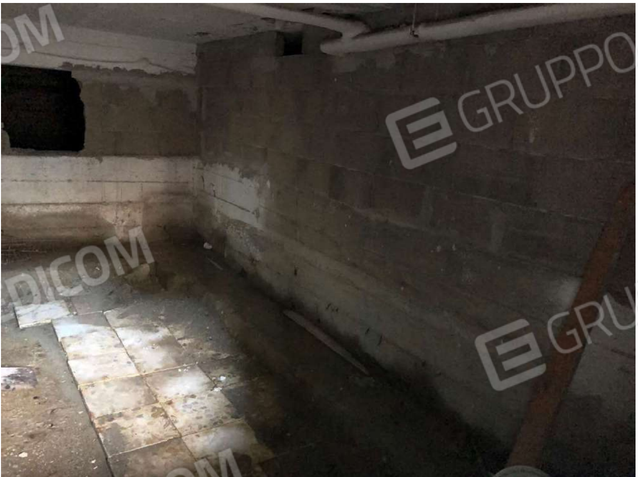
Foto 6 - Vista interna al locale in oggetto
