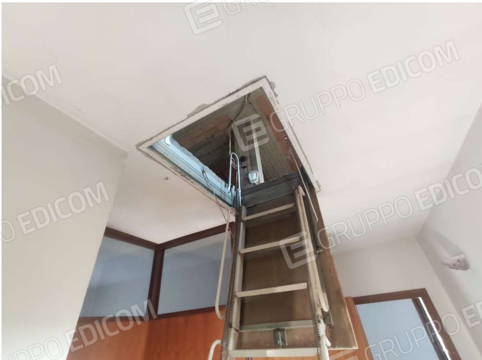
Procedura n.17/2020 - Documentazione Fotografica LOTTO A - VISTE INTERNE PIANO SOTTOTETTO
