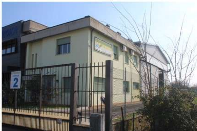
Foto 6: prospetto ovest lato palazzina
