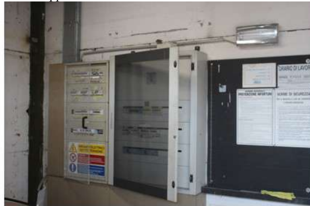
Foto 26: zona ex ripostiglio - sotto al soppalco
