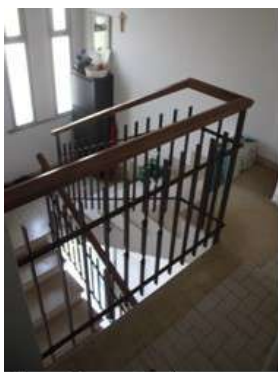
Foto 37: scala di accesso
