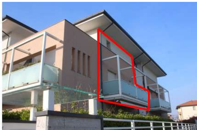
Foto 75: prospetto est su cui affaccia il monolocale
