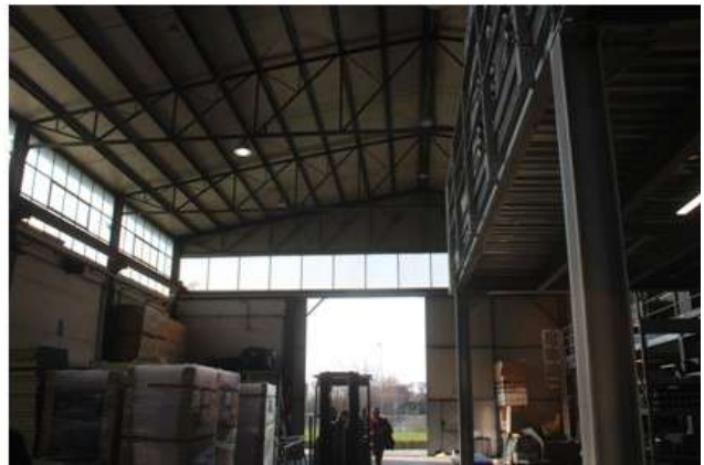
Foto 24: interno - vista verso l'ingresso ovest
