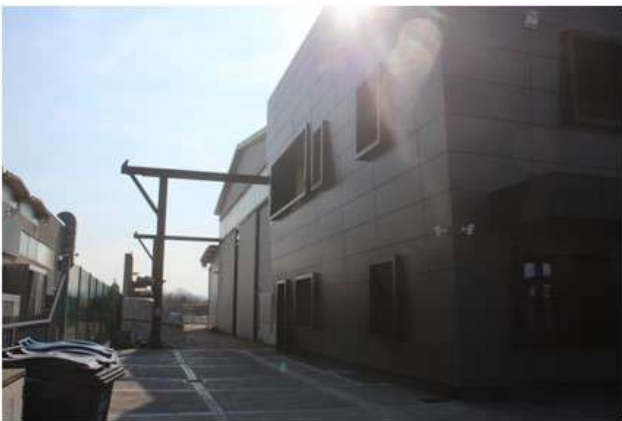
Foto 2: vista sul lato est – nessun divisorio tra le proprietà
