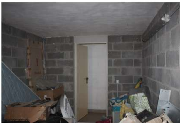
Foto 93: garage – vista verso ingresso pedonale
