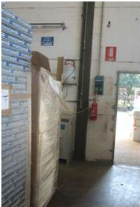
Foto 25: accesso dal retro al capannone
