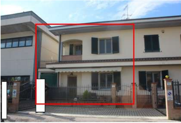
Foto 47: prospetto anteriore su via Karlsruhe
