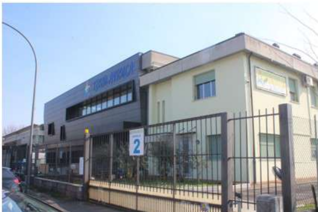
Foto 5: prospetto nord su via Guarini
