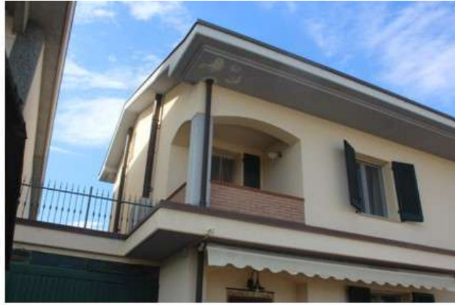
Foto 48: dettaglio prospetto - loggia
