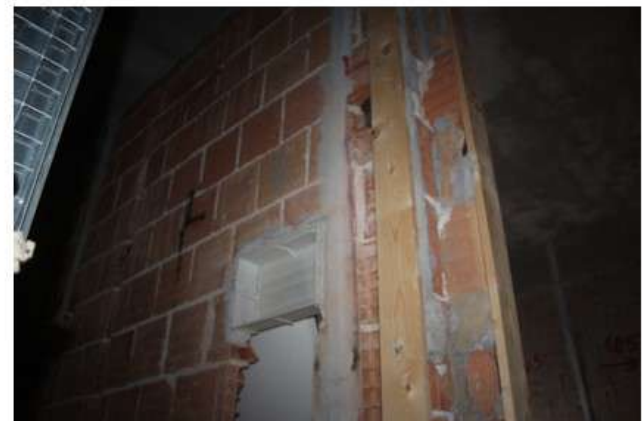
Foto 88: predisposizione bagno al sottotetto
