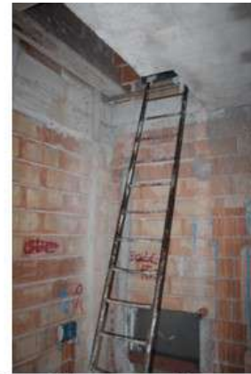
Foto 85: accesso al sottotetto
