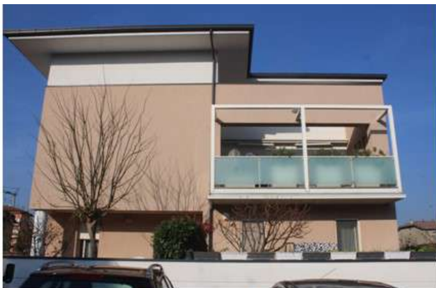
Foto 74: prospetto sud su via Scopeta
