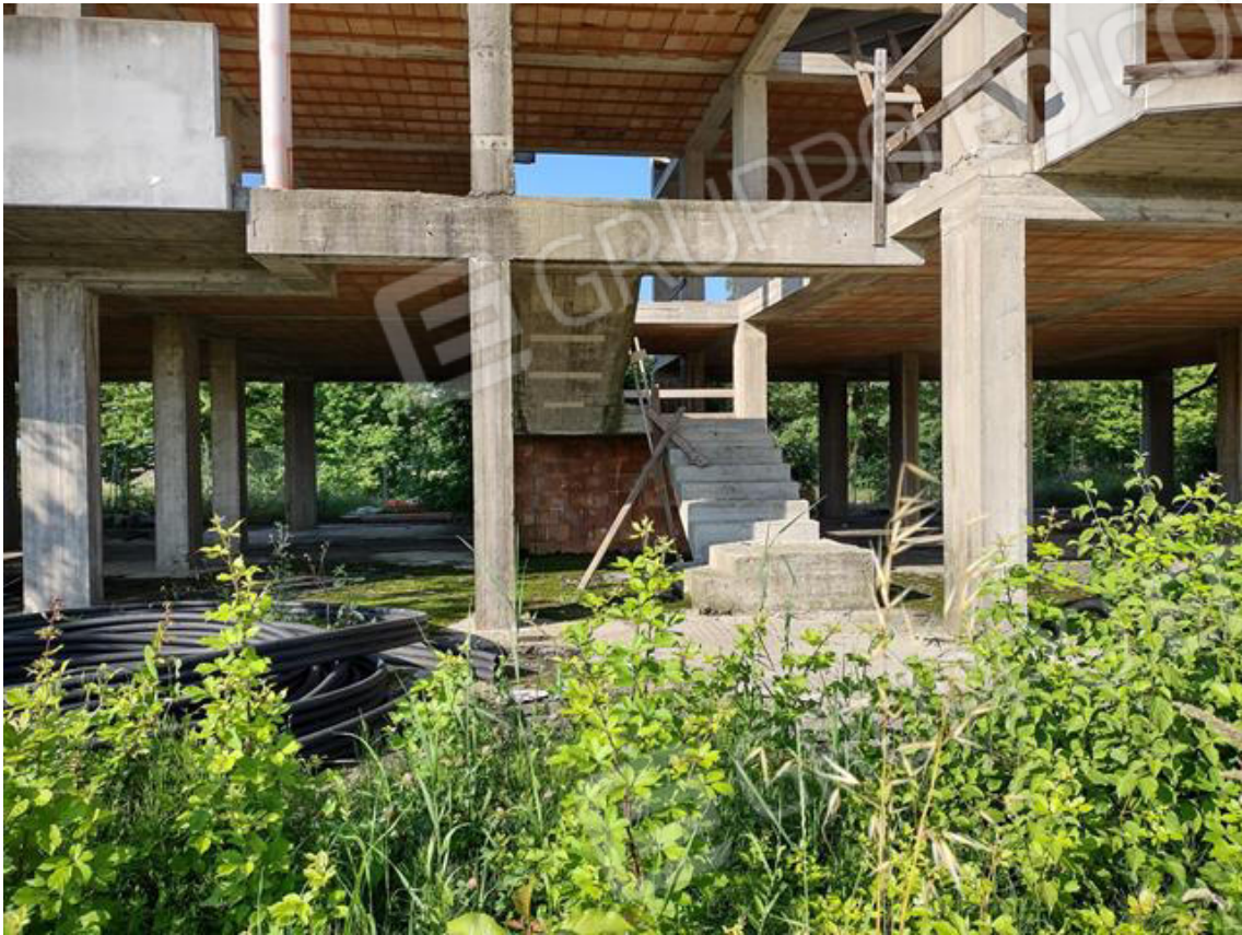
FOTO 7. Fabbricato in costruzione: particolare del piano terra e una scala comune
