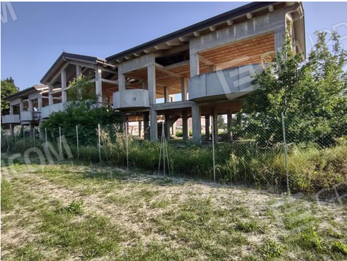
FOTO 4. Fabbricato in costruzione: prospetto Nord-Est
