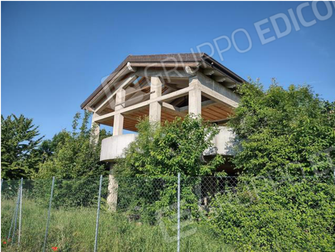
FOTO 3. Fabbricato in costruzione: prospetto laterale Nord-Ovest
