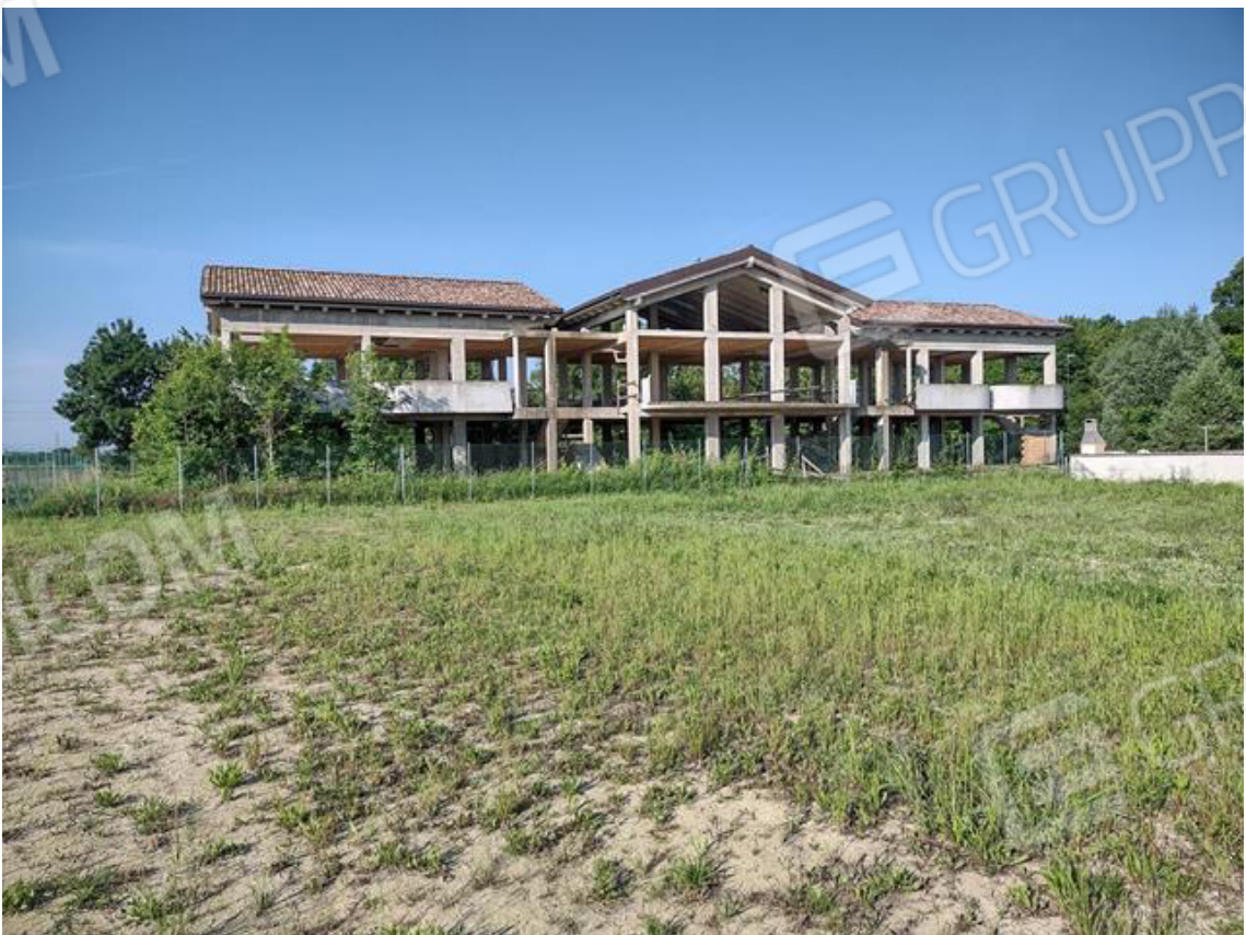
FOTO 2. Fabbricato in costruzione: fronte Nord-Est.
