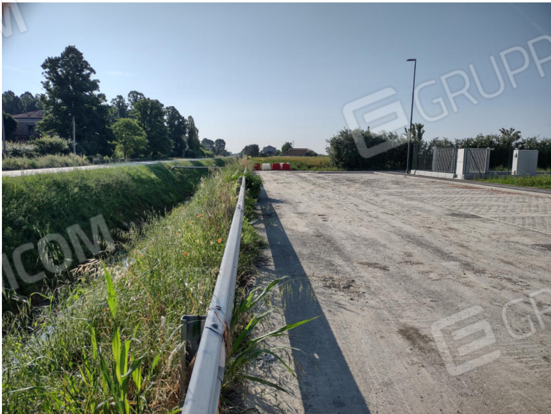
FOTO 12. Particelle di terreno da cedere al Comune di Forlì: Area ora destinata a parcheggio pubblico
