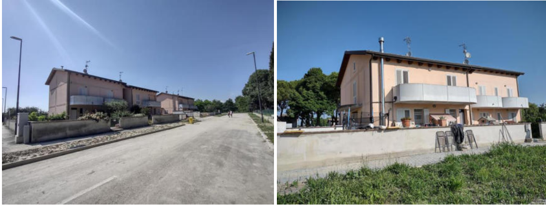
Il fabbricato condominiale:fronte su Via Rassone e retro del blocco 1 con l'appartamento al P.1.
