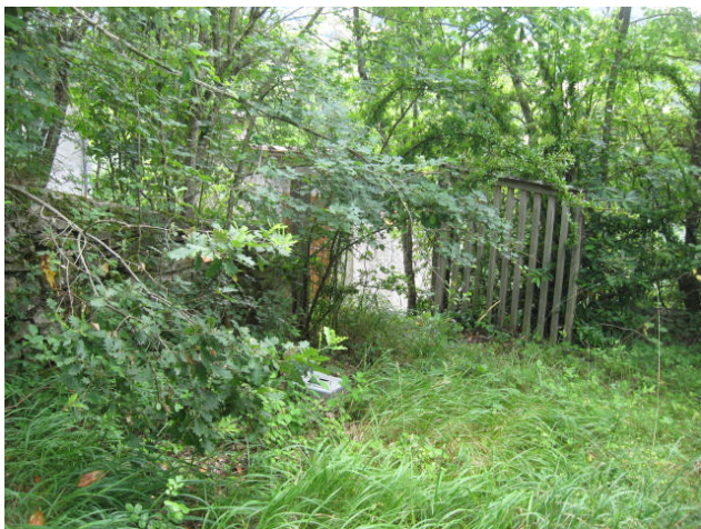
Accesso all'area e porzione del prospetto del fabbricato
