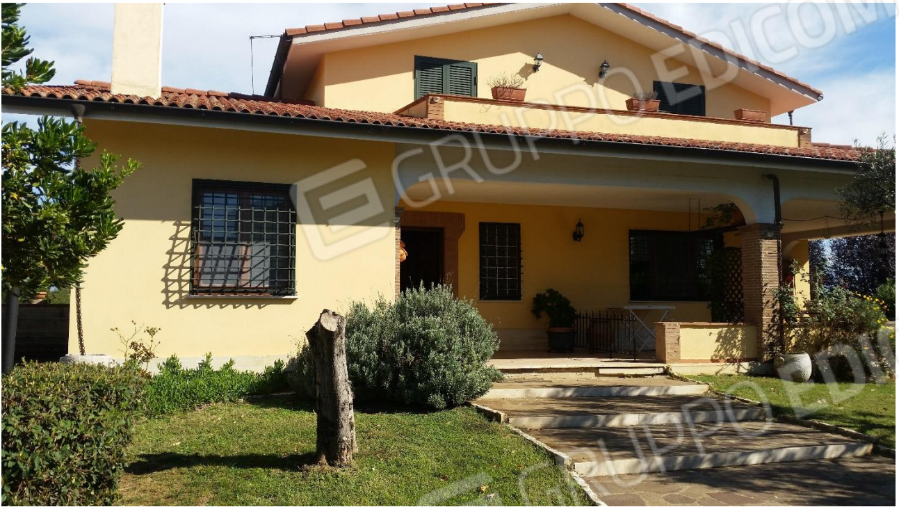
FOTO 1 PROSPETTO PRINCIPALE CON INGRESSO E PORTICO
