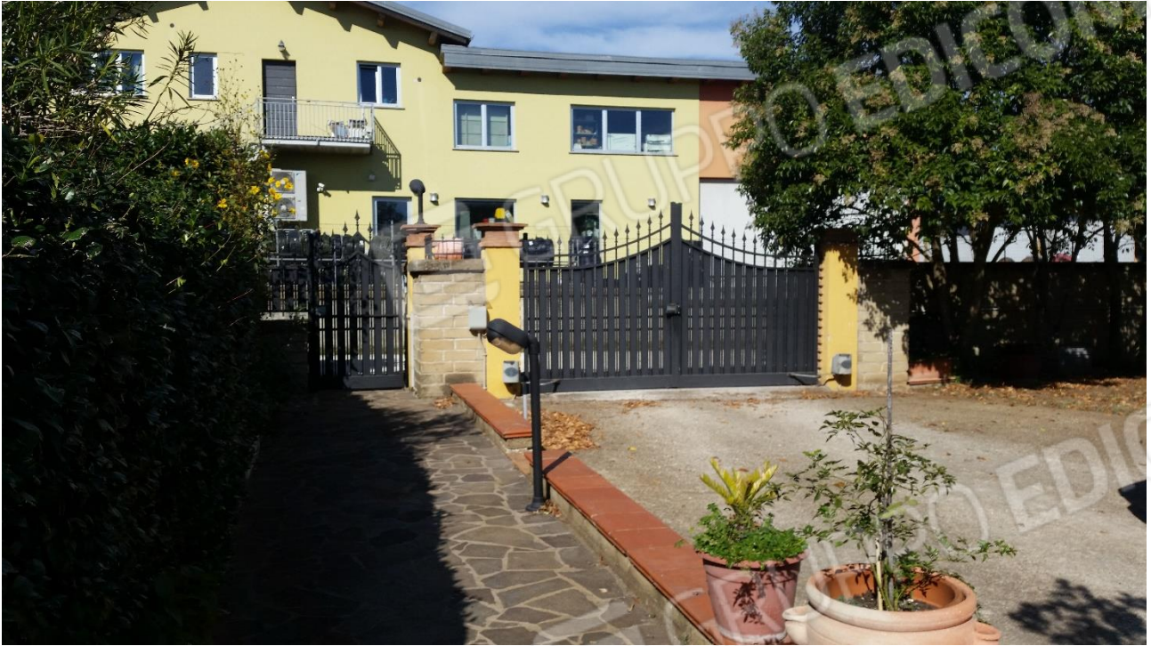
FOTO 3 CANCELLO DI ACCESSO VISTO DALL'INTERNO DELLA CORTE
