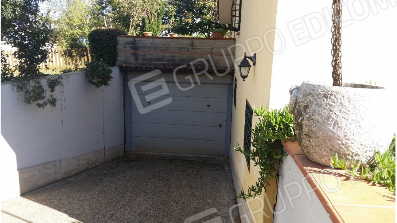
FOTO 15 RAMPA ACCESSO AL PIANO INTERRATO
