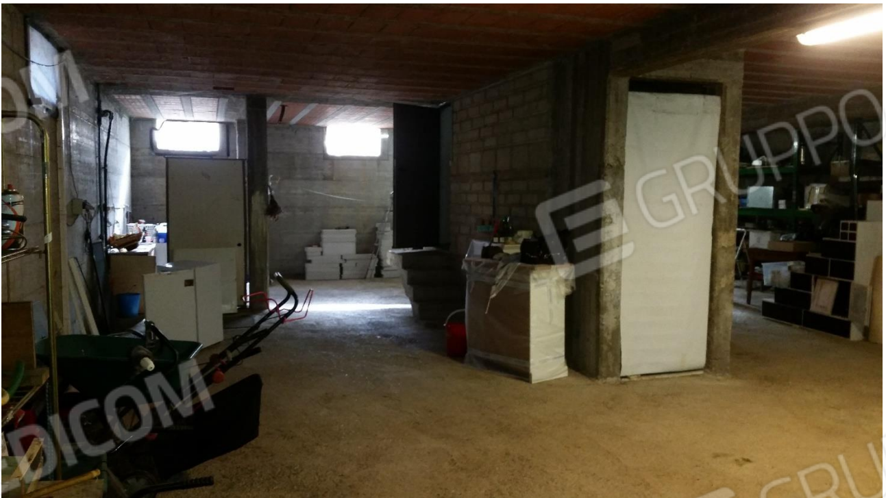
FOTO 16 VANO PIANO INTERRATO
