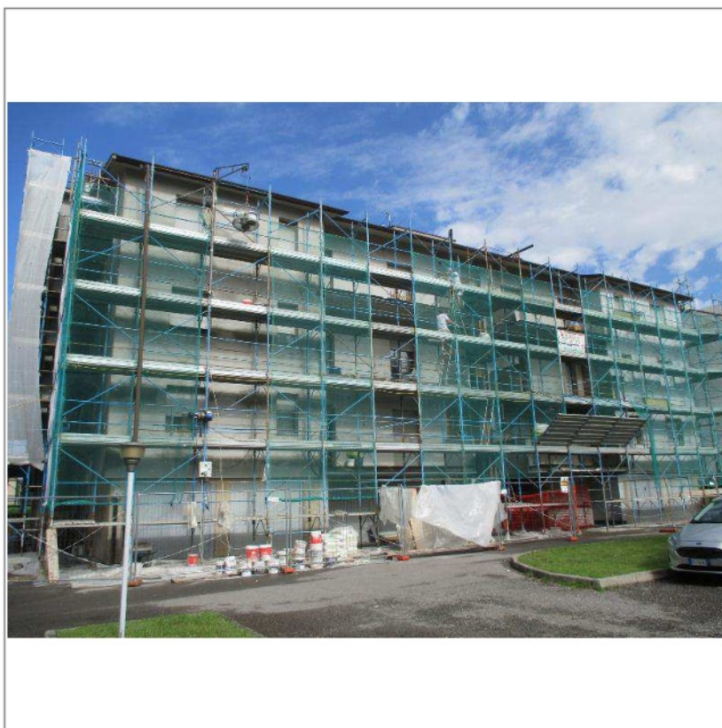
- Complesso condominiale - Fronte est -
