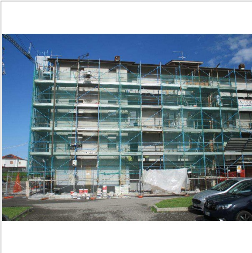
- Complesso condominiale - Fronte est -
