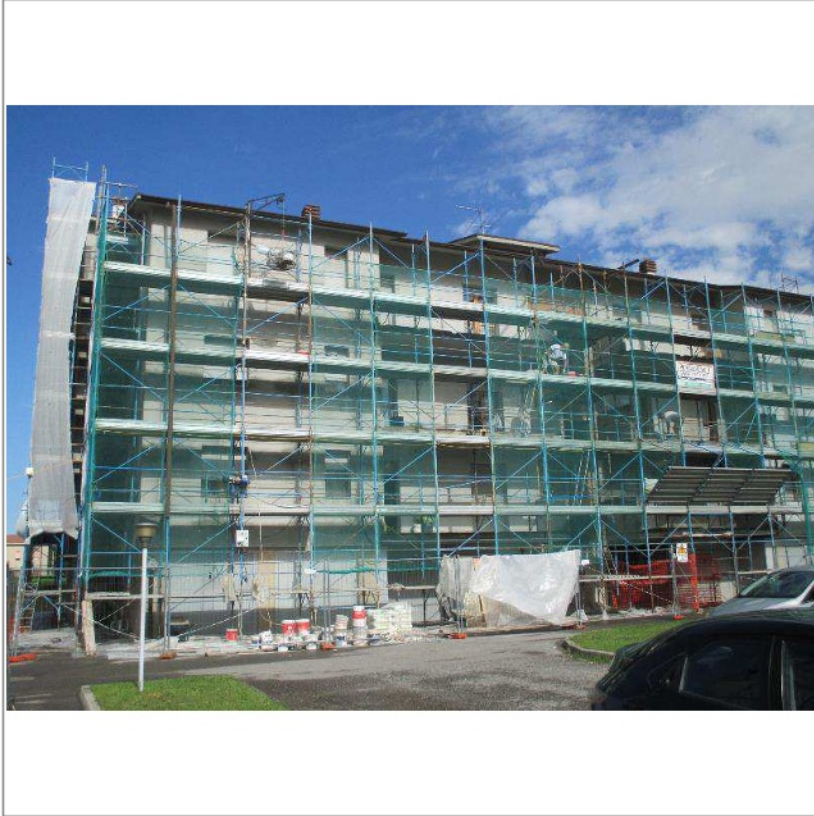
- Complesso condominiale - Fronte est -
