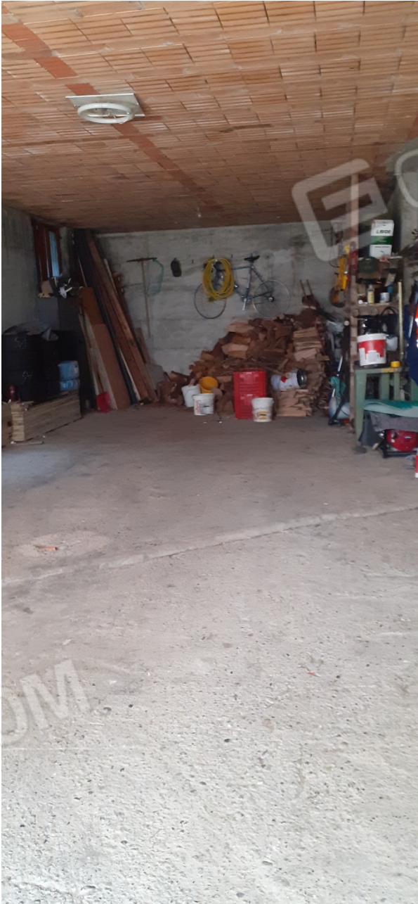
Autorimessa a piano interrato
