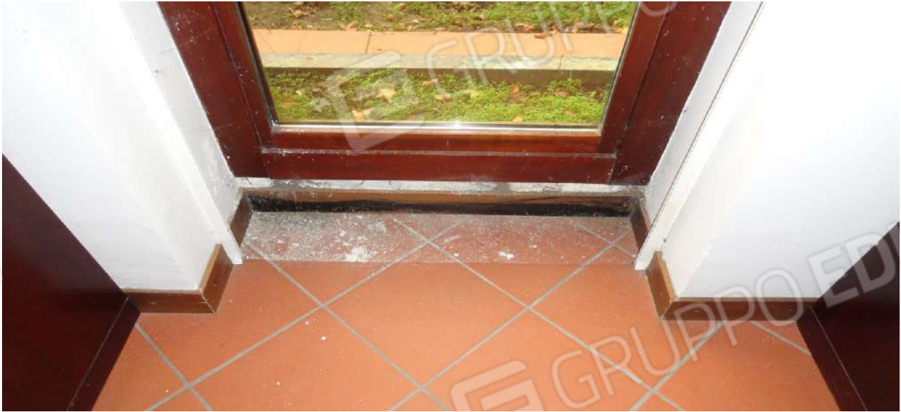
Fotografia n. 109: soglia finestra camera matrimoniale
