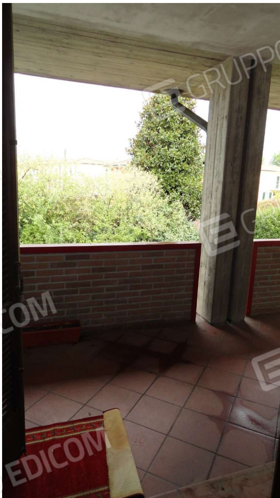
Fotografia n. 73: Particolare terrazza Piano Primo Ovest
