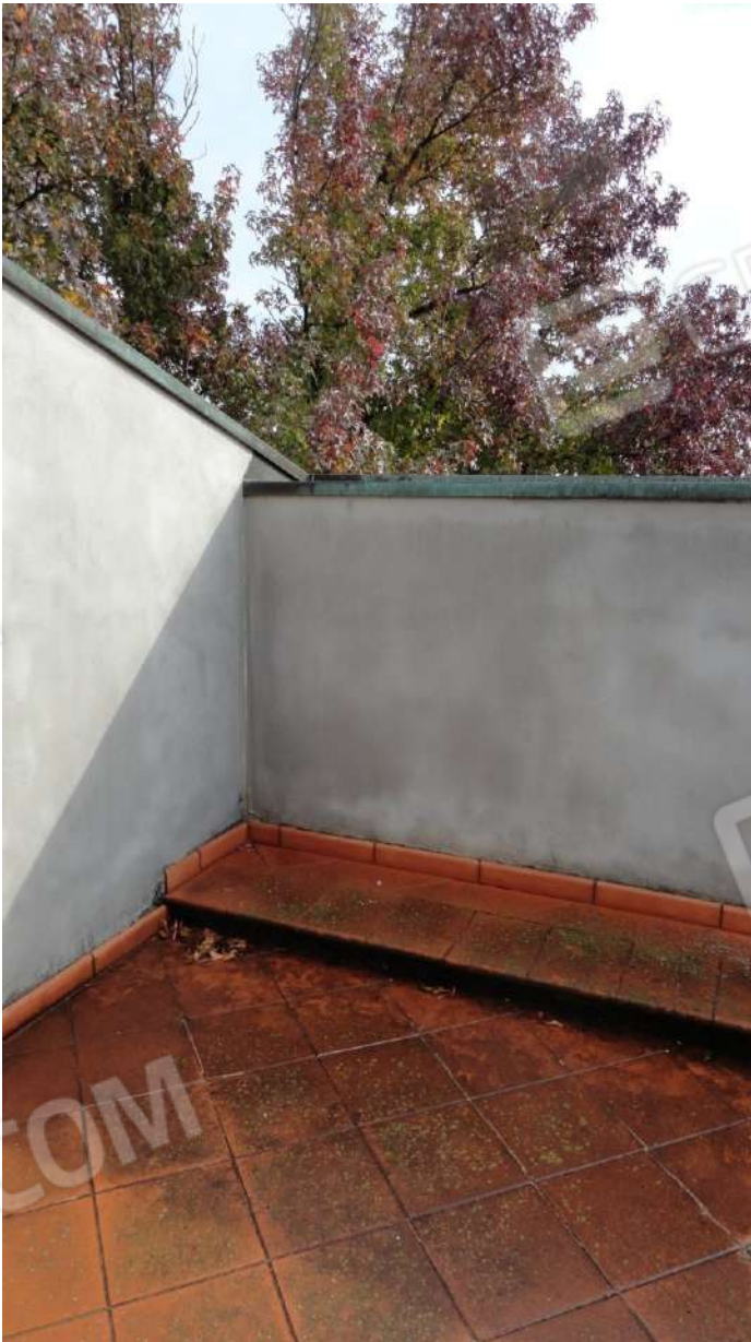
Fotografia n. 92: Particolare parapetto terrazza secondo piano / sottotetto verso nord est
