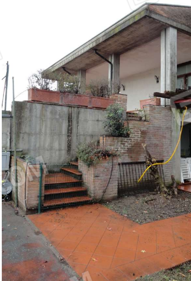
Fotografia n. 14: particolare scala a collegare il Piano Terra Nord ( subalterno 2 catastale ) al Piano Primo zona sud ( subalterno 3 catastale )
