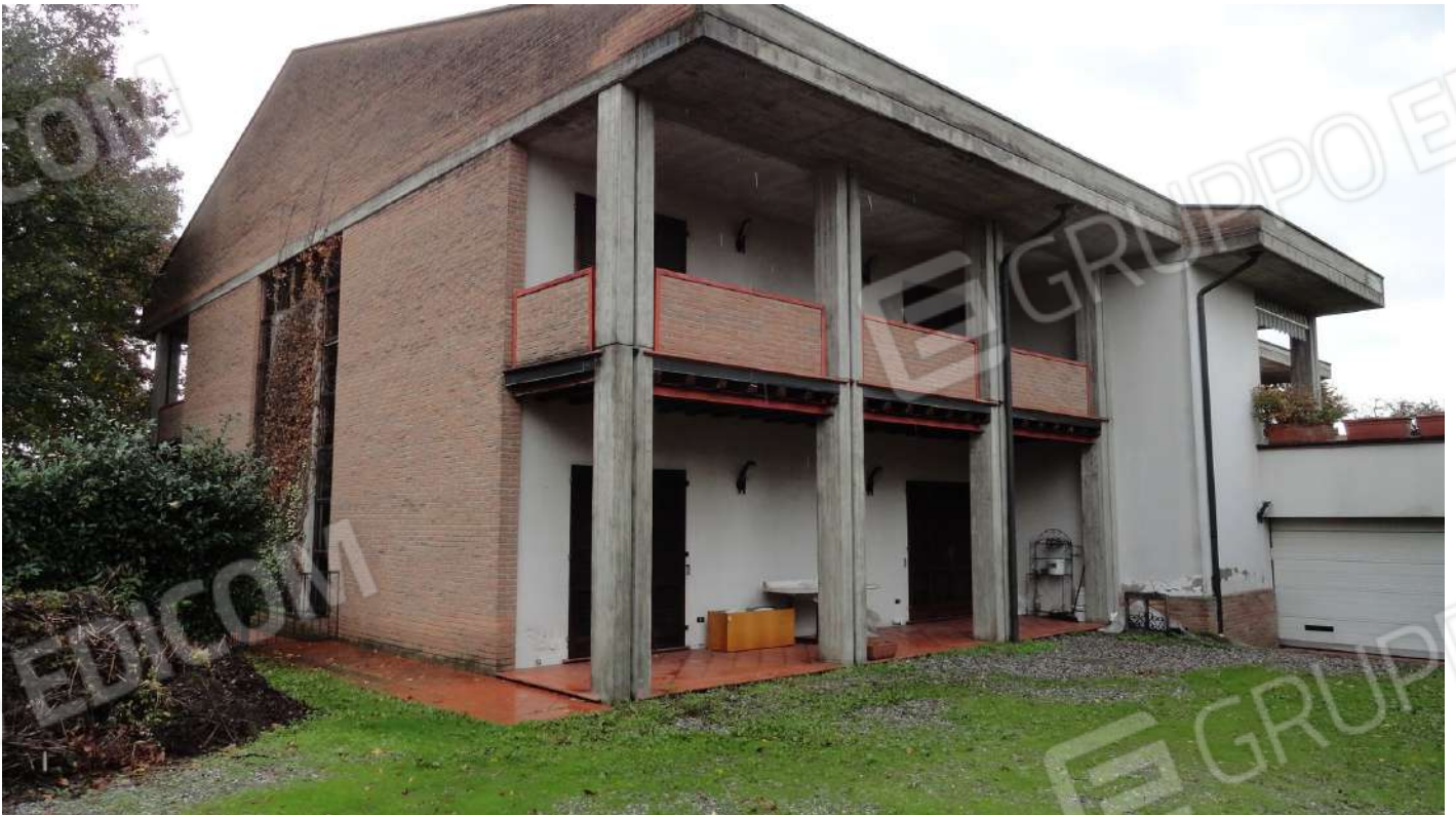
Fotografia n. 6 : fronte nord e parte ovest dell'edificio : il piano terra è l'attuale subalterno 2 catastale
