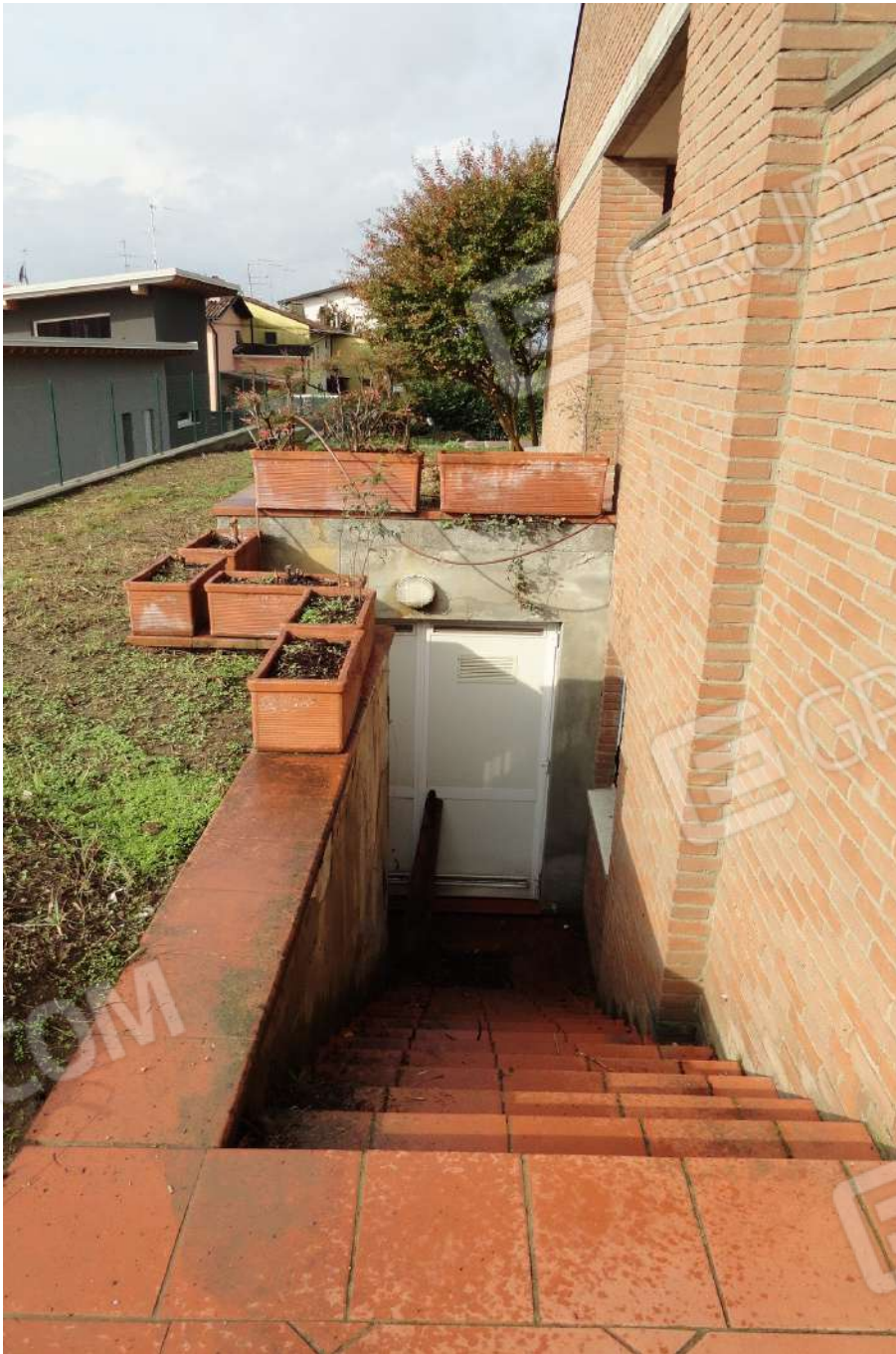
Fotografia n. 23 : lato sud accesso al locale caldaia
