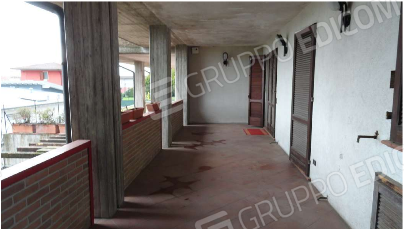
Fotografia n. 81: Terrazza coperta Nord Est Piano Primo
