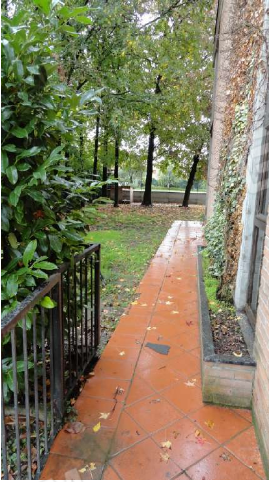
Fotografia n. 9 : marciapiede in lato nord e fioriera in aderenza all'edificio con cancellino e ringhiera a separazione
