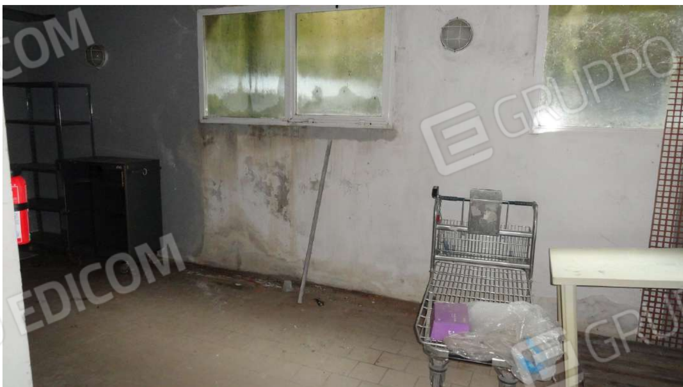
Fotografia n. 47 : Interno Garage Parete bocche di lupo sud.
