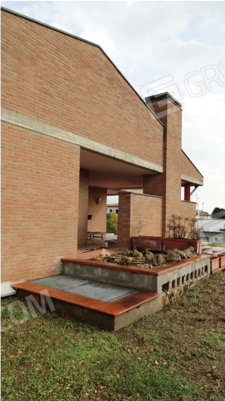
Fotografia n. 24 : lato sud copertura vano caldaia
