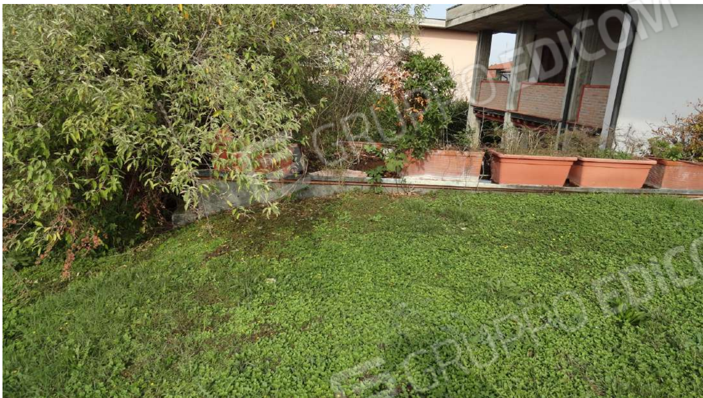
Fotografia n. 30 : muro di contenimento giardino con terra riportata al di sopra della autorimessa
