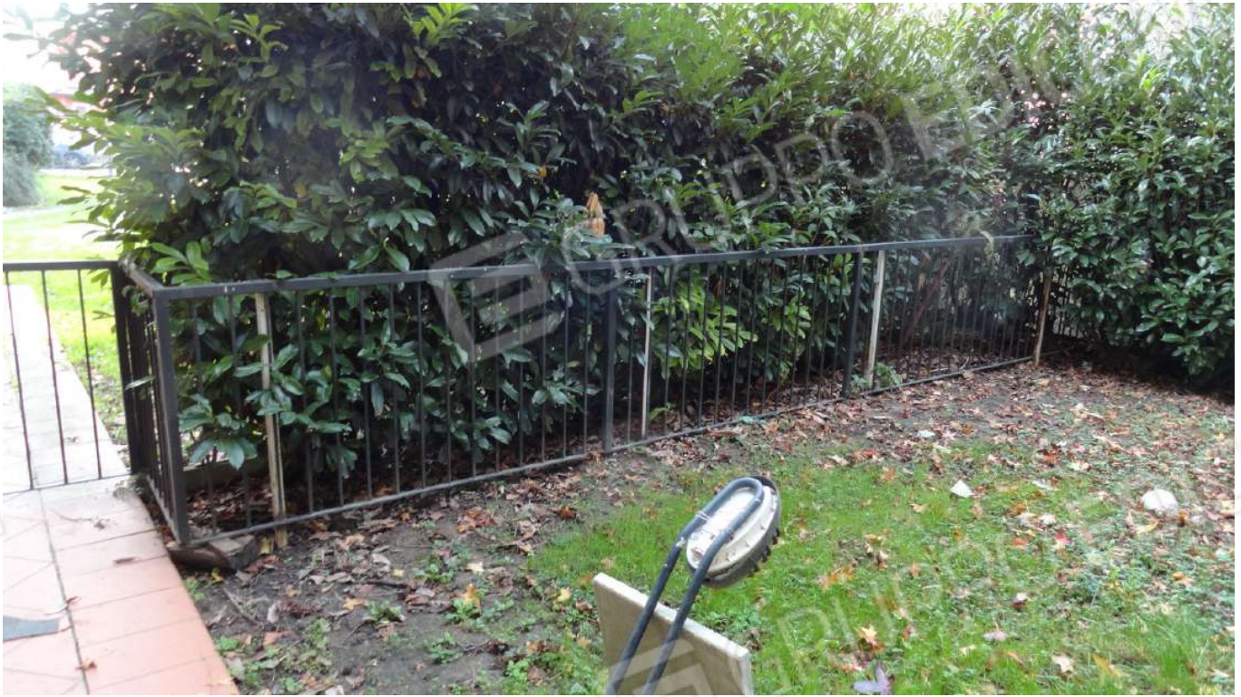
Fotografia n. 9 -bis : particolare cancellino e ringhiera a separazione
