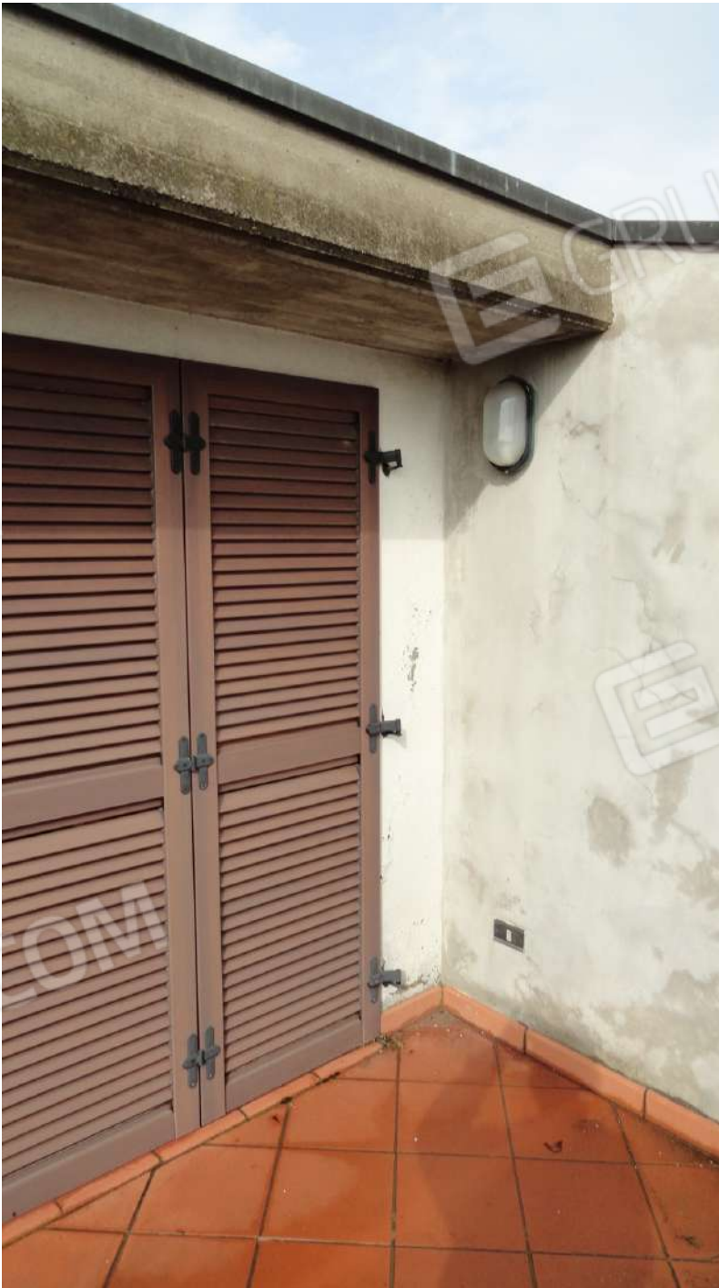
Fotografia n. 91: Particolare Gronda Copertura
