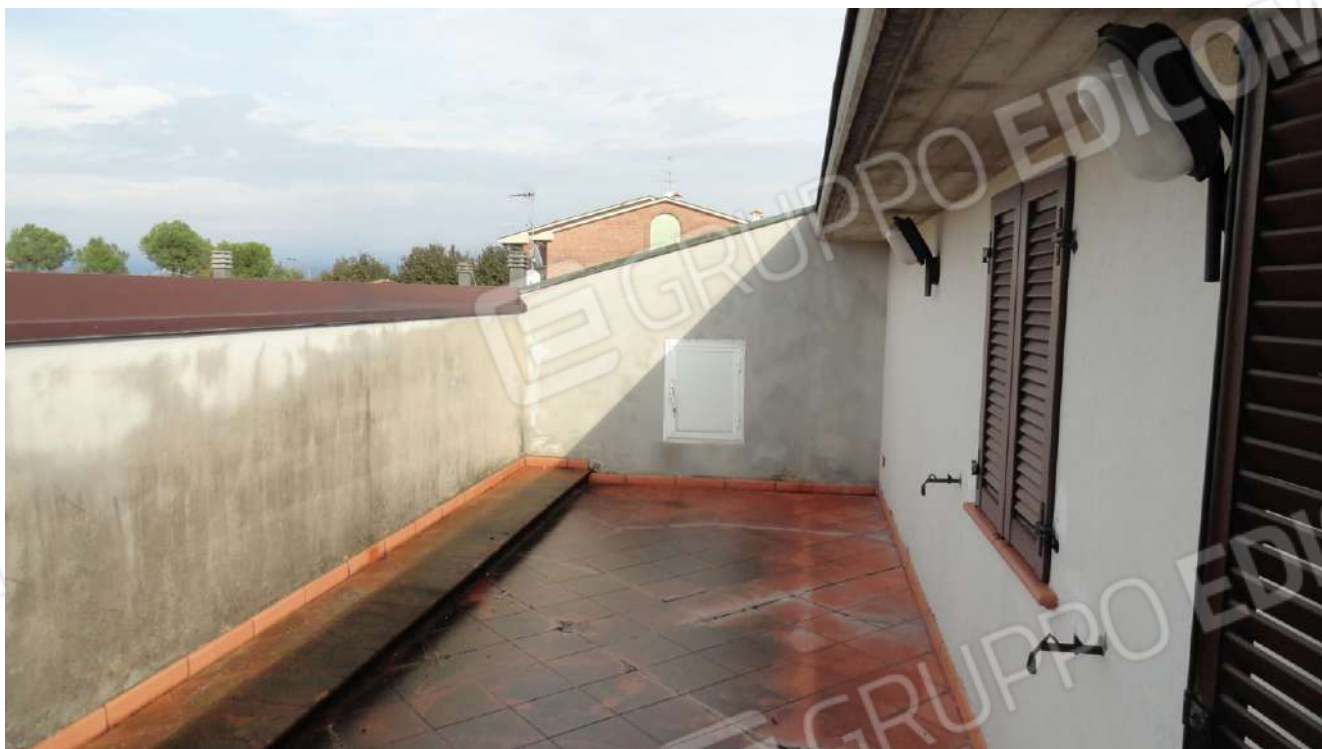
Fotografia n. 95: Particolare terrazza secondo piano / sottotetto verso nord ovest
