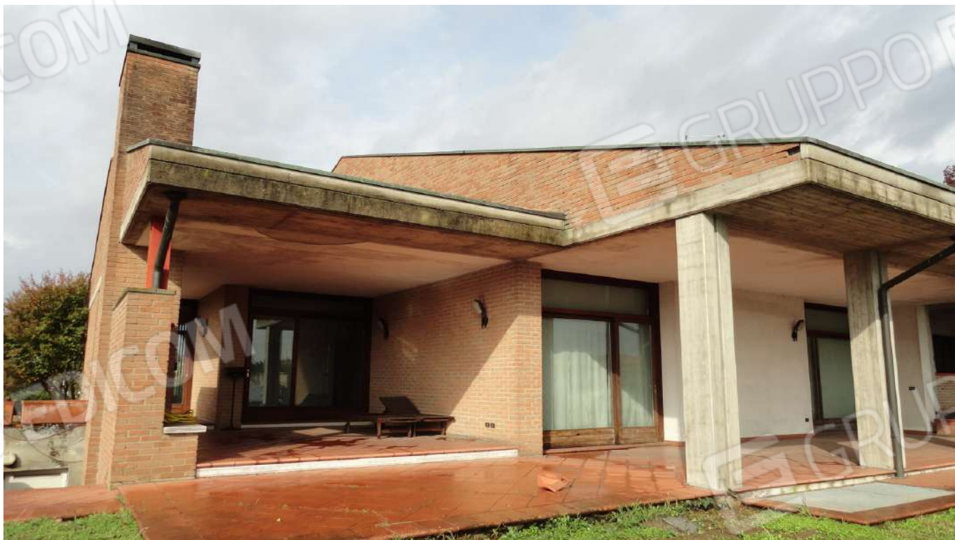
Fotografia n. 21 : vista d'insieme del lato est e lato sud di Piano Primo
