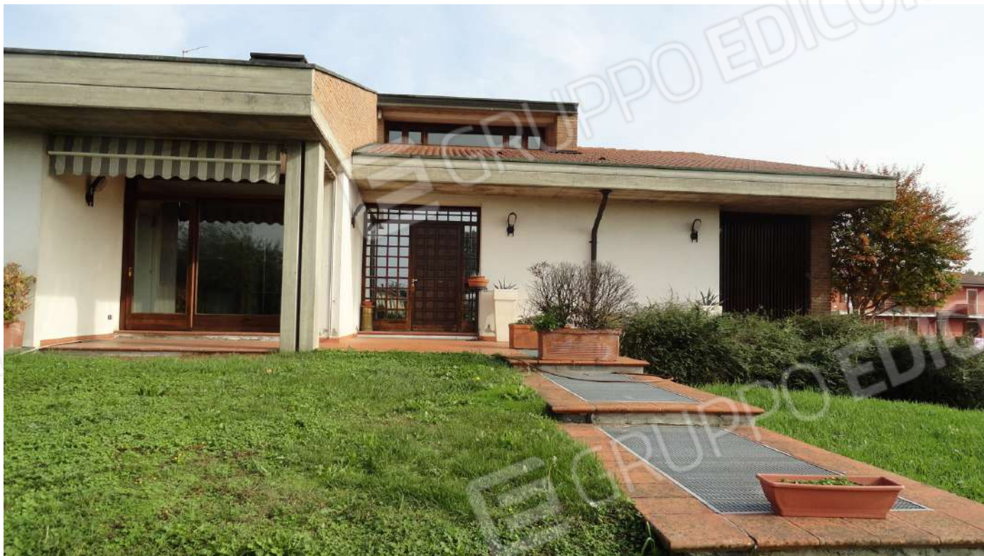
Fotografia n. 28-2 :ingresso principale dell'unità abitativa subalterno 3 e copertura bocche di lupo autorimessa
