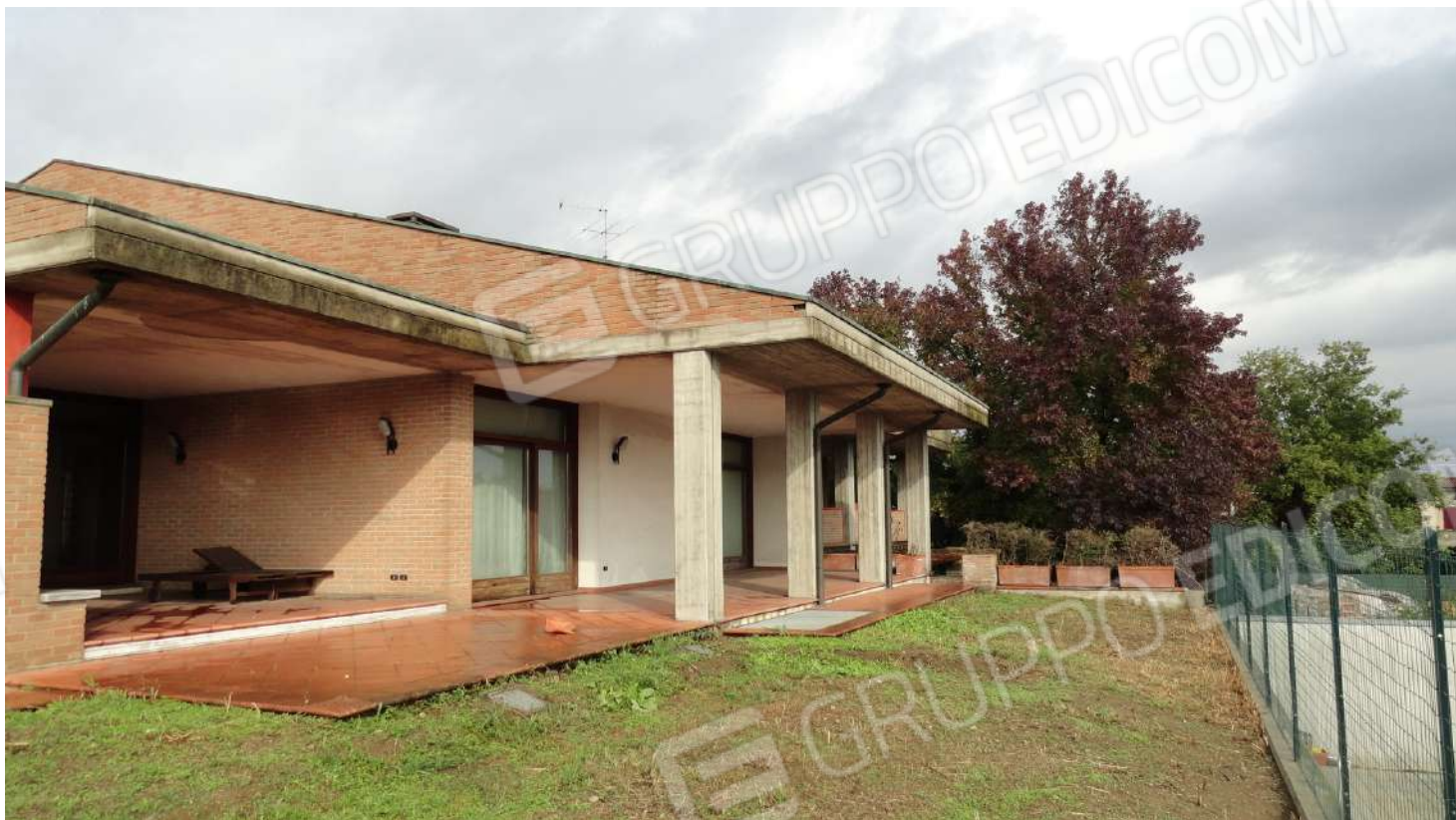
Fotografia n. 20 : vista d'insieme del lato est di Piano Primo
