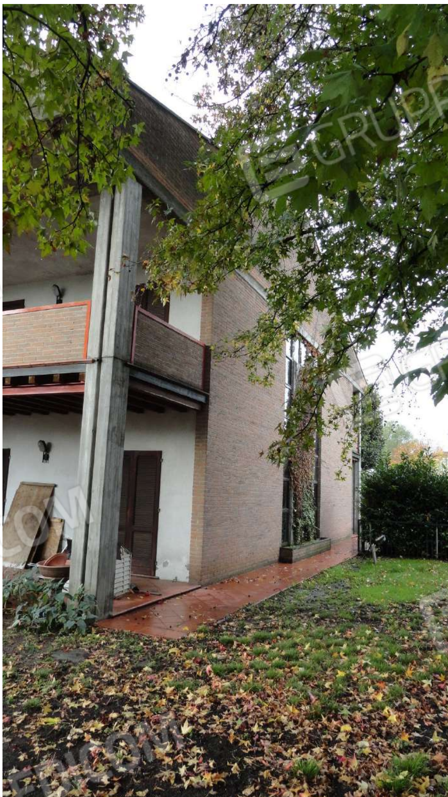
Fotografia n. 17: fronte nord e marciapiede verso l'ingresso carraio
