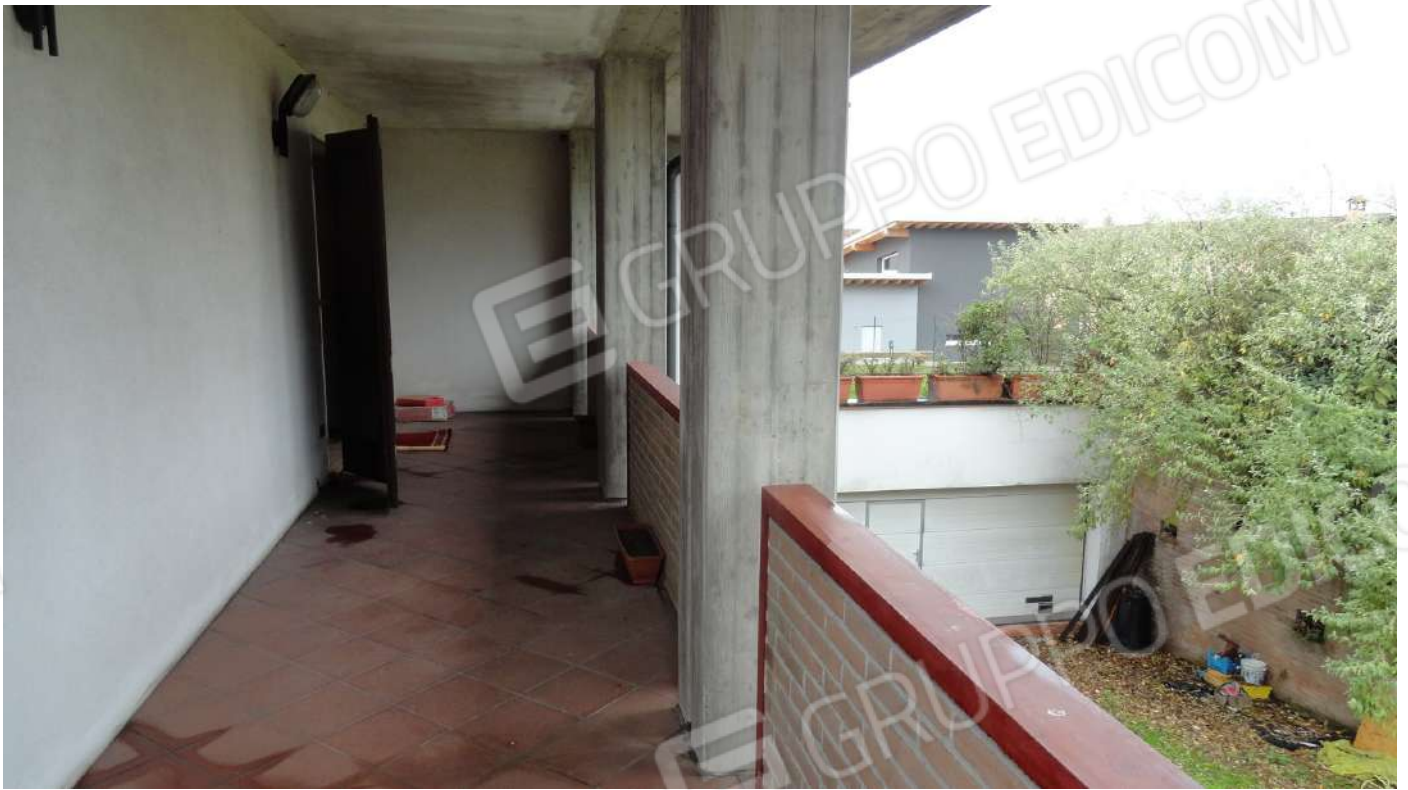
Fotografia n. 72: Terrazza coperta Piano Primo Ovest
