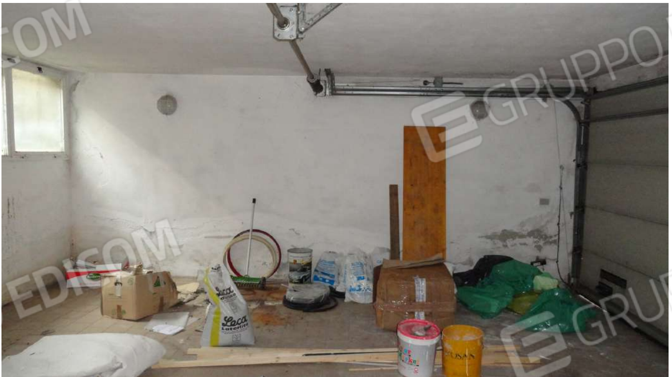
Fotografia n. 49 : Interno Garage Parete ovest.
