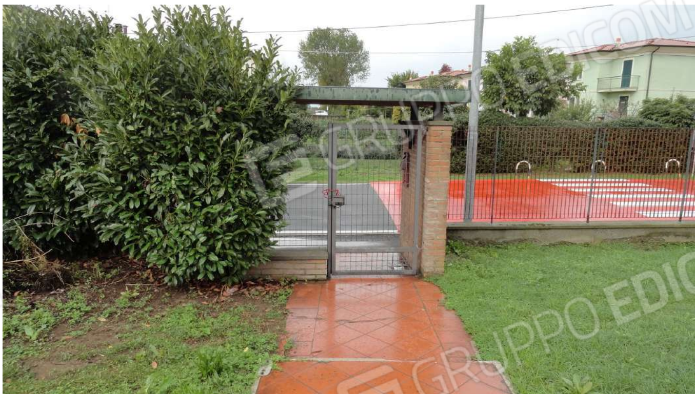
Fotografia n. 2 : ingresso pedonale interno
